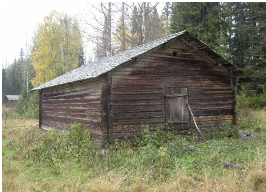
Figur 3. Sommarladugården innan renoveringen påbörjades. Foto från öster, Daniel Olsson, Länsmuseet Gävleborg 2014-10-08.
