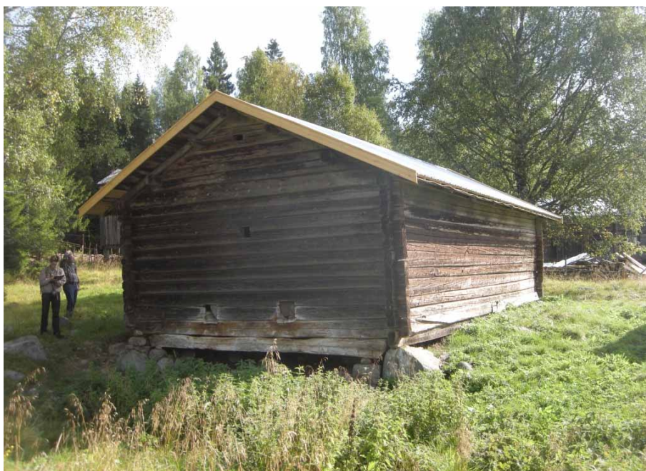
Figur 9. Sommarladugården från söder efter avslutad renovering. Foto: Daniel Olsson, Läns museet Gävleborg 2015-09-01.
