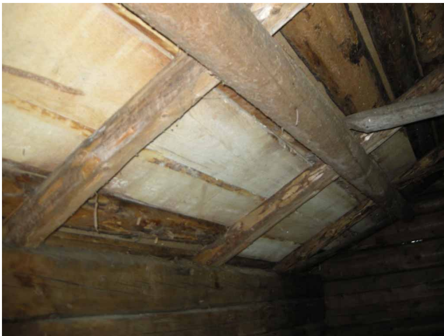
Figur 7. Detalj av utbytta trobrädor i underlagstaket. Foto: Daniel Olsson, Länsmuseet Gävleborg 2015-09-01.
