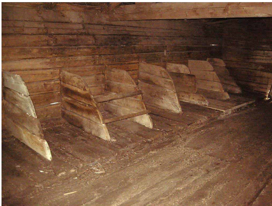
Figur 8. Merparten av båsavskiljarna längs den sydöstra väggen. De två tvärgående ribborna mellan två bås kommer att tas bort då de endast har använts för att hålla delar av båsavskiljarna på plats när byggnaden användes som färrhus. Foto från norr, Daniel Olsson, Läns museet Gävleborg 2015-09-01.
