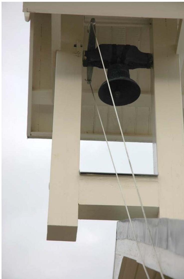
Figur 15. Detalj av klockstapeln med den yttre spirans nedersta del som ska kapas av. Foto från söder, Daniel Olsson, Läns-museet Gävleborg 2015-10-09.
