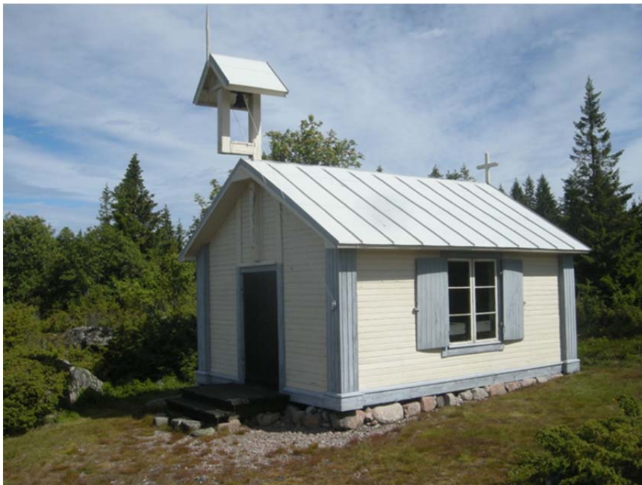
Figur 5. Kapellet innan renoveringen inleddes. Foto från sydväst, Daniel Olsson, Läns museet Gävleborg 2015-10-09.
