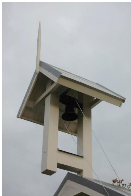
Figur 11. Klockstapeln efter renoveringen. Foto från sydväst, Daniel Olsson, Läns museet Gävleborg 2015-09-30.
