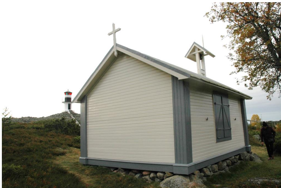
Figur 14. Kapellet från nordväst vid slutbesiktningen. Till vänster om byggnaden ses fyren på Prästgrundet. Foto: Daniel Olsson, Läns museet Gävleborg 2015-09-30.
