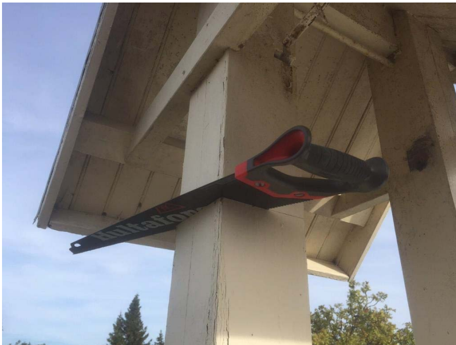
Figur 10. Avkapning av den rötskadade nedre delen av den yttre spiran under renoveringen. Foto från sydväst, Anders Burman, augusti 2015.
