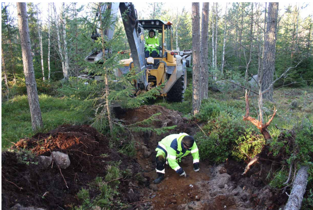
Figur 8. Schaktning vid läge P. Foto Maria Björck, taget från öster.
