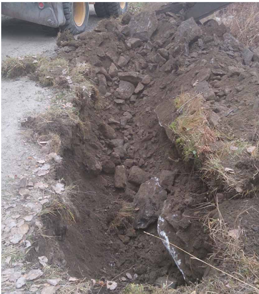
Figur 4. Schakt 2 från väster. Schakt 1–3 var likartade och innehöll huvudsakligen fyllning av sprängsten. Foto: Inga Blennå.
