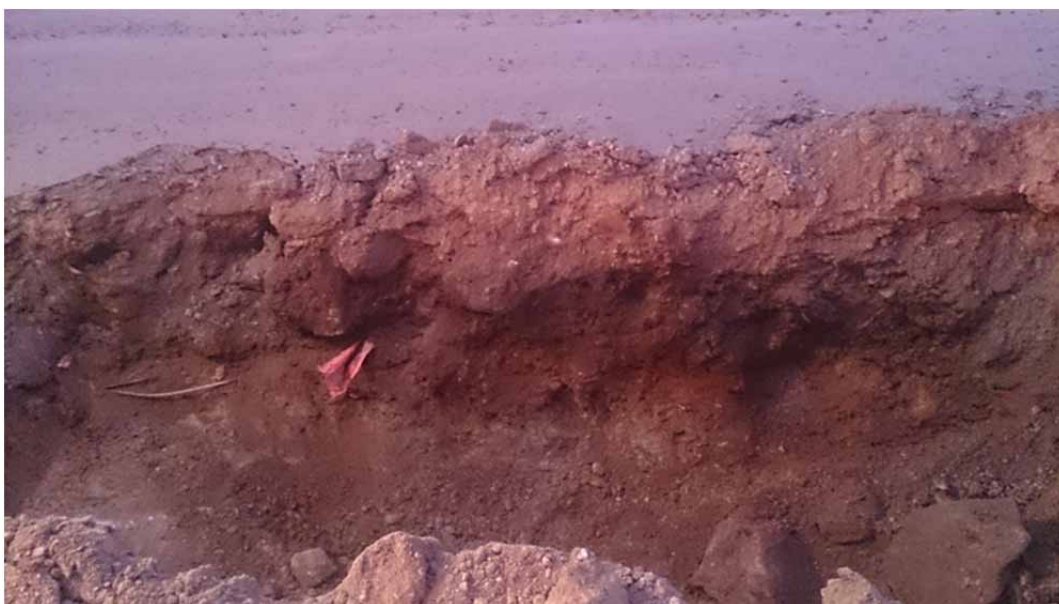
Figur 8. Norra sidan av schakt 14. Övre delen bestod av ljus- och mörkbrun mjäla. Nedre delen av rödbrun sand där en tidigare nedlagd telekabel framkom. Schaktets botten utgjordes av lera. Foto: Inga Blennå.
