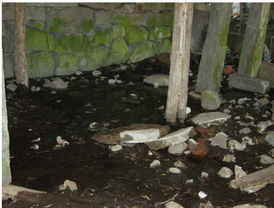
Figur 4. Detaljbild av marken under ladugården innan renoveringen inleddes. Foto från sydväst, Daniel Olsson, Läns museet Gävleborg 2009-05-29.
