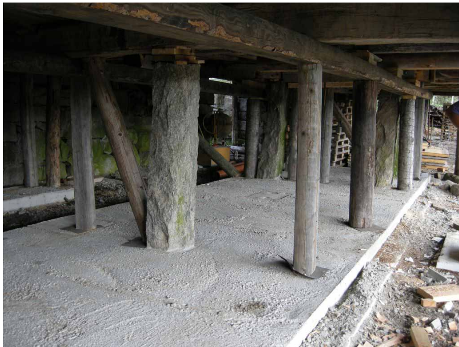
Figur 8. Den stora gjutna betongplattan under ladugårdsbyggnadens västra del. Foto från sydväst, Daniel Olsson, Läns museet Gävleborg 2009-06-30.
