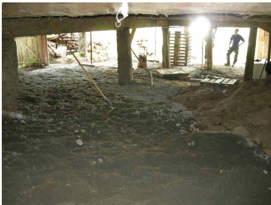
Figur 7. Marken under ladugårdsbyggnaden efter sänkning av marknivån och utbredning av grus. Foto från norr, Daniel Olsson, Läns museet Gävleborg 2009-06-30.
