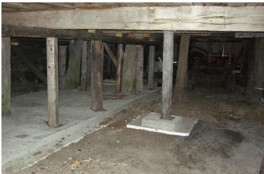
Figur 13. Detalj av utrymmet under ladugårdsbyggnaden efter gjutning av plattor och uppfyllnad med grus. Foto från sydväst, Daniel Olsson, Länsmuseet Gävleborg 2009-12-04.
