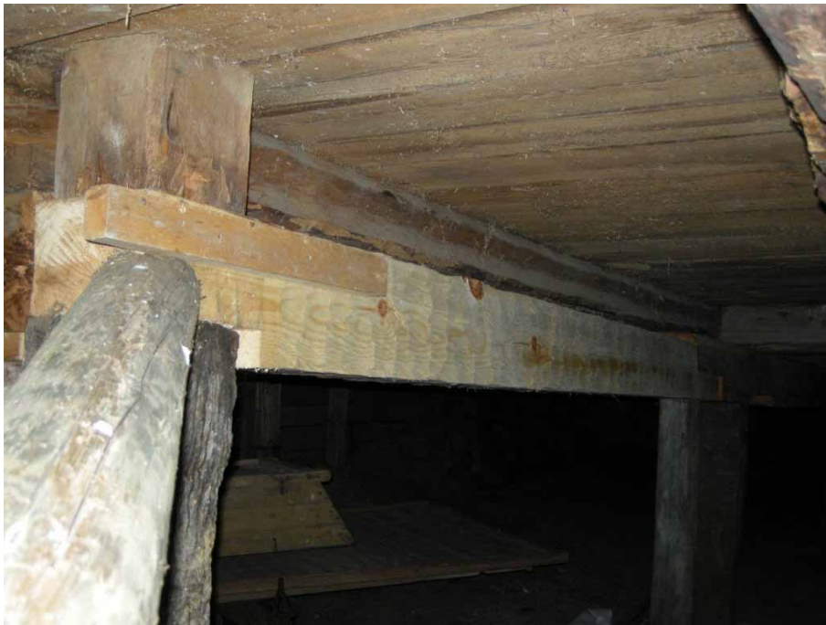
Figur 12. Detalj av ny skarvad golvvå under ladugårdsbyggnaden. Foto: Daniel Olsson, Länsmuseum Gävleborg 2009-12-04.
