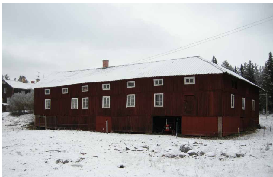
Figur 14. Ladugården efter avslutad renovering. Foto från sydöst, Daniel Olsson, Länsmuseet Gävleborg 2009-12-04.
