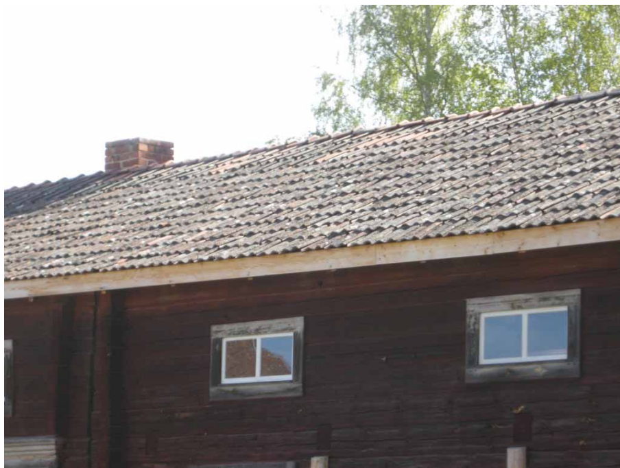
Figur 13. Detalj av ladugårdsbyggnadens nordöstra takfall efter omläggning. Foto från väster, Daniel Olsson, Läns museet Gävleborg 2011-05-09.
