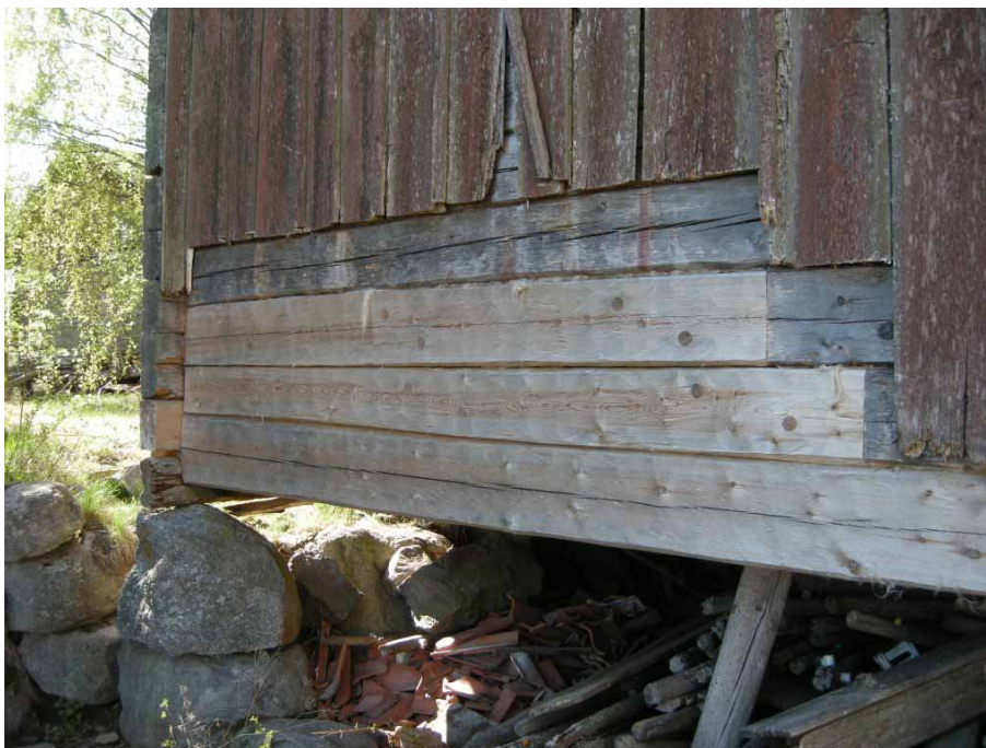
Figur 9. Detalj av den nordöstra fasaden, sida B, med timmerlaggningar utförda och avkapade panelbrädor. Foto från norr, Daniel Olsson, Läns museet Gävleborg 2011-05-09.
