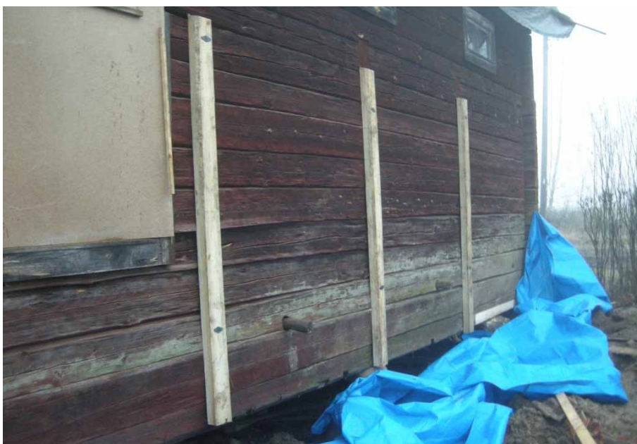
Figur 8. Detalj av ladugårdsdelens västra vägg med tre nya vertikala följare. Foto från norr, Daniel Olsson, Läns museet Gävleborg 2009-12-10.
