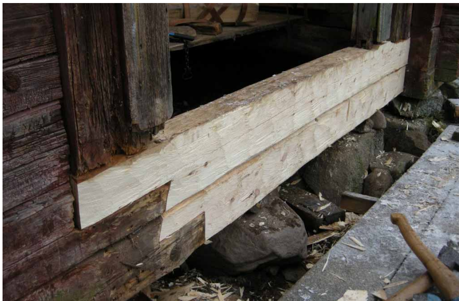
Figur 7. Detalj av utbytt del av stock A1 och A2 bakom trappan vid porten mot den västra gårdsplanen. Foto från norr, Daniel Olsson, Läns museet Gävleborg 2009-11-10.
