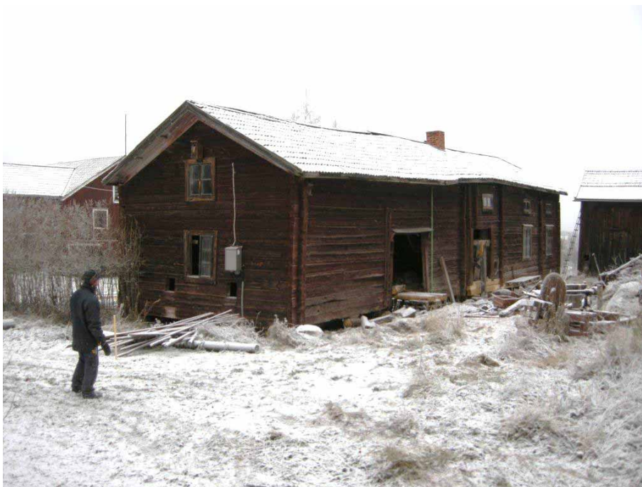
Figur 5. Daniel Åkerman vid ladugårdsbyggnaden efter att renoveringen inletts. Foto från söder, Daniel Olsson, Länsmuseet Gävleborg 2009-11-10.
