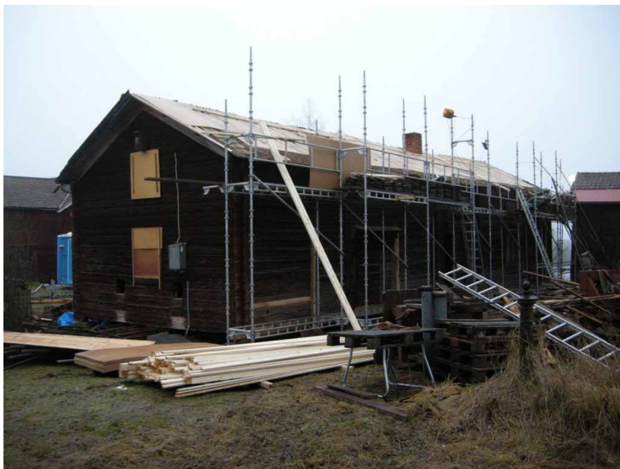
Figur 6. Ladugårdsbyggnaden från söder under renoveringen. Foto: Daniel Olsson, Läns museet Gävleborg 2009-12-10.
