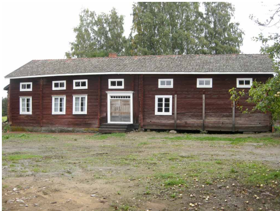
Figur 15. Ladugårdsbyggnaden efter avslutad renovering. Foto från väster, Daniel Olsson, Läns museet Gävleborg 2013-09-18.
