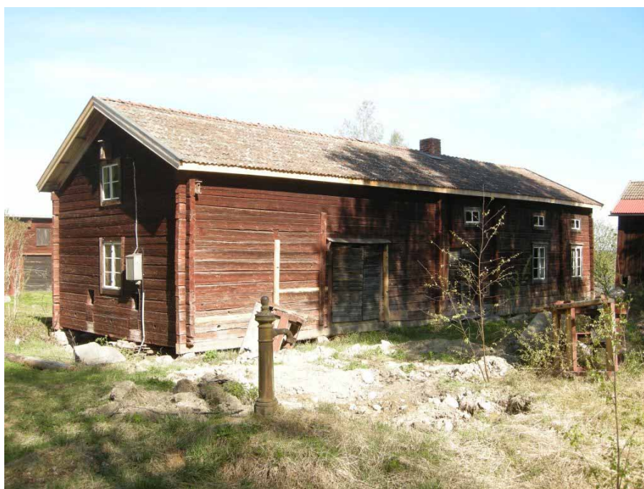
Figur 14. Ladugårdsbyggnaden efter avslutad renovering. Foto från söder, Daniel Olsson, Läns museet Gävleborg 2011-05-09.
