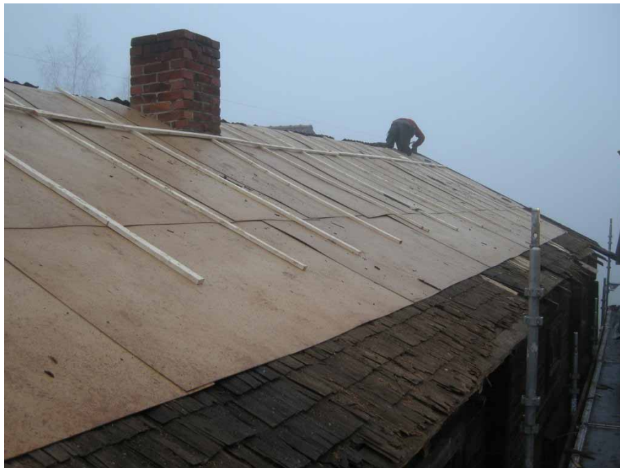
Figur 12. Det sydöstra takfallet på ladugårdsbyggnaden efter påbörjad spikning med masonit samt strö- och bärläkt. Foto från sydöst, Daniel Olsson, Läns- museet Gävleborg 2009-12-10.
