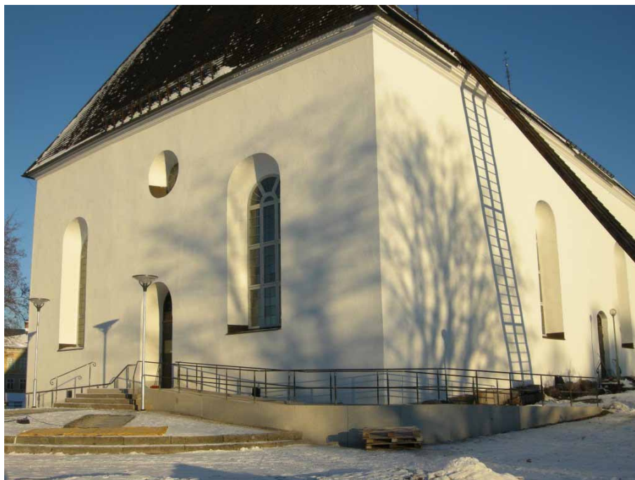
Figur 10. Rampen och de nya belysningsarmaturerna vid huvudentrén. Foto från sydväst, Daniel Olsson, Läns museet Gävleborg 2010-11-16.
