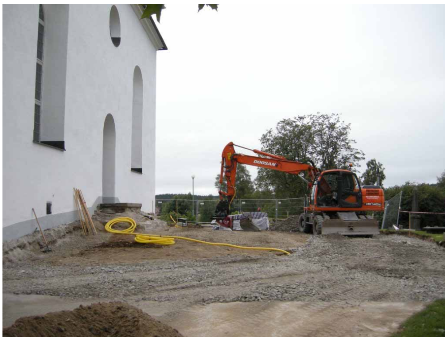
Figur 5. Ytan väster om kyrkans västra gavel efter demontering av ramp, trappa och trappstegen i halvrundeln. Foto från nordväst, Daniel Olsson, Läns museet Gävleborg 2010-08-17.
