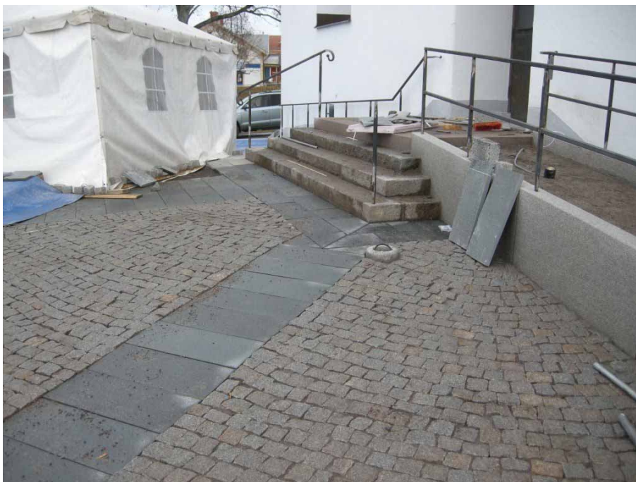
Figur 12. Detalj av stenbeläggningen med gatsten och skifferplattor väster om kyrkobyggnaden under pågående lägningsarbete. Foto från sydväst, Daniel Olsson, Läns museet Gävleborg 2010-11-03.
