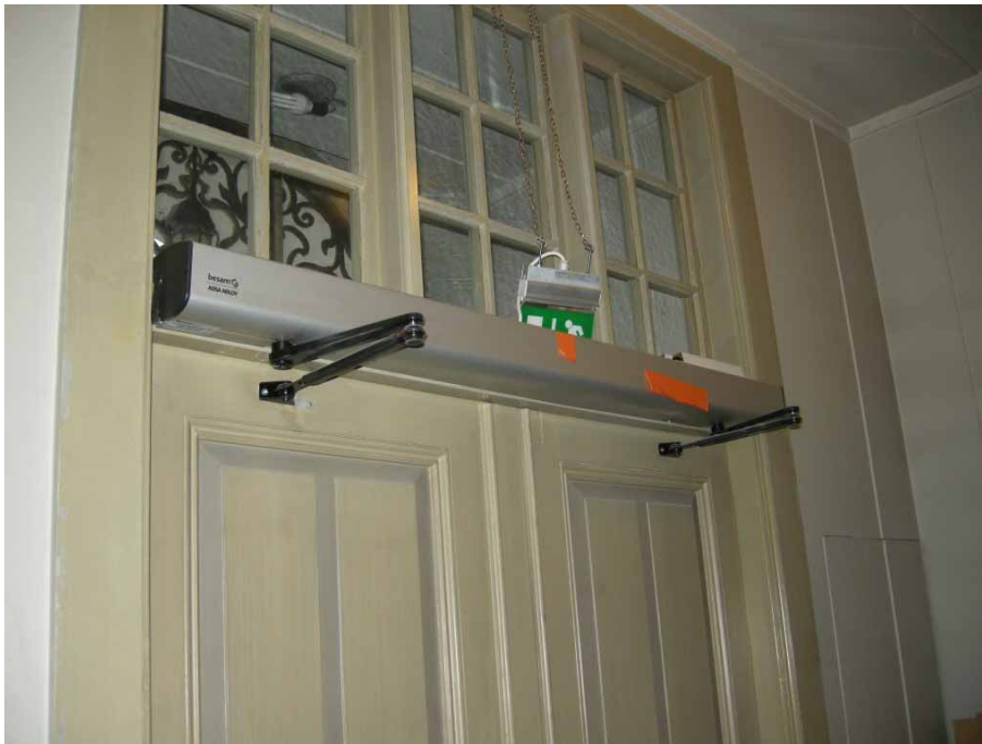
Figur 11. Detalj av pardörren mellan vindfånget och kapprummet med automatöppningskonstruktionen, delvis dold av en kåpa. Foto från sydöst, Daniel Olsson, Läns museet Gävleborg 2010-09-24.
