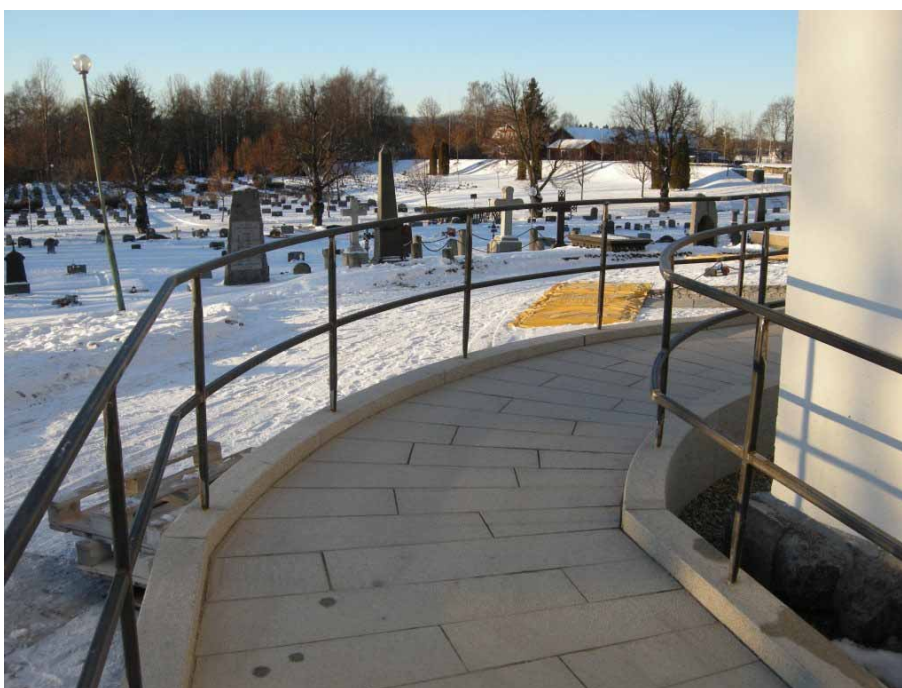
Figur 9. Rampens nedre del med tillhörande smidesräcken efter färdigställande. Foto från sydöst, Daniel Olsson, Läns museet Gävleborg 2010-11-16.
