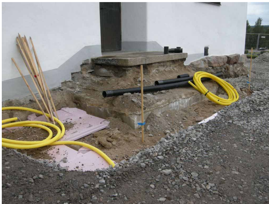
Figur 7. Detalj av området kring den blivande trappan vid kyrkans huvudentré under återfyllningsarbetet. Foto från nordväst, Daniel Olsson, Läns museet Gävleborg 2010-08-17.
