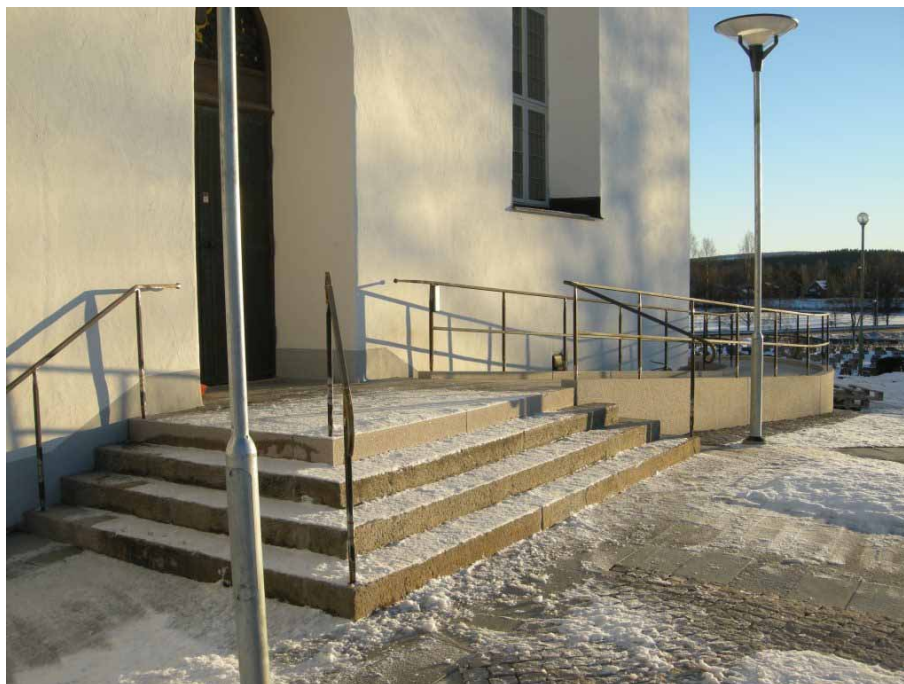
Figur 13. Trappan och rampen efter färdigställande. Foto från nordväst, Daniel Olsson, Läns museet Gävleborg 2010-11-16.
