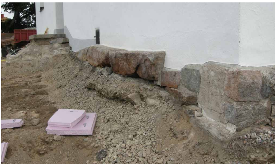
Figur 6. Detalj av de utskjutande grundstenarna från den medeltida kyrkan vid kyrkobyggnadens sydvästra hörn. Foto från sydväst, Daniel Olsson, Läns museet Gävleborg 2010-08-17.
