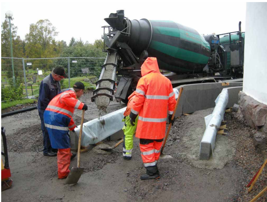
Figur 8. Fastgjutning av rampens stensidor. Foto från sydöst, Daniel Olsson, Läns museet Gävleborg 2010-09-24.
