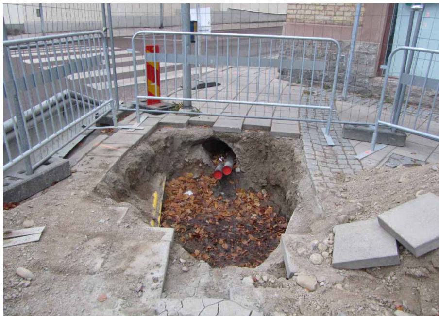
Bild 4. Schakt för borrhning under Stora Esplandgatan. Foto: Bo Ulfhielm.
