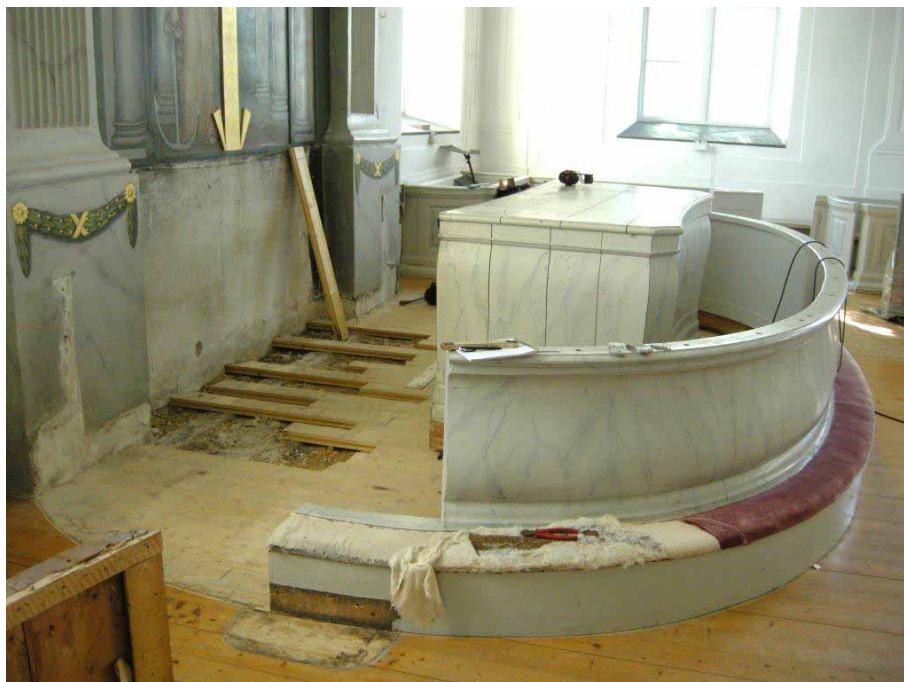
Figur 6. Altaret och altarringen under ombyggnadsarbetet. Foto från nordväst, Daniel Olsson, Läns museet Gävleborg 2009-08-12.
