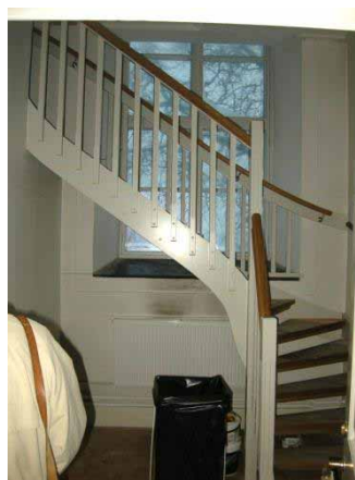
Figur 11. Den nya läktartrappan. Foto från söder, Daniel Olsson, Läns-museet Gävleborg 2009-12-15.
