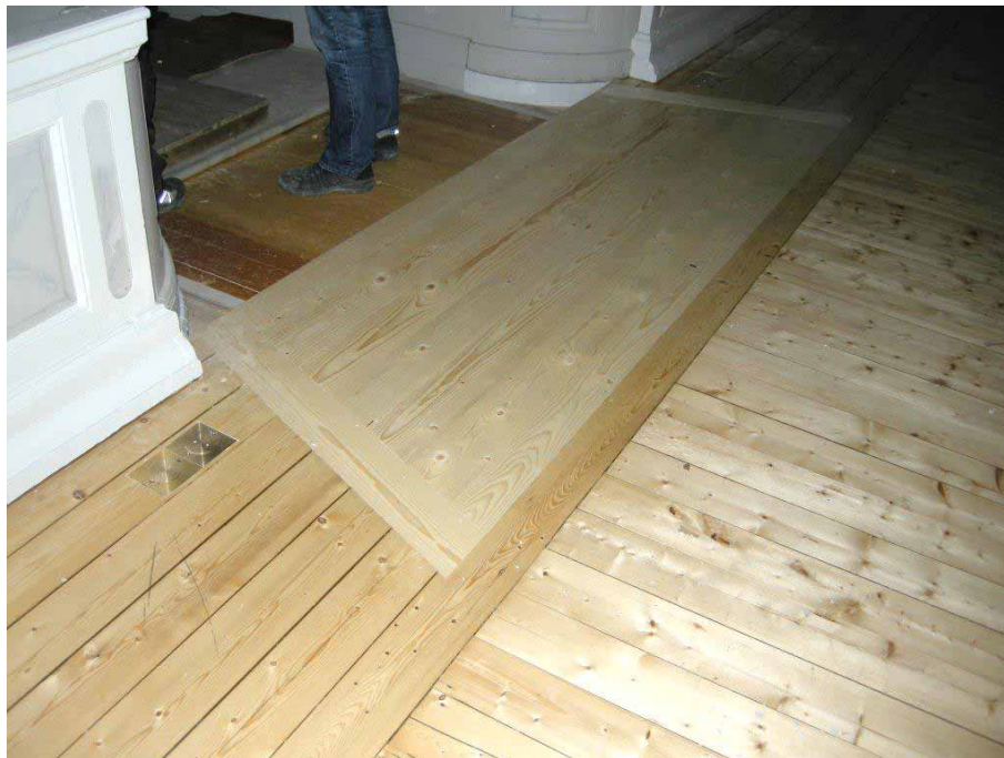
Figur 7. Detalj av trägolvet i koret närmast mittgången med snedställda frisbrädor. Foto från sydöst, Daniel Olsson, Läns museet Gävleborg 2009-11-18.
