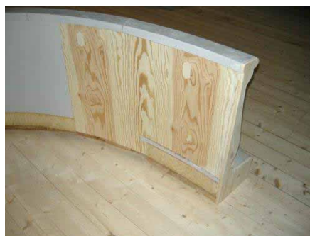
Figur 8. Detalj av altarringens norra del efter ombyggnaden. Foto från sydöst, Daniel Olsson, Läns museet Gävleborg 2009-10-21.
