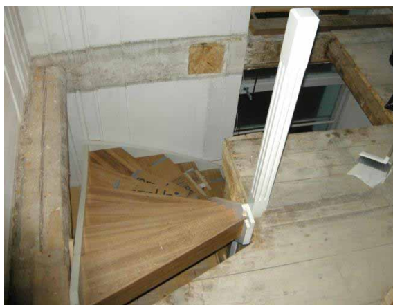
Figur 10. Håltagningen för den nya läktartrappan. Foto från söder, Daniel Olsson. Läns-museet Gävleborg 2009-11-18.
