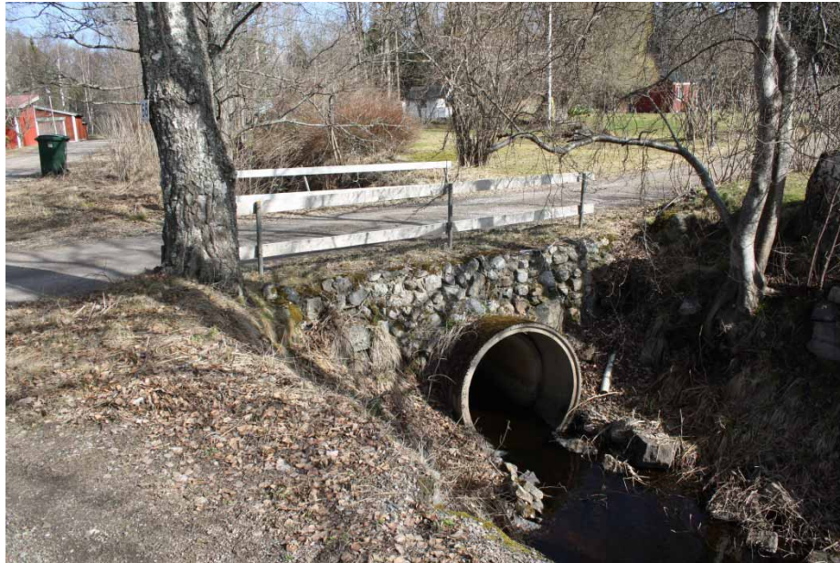
Figur 10. Stensatt bro, länsmuseet anser att efter schaktöppning i denna bör bron återställas i möjligaste mån. Foto: Maria Björck.
