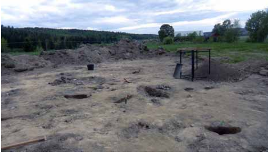
Figur 31. Översiktsbild över boplatssyta 2. I bakgrunden till vänster syns slutningen ned mot Hornån. I hörnet av schaktet, strax till höger om bildens mitt, påträffades ett par större stolphål vilka tolkades som hål till takbärande stolpar i ett större hus. Foto: Katarina Eriksson.
