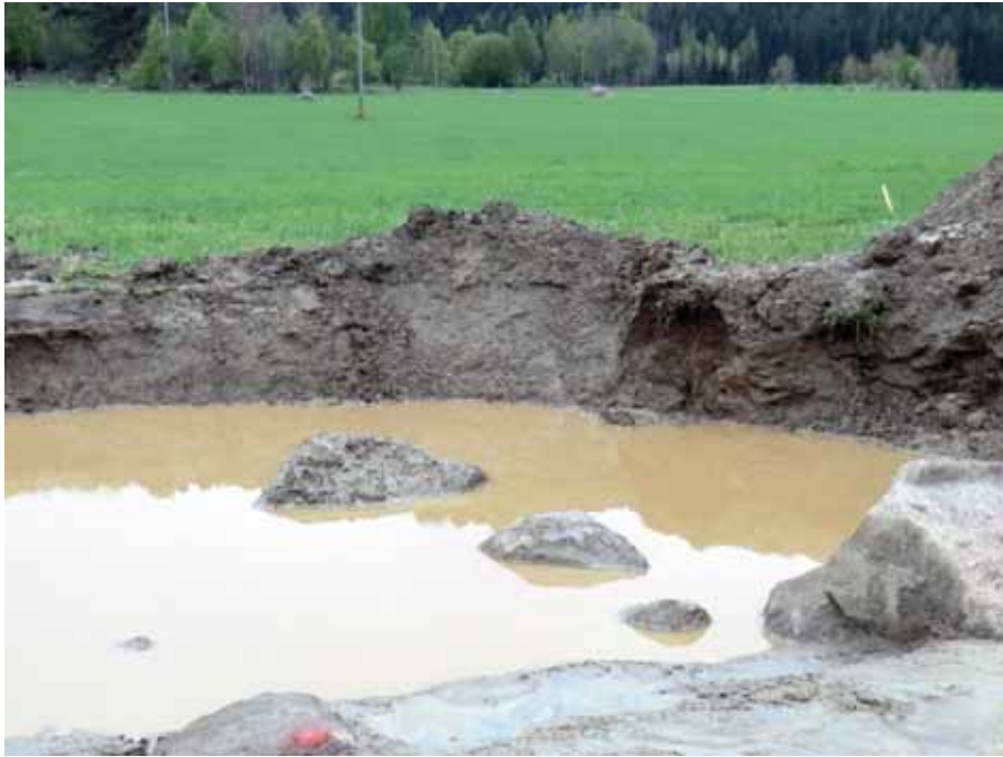
Figur 20. I samband med ett långvarigt och häftigt skyfall vattenfylldes hela schaktet och måste tömmas med hjälp av traktorgravaren. Detta försvårade undersökningen avsevärt. Foto: Katarina Eriksson.
