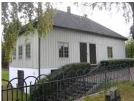
Figur 11. Den äldre ekonomibygnaden från nordväst. Foto: Daniel Olsson, Länsmuseet Gävleborg 2014-09-12.
