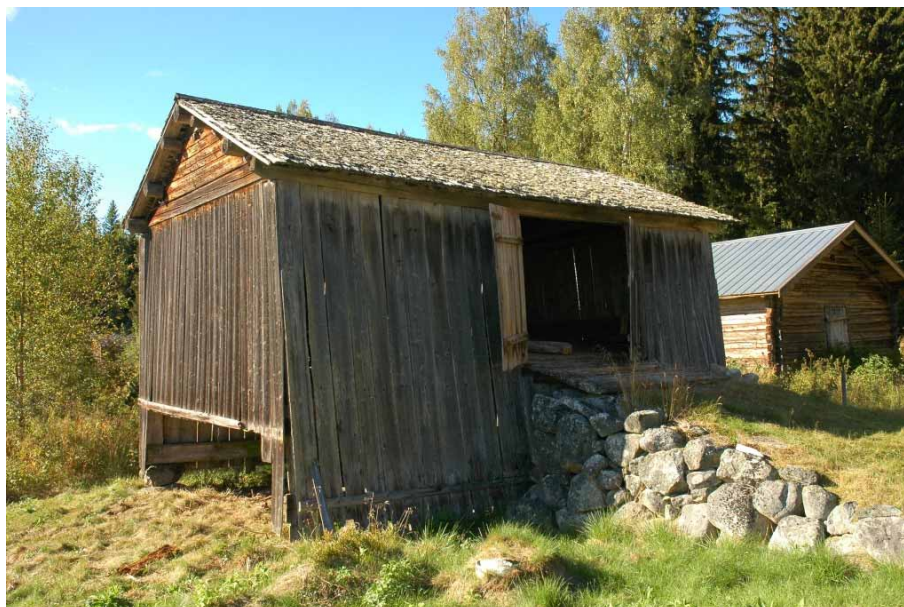
Figur 8. Vagnslidret från sydväst, före renoveringen. Foto: Daniel Olsson, Länsmuseum Gävleborg 2016-08-23.
