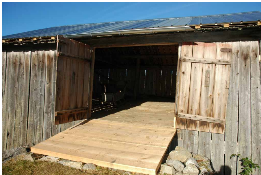
Figur 14. Vagnslidret från öster efter tillverkning av ny körbrygga av trä samt byte av takmaterial. Foto: Daniel Olsson, Läns museet Gävleborg 2016-09-12.
