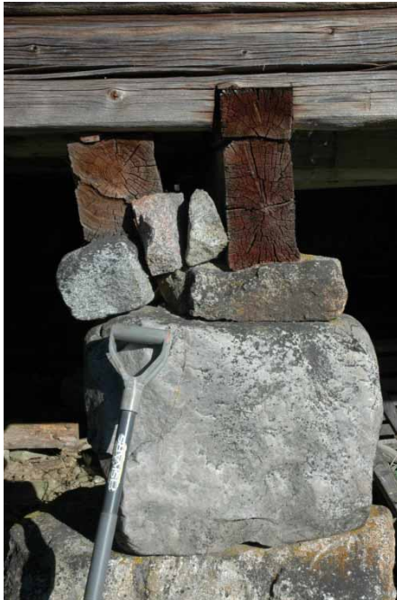
Figur 11. Detalj av bärande åsar och stenpelare under stallbyggnadens västra fasad. Foto: Daniel Olsson, Läns museet Gävleborg 2016-08-23.
