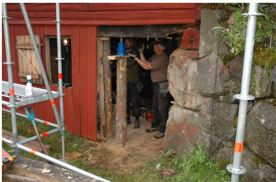
Figur 11. Lyftning av stommen intill byggnadens nordöstra hörn. Foto: Daniel Olsson, Läns museet Gävleborg 2016-07-10.
