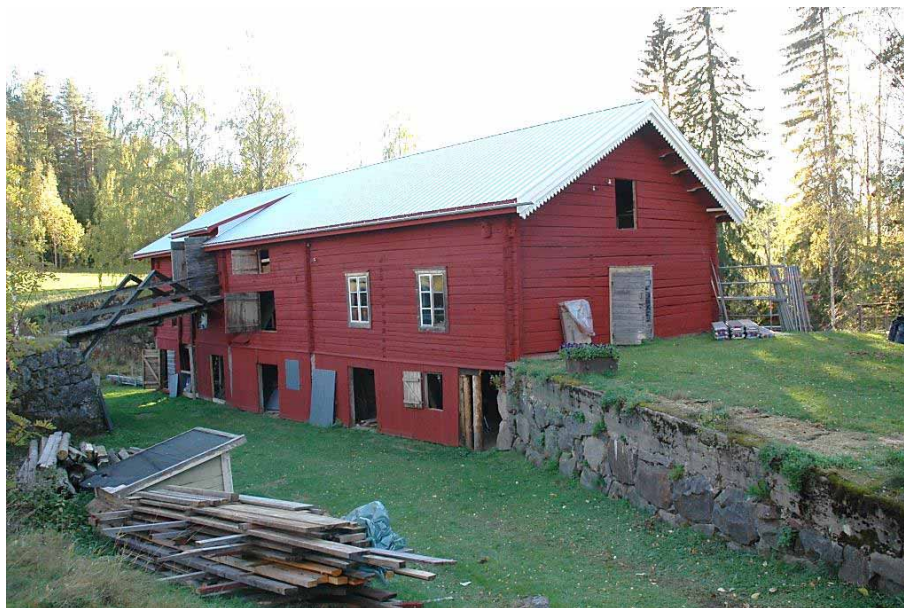
Figur 12. Kombinationsbyggnaden från nordöst efter avslutad takrenovering. Arbetet med komplettering av luckor och portar pågick ännu vid slutbesiktningen. Foto: Daniel Olsson, Länsmuseet Gävleborg 2016-09-30.
