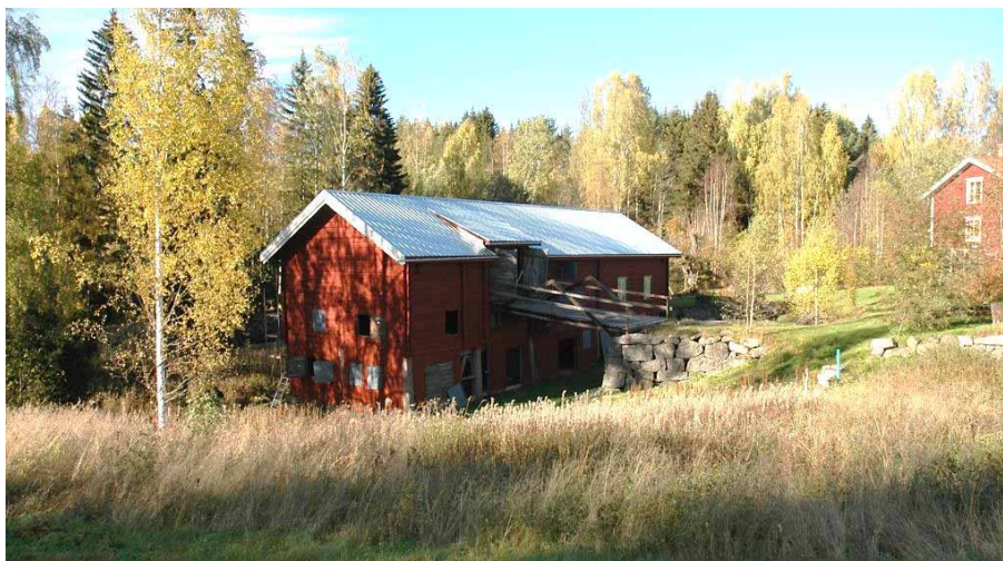
Figur 2. Kombinationsbyggnaden vid Lumpå kvarn från sydöst efter avslutad takrenovering. Foto: Daniel Olsson, Läns museet Gävleborg 2016-09-30.
