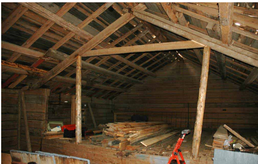
Figur 10. Vindsvåningens södra del från sydöst med två nya stöttor under en av takstolarna. Foto: Daniel Olsson, Läns museet Gävleborg 2016-07-11.
