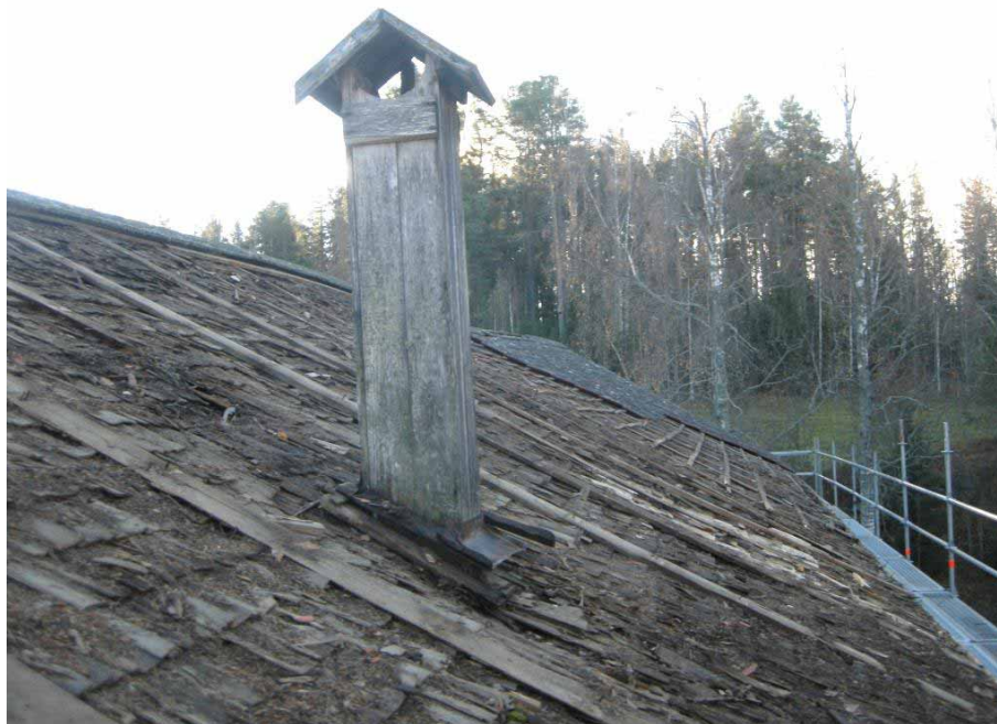
Figur 8. Det västra takfallet från nordväst under pågående avplockning av tegeltaket. I förgrunden ses ventilationsskorstenen ovanför kvarndelen i byggnaden. Foto: Daniel Olsson, Läns museet Gävleborg 2015-10-27.
