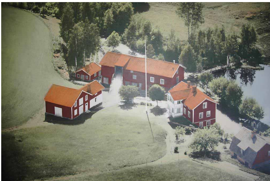
Figur 3. Bebyggelsen vid Lumpå kvarn på ett färglagt flygfoto från 1950-talet. Från vänster ses ladugården, den äldre smedjan, kombinationsbyggnaden, bostadshuset och den nyare smedjan. Flygfotot, som här är något beskuret, finns hos fastighetsägarna.
