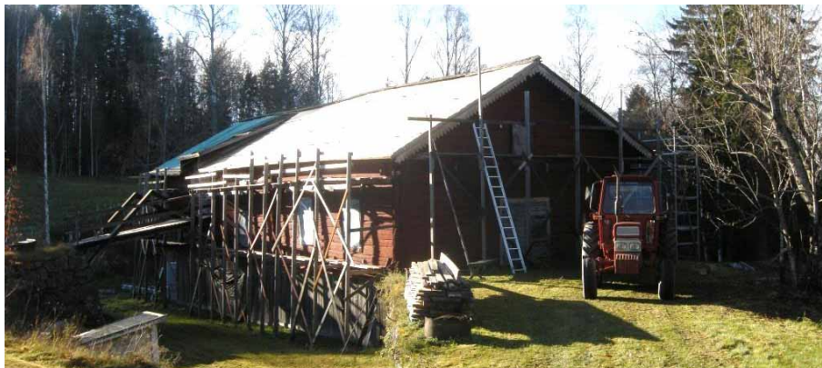
Figur 7. Kombinationsbyggnaden från nordöst under pågående takrenovering. Foto: Daniel Olsson, Länsmuseet Gävleborg 2015-10-27.
