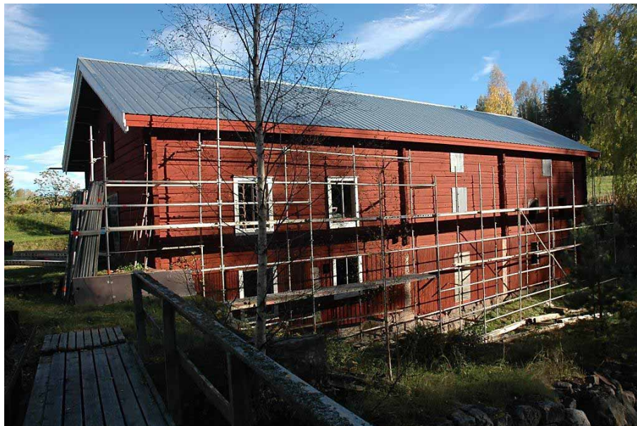
Figur 9. Kombinationsbyggnaden från nordväst efter avslutad takrenovering och målning av byggnaden. Foto: Daniel Olsson, Läns museet Gävleborg 2016-09-30.
