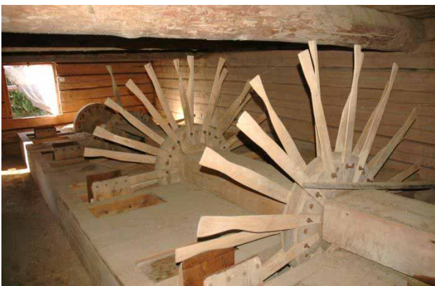
Figur 5. Interiör från linskäkten med de ursprungliga fyra skäktsvärmarna. Foto: Daniel Olsson, Läns museet Gävleborg 2016-09-30.
