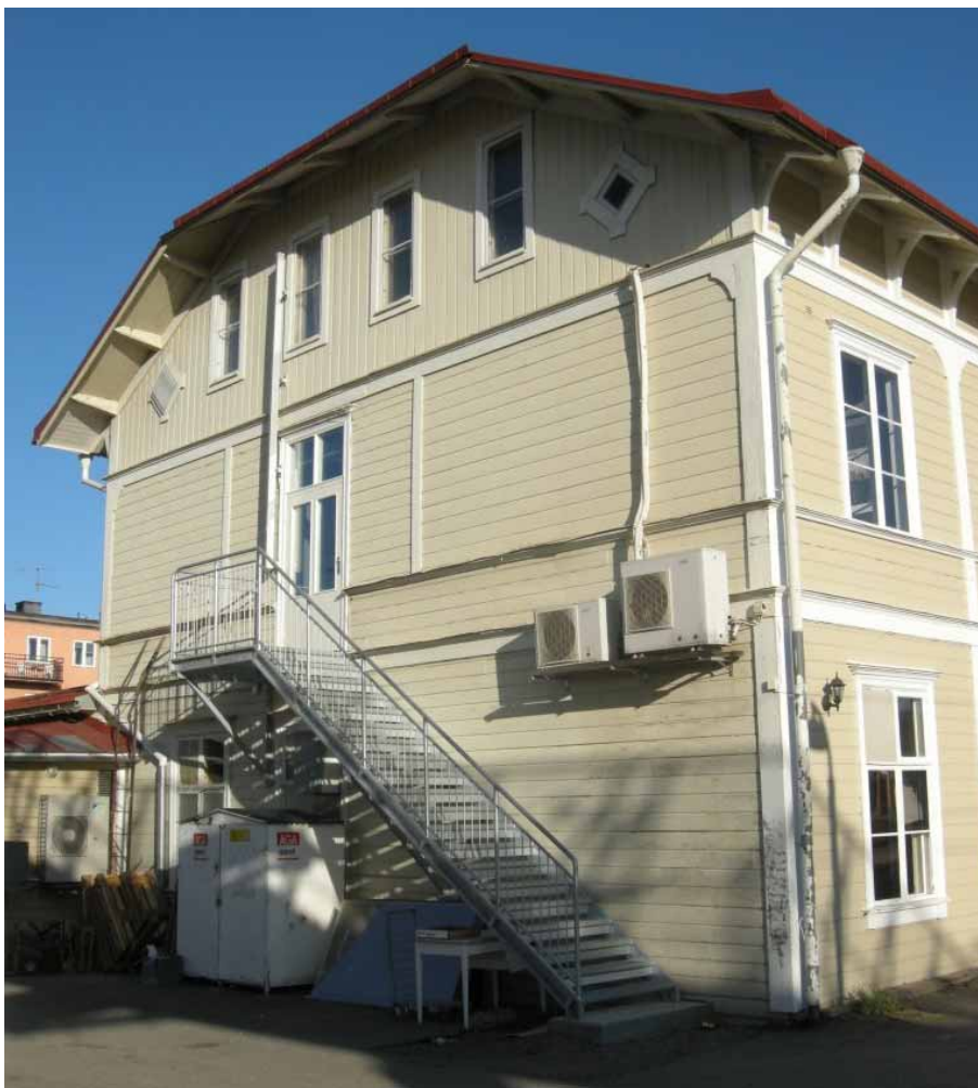
Figur 16. Den nya utrymningstrappan och utrymningsdörren på andra våningen från väster. Foto: Daniel Olsson, Läns museet Gävleborg 2014-10-01.
