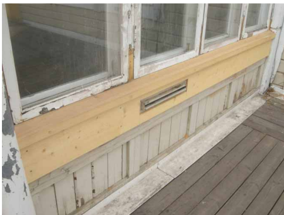
Figur 16. Detalj av renoverat träparti under glasverandans nordöstra del. Foto från öster. Foto: Daniel Olsson, Läns museet Gävleborg 2014-05-22.
