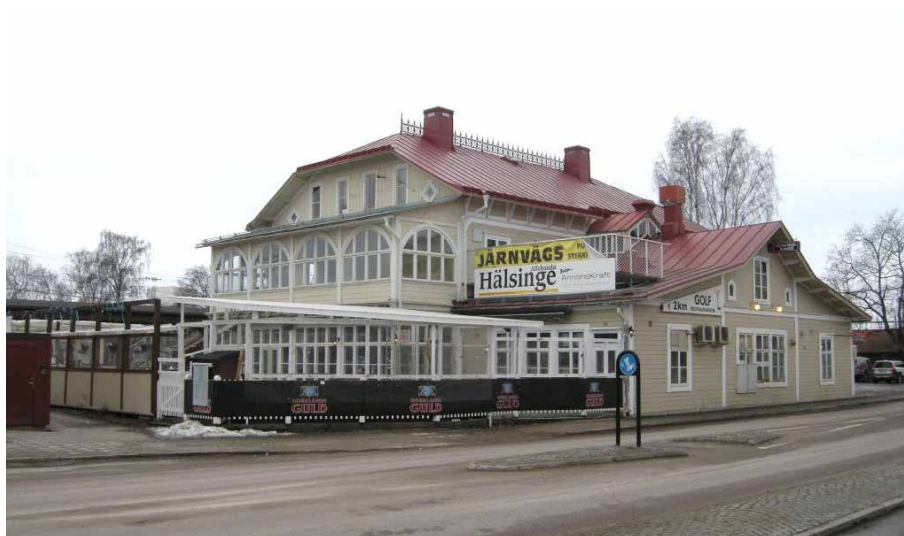
Figur 3. Järnvägshotellet från öster före renoveringen. Foto: Daniel Olsson, Länsmuseet Gävleborg 2014-02-25.
