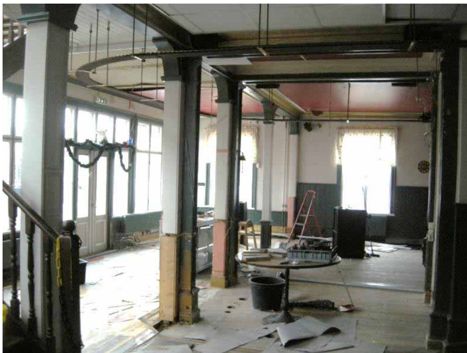
Figur 13. Restaurangen från norr efter rivning av baren. Foto: Daniel Olsson, Länsmuseet Gävleborg 2014-03-04.
