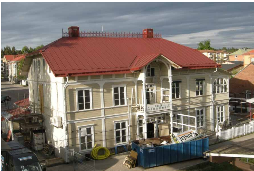
Figur 2. Järnvägshotellet sett från järnvägsviadukten under pågående renovering. Foto från väster. Foto: Daniel Olsson, Läns museet Gävleborg 2014-06-03.
