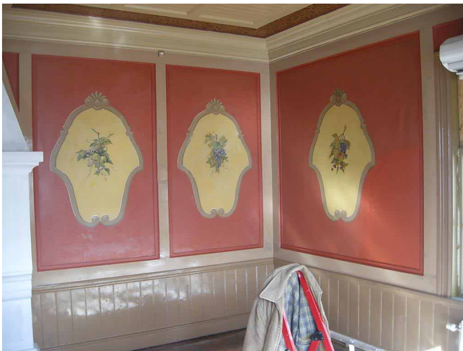
Figur 17. Väggmålningarna i kaféets norra del under pågående renovering. Foto från söder. Foto: Daniel Olsson, Länsmuseum Gävleborg 2014-04-03.
