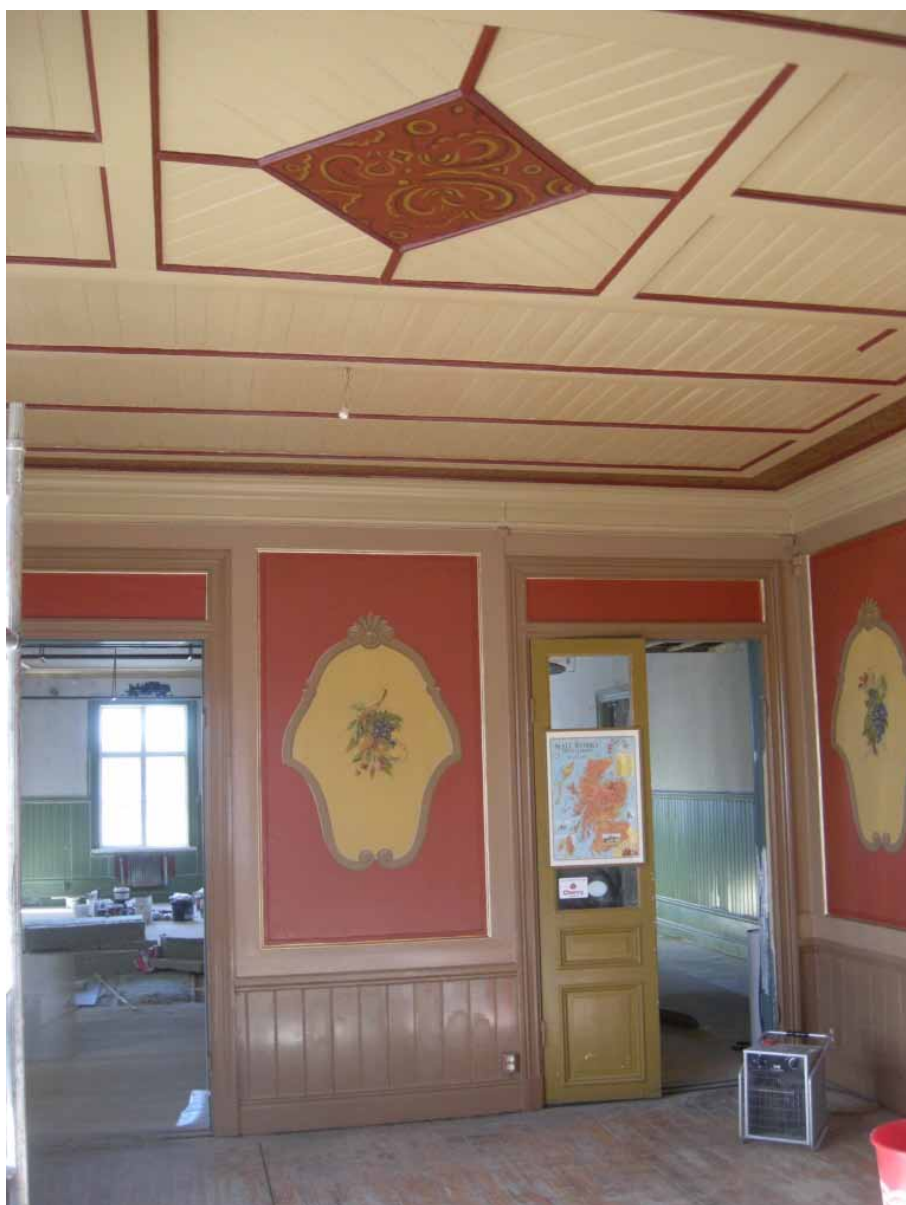
Figur 19. Kaféet från nordöst under pågående renovering. Foto: Daniel Olsson, Länsmuseet Gävleborg 2014-04-11.
