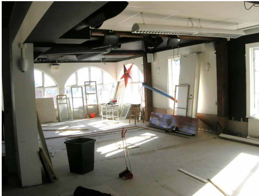
Figur 26. Andra våningen med restaurang- och danslokalen från väster under pågående renovering. Foto: Daniel Olsson, Läns museet Gävleborg 2014-03-21.
