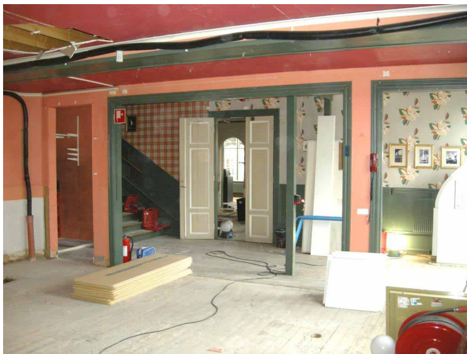
Figur 14. Entrehallen och den tidigare garderoben från väster efter påbörjad rivning. Foto: Daniel Olsson, Läns museet Gävleborg 2014-03-14.
