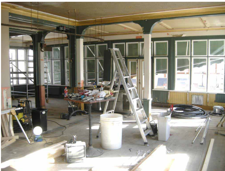
Figur 20. Restaurangen från väster under pågående renovering. Foto: Daniel Olsson, Läns museet Gävleborg 2014-03-21.
