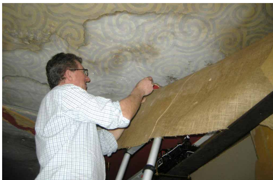
Figur 23. Alf Blom frilägger takmålningen i ett av de tre taken i restaurangdelen. Foto från söder. Foto: Daniel Olsson, Läns museet Gävleborg 2014-03-14.
