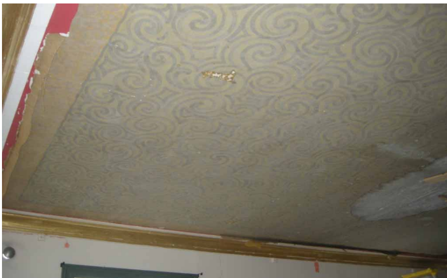
Figur 24. Det största målade papptaket i restaurangdelen från öster under pågående renovering. Foto: Daniel Olsson, Läns museet Gävleborg, 2014-03-14.
