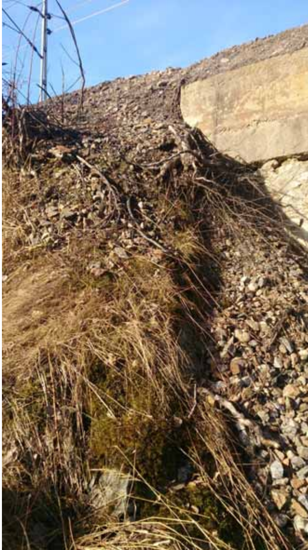
Figur 9. Den stensatta ytan på södra delen av brons östra sida är inte urskiljbar. Foto: Inga Blennå.
