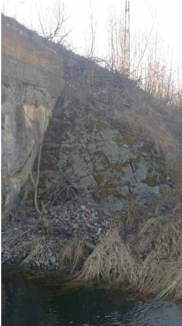
Figur 15. Den stensatta ytan på södra delen av bronns västra sida är urskiljbar om än bevuxen med gräs och sly. Foto: Inga Blennå.
