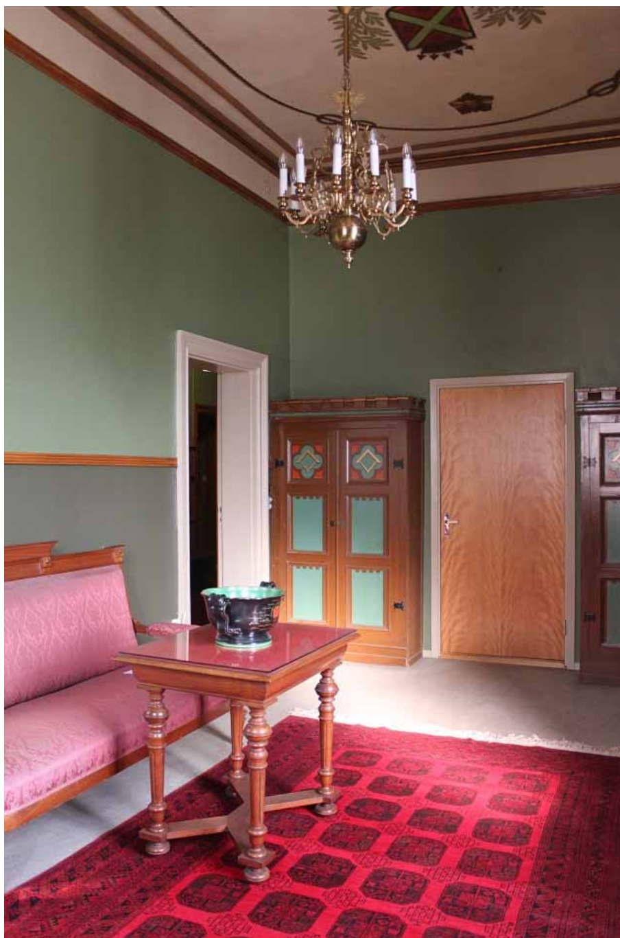
Figur 11. Ämbetsmannarummet efter avslutade arbeten. De tidigare vävtapetserade väggarna har bredspacklats och målats med linoljefärg i kulörer likvärdiga de från 1915, då rummet gjordes om från att tidigare ha ingått som rum i logevaktmästarens lägenhet. Listverk är laserade i brunt. Foto: Ulrika Olsson, Läns museet Gävleborg, 2017-03-06.
