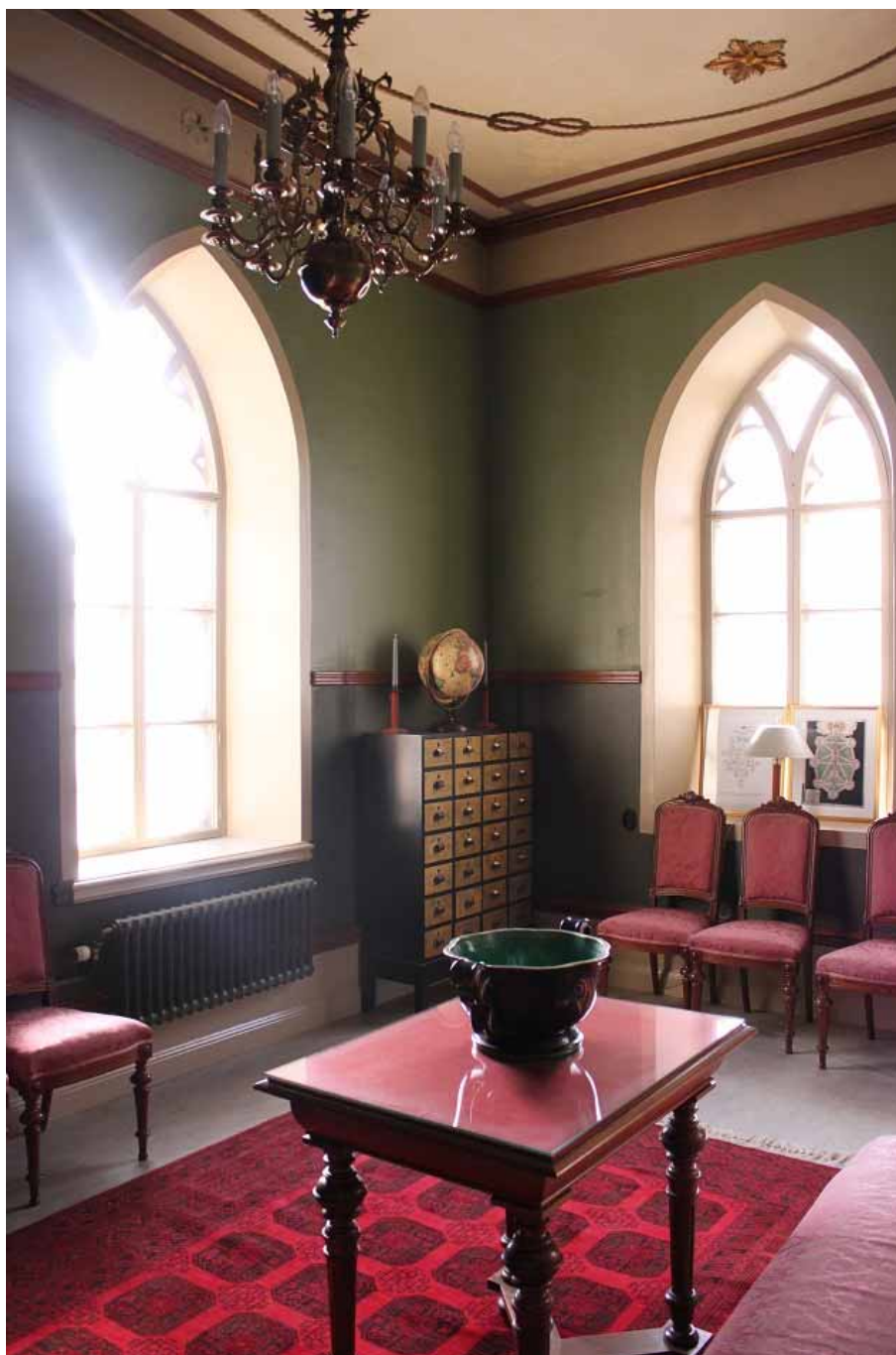
Figur 12. Ämbetsmannarummet efter avslutade arbeten. De tidigare vävtapetserade väggarna har bredspacklats och målats med linoljefärg i kulörer likvärdiga de från 1915, då rummet gjordes om från att tidigare ha ingått som rum i logevaktmästarens lägenhet. Fönsterbågar och fönsternischer är målade i en gulgrå kulör. I hörnet av taket skymtar en sparad referensyta, liksom en tidigare hårt flagad yta. Foto: Ulrika Olsson, Länsmuseet Gävleborg, 2017-03-06.
