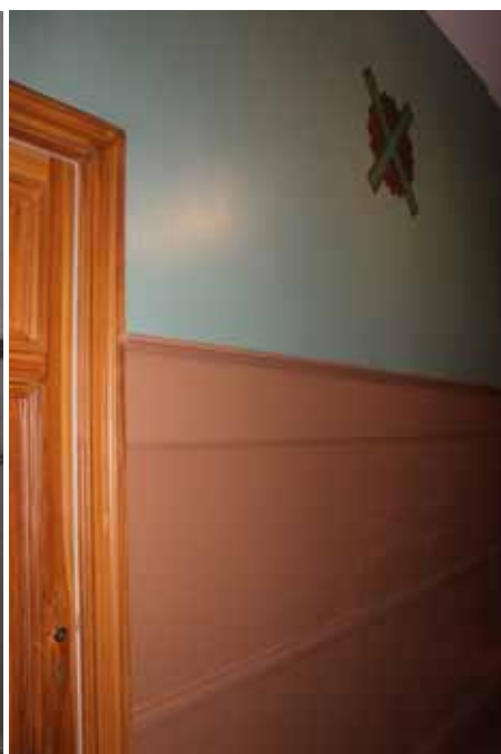
Figur 3. Passagen efter avslutade arbeten. Färgsättningen som tillkom kring 1915 har återskapats. Den övre väggytans vävtapet har bredspacklats. Ytan kring Andreaskorset är nu integrerad med övrig väggyta. Foto: Ulrika Olsson, Läns museet Gävleborg, 2017-03-06.
