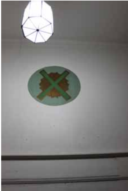
Figur 4. Passagens Andreaskors före påbörjade arbeten. Den ursprungliga putsade ytan var utspard i 1970-talets vävtapet. Foto: Ulrika Olsson, Läns museet Gävleborg, 2016-12-05.
