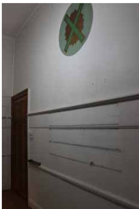
Figur 2. Passagen före påbörjade arbeten. Väggedekorationen i form av ett Andreaskors, hade sparats ut i vävtapeten. Den gröna kulören kring korset var den ursprungliga kulören, tillkommen omkring 1915. I övrigt var utrymmets väggar och listverk vitmålade. Foto: Ulrika Olsson, Läns museet Gävleborg, 2016-12-05.
