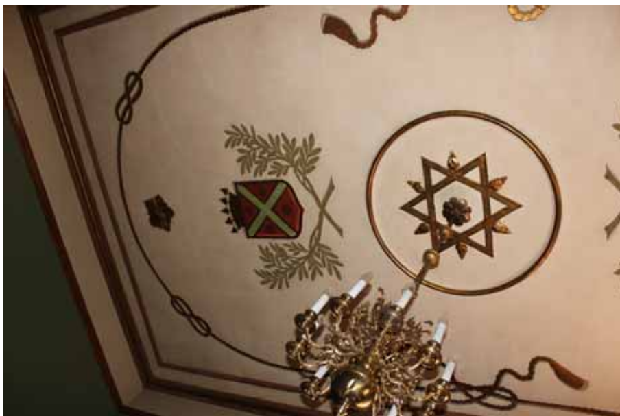
Figur 14. Det putsade och målade taket efter avslutade arbeten. Sprickor har lagts igen med gips, ytorna har rengjorts och flagade delar har bättrats. Foto: Ulrika Olsson, Länsmuseet Gävleborg, 2017-03-06.
