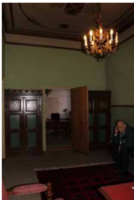
Figur 7. Ämbetsmannarummet före påbörjade arbeten. Väggarna var tapetserade med vävtapet och både väggar och tak var hårt smutsade. Foto: Ulrika Olsson, Läns museet Gävleborg, 2016-12-05.
