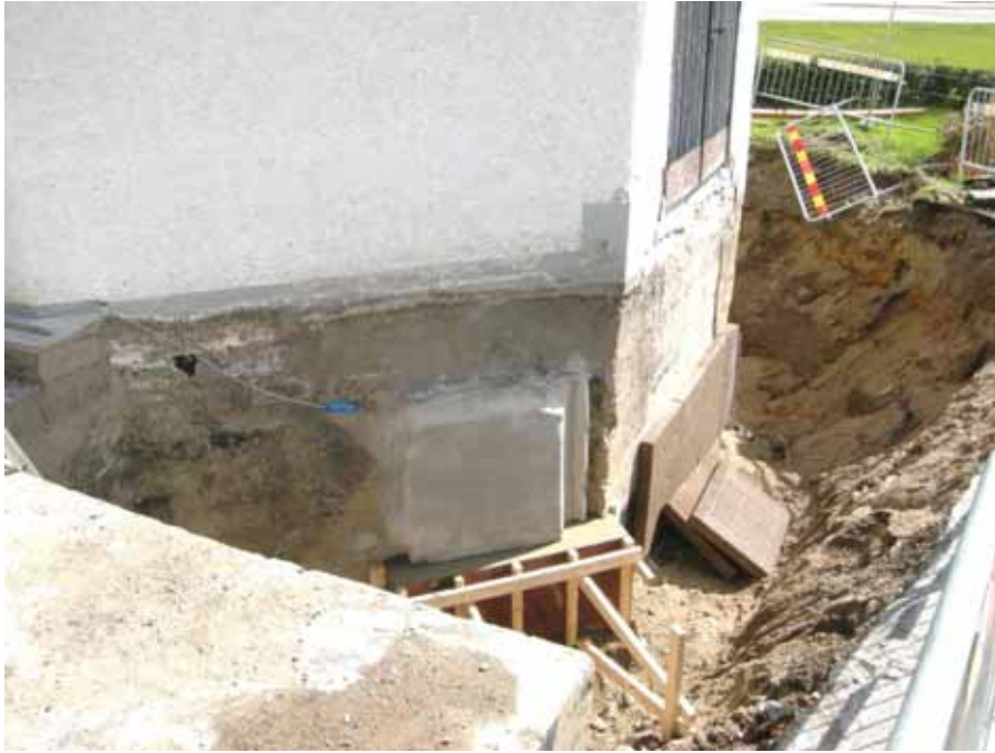
Figur 6. Detalj av grunden kring kapellet från nordväst under pågående dräneringsarbete. I förgrunden till vänster skymtar ett hörn av det underjordiska bårhusets gjutna konstruktion. Foto: Daniel Olsson, Länsmuseet Gävleborg 2015-06-01.
