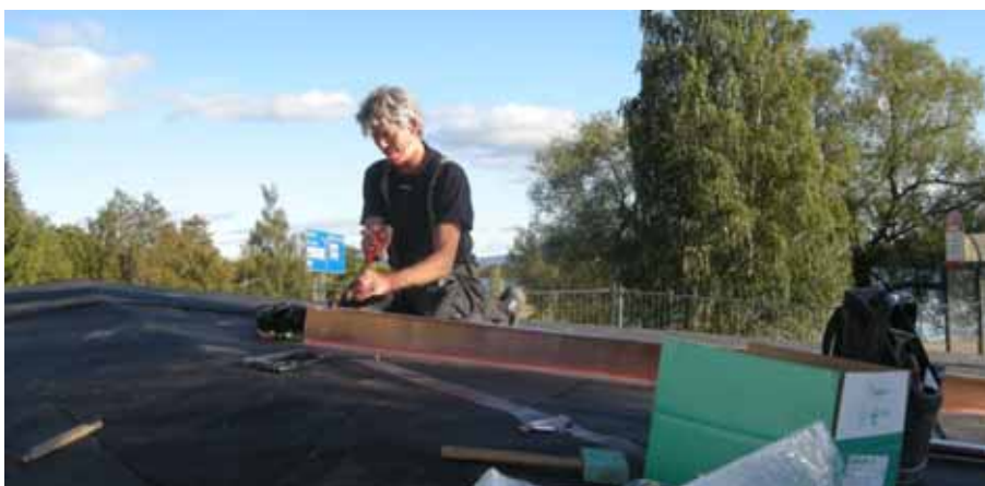
Figur 13. Plåtarbete på den sydöstra tillbyggnadens tak. Foto från söder. Foto: Daniel Olsson, Länsmuseet Gävleborg 2015-09-28.
