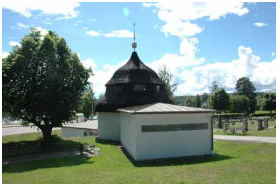
Figur 17. Kapellet från norr med den nya tillbyggnaden mot norr efter justering av marknivåer kring byggnaden. Foto: Daniel Olsson, Länsmuseet Gävleborg 2016-06-29.
