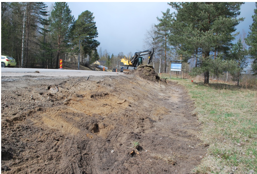
Figur 5. Hållplats Bålleberget öster om väg 758 efter schaktning, från söder. Foto: Inga Blennå.
