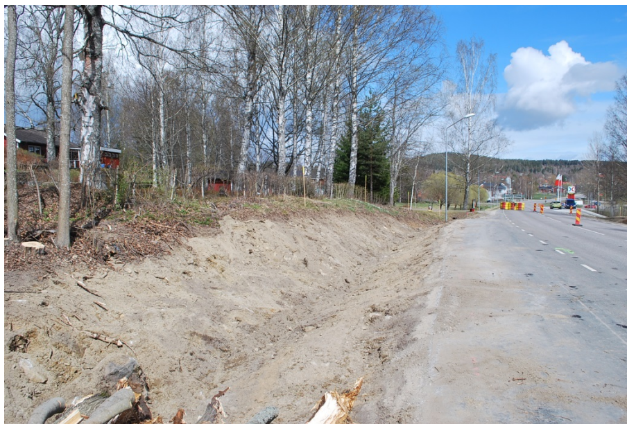
Figur 3. Hållplats Bergvik väster om väg 758 efter schaktning, från söder. Foto: Inga Blennå.
