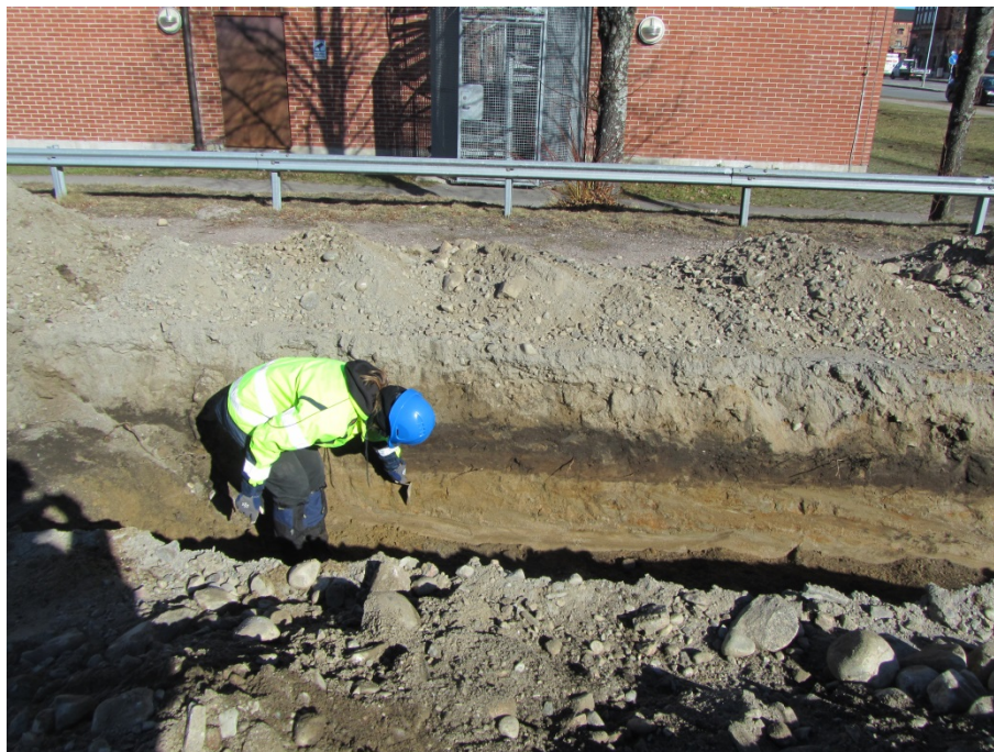
Bild 5. Sektionen rensas fram i schakt 3. Foto: Bo Ulfhielm
