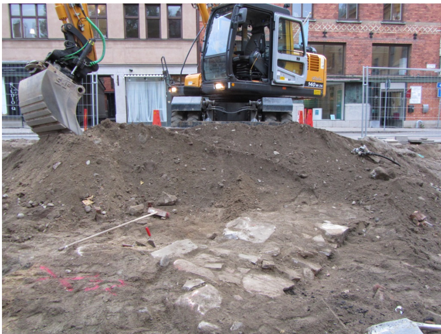
Bild 2. Maskinschaktningen övervakades kontinuerligt och påträffade anläggningar grävdes fram i plan. Foto Bo Ulfhielm.
