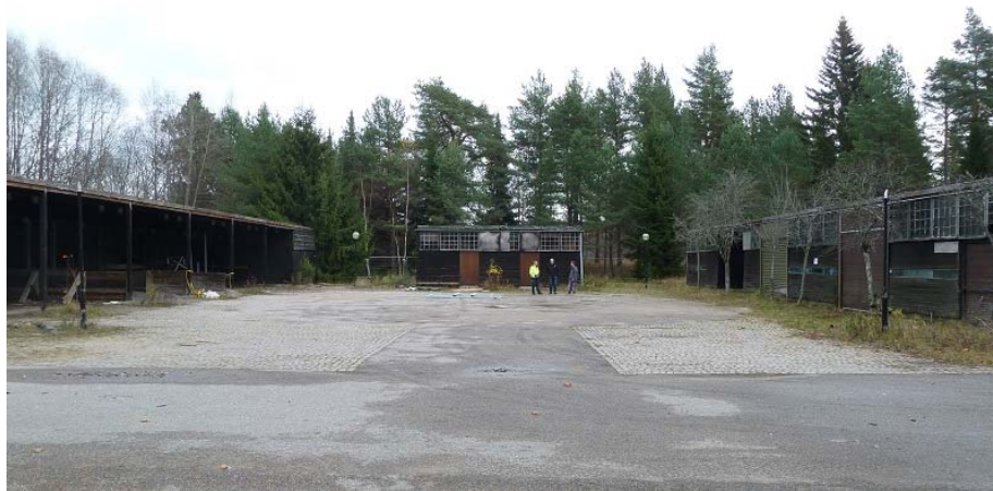
Figur 3. Området vid projektstart. Byggnaden i mitten rymde ursprungligen personalutrymmen, och har under detta projekt renoverats. Övriga byggnader har rivits. Foto: 2014-11-09.
