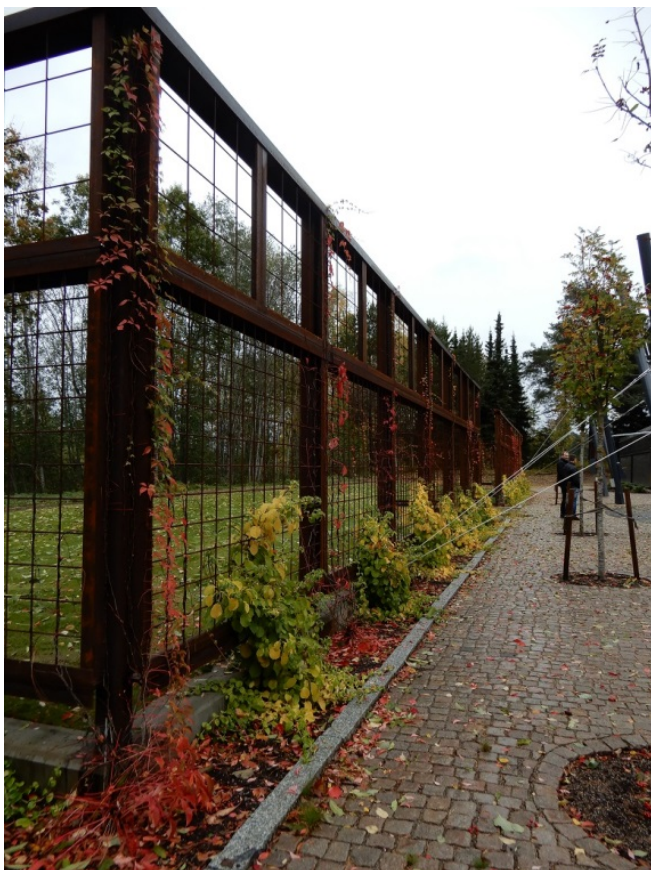
Figur 15. Närbild på spaljée med fält av armeringsjärn. Armeringsjärnen i de övre partierna minner om de tidigare byggnadernas fönsterband vid takfoten. Nya träd är planterade i stenläggningen, likt tidigare placeringar. Foto: 2017-10-10.
