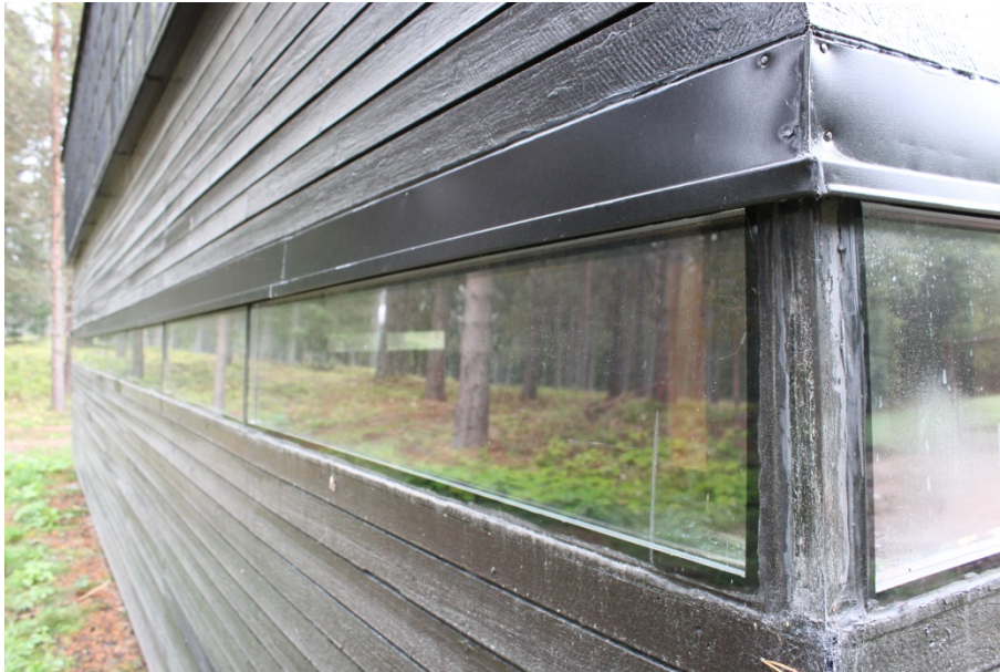
Figur 22. Fönsterband med bytta glas och ny plåtskoning. Foto: 2015-09-24.
