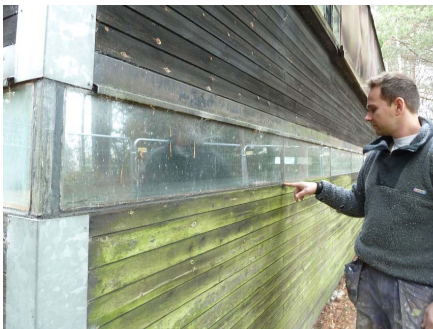
Figur 13. Ragnar Didriksen, Didriksen Fina Hus AB, undersöker panel och fönsterband inför byggstart. Foto: 2014-11-09.
