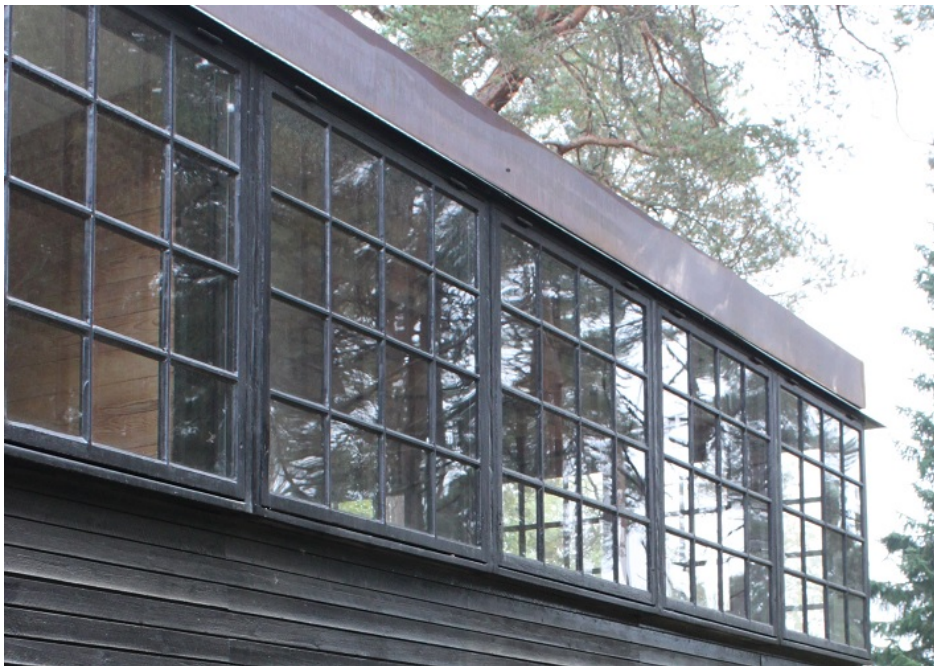
Figur 21. Renoverade fönsterbågar på plats efter avslutade arbeten. Foto: 2015-09-24
