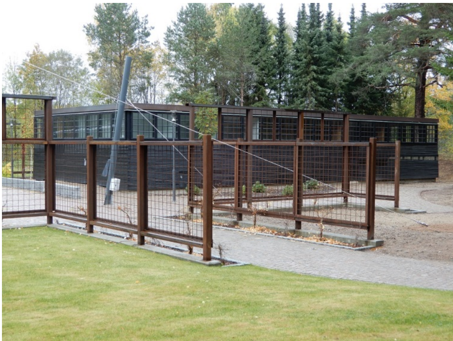
Figur 16. Den renoverade byggnaden sedd från sydväst. Spaljéen har en öppning ut mot gången mot söder, likt passagen som fanns i tidigare ekonomibyggnad på platsen. Foto: 2017-10-10.
