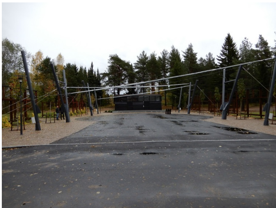
Figur 14. Den renoverade byggnaden sedd från väster. Spaljéer omgärdar längs norra och södra sidan, där de tidigare ekonomibyggnaderna tidigare hade sin placering. Nytillkomna plintar håller samman en konstruktion med inrullade segeldukar, vilka är möjliga att rulla ut som ett tak vid förrättningar och dylika evenemang. Foto: 2017-10-10.
