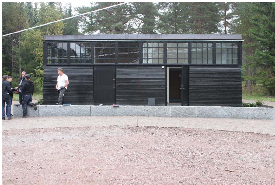
Figur 2. Byggnaden sedd från gårdssidan efter avslutade arbeten. Foto: 2015-09-24.
