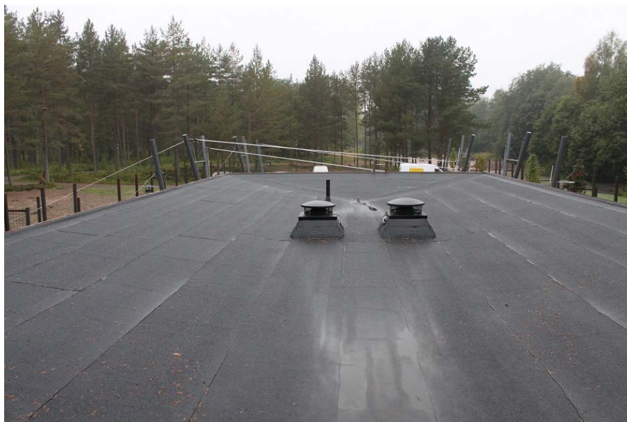
Figur 24. Taket efter avslutade arbeten. Foto: 2015-09-24.
