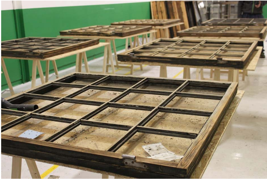
Figur 20. Fönsterbågar på Didriksens verkstad under renovering. Foto: 2014-11-28.
