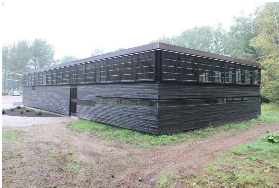
Figur 19. Den ursprungliga byggnaden för personalutrymmen efter avslutade arbeten. Foto: 2015-09-24.
