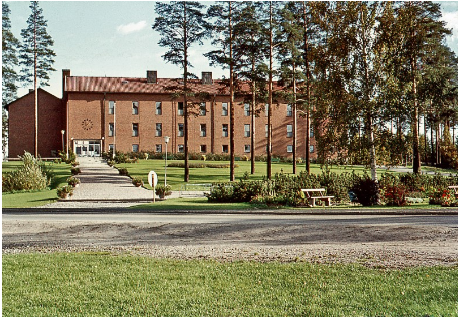
Hagaskolan under början av 1960-talet. Byggnadens längdverkan samspelar med de raka tallarna. Foto: Bruno Bäckström. Källa: Bygdeband.
