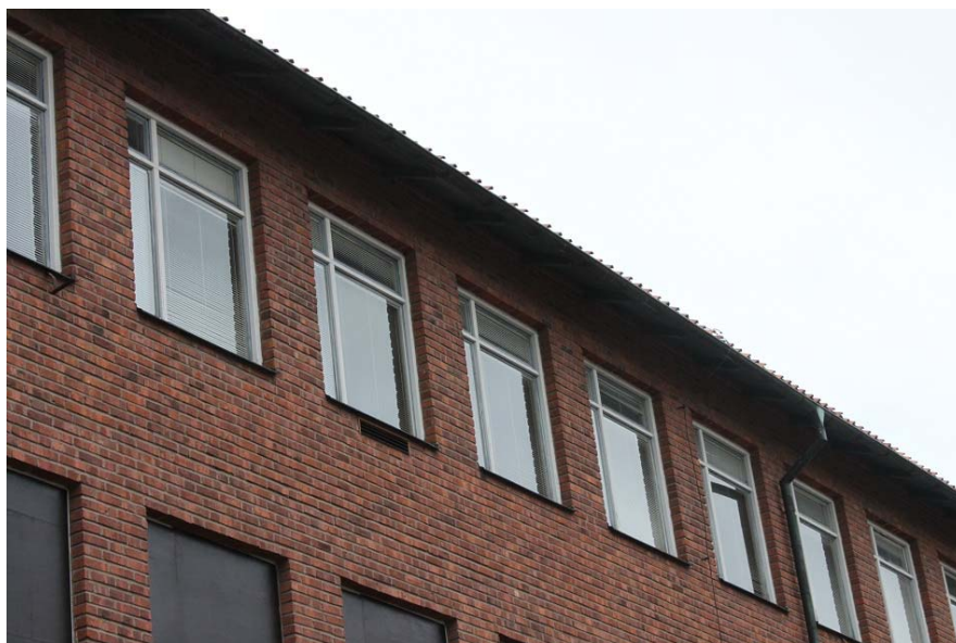
Typ av fönster som finns i klassrummen in mot skolgården. Foto: 2017-09-22.
