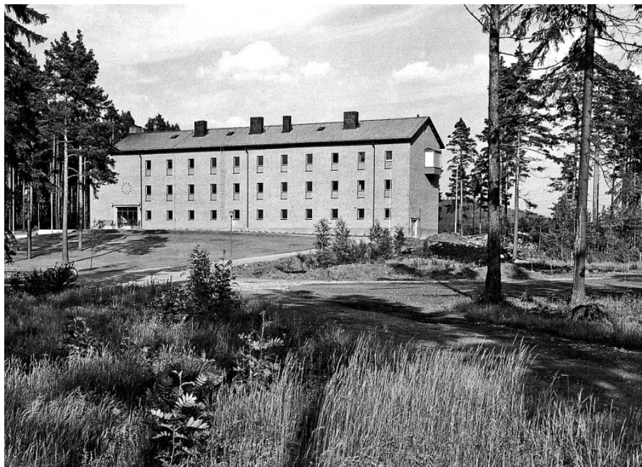
Den nybyggda Hagaskolan augusti 1951. Enligt de ursprungliga ritningarna skulle gymnastiksalen ha legat i en byggnadskropp ut från gaveln, men till denna gavs inget tillstånd. Källa: Hofors Hembygdsförening, Bygdebånd.
