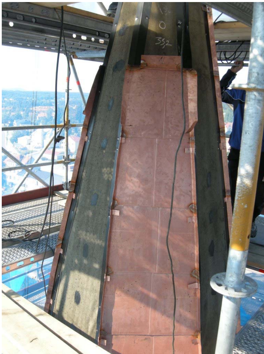
Figur 13. Detalj av tornhuvens översta del efter påbörjad inklädnad med ny kopparplåt. Foto: Daniel Olsson, Länsmuseet Gävleborg 2009-06-09.
