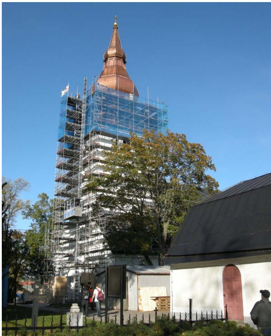
Figur 2. Jakobs kyrkas torn från sydväst under pågående renovering. Foto: Daniel Olsson, Läns museet Gävleborg 2009-09-29.
