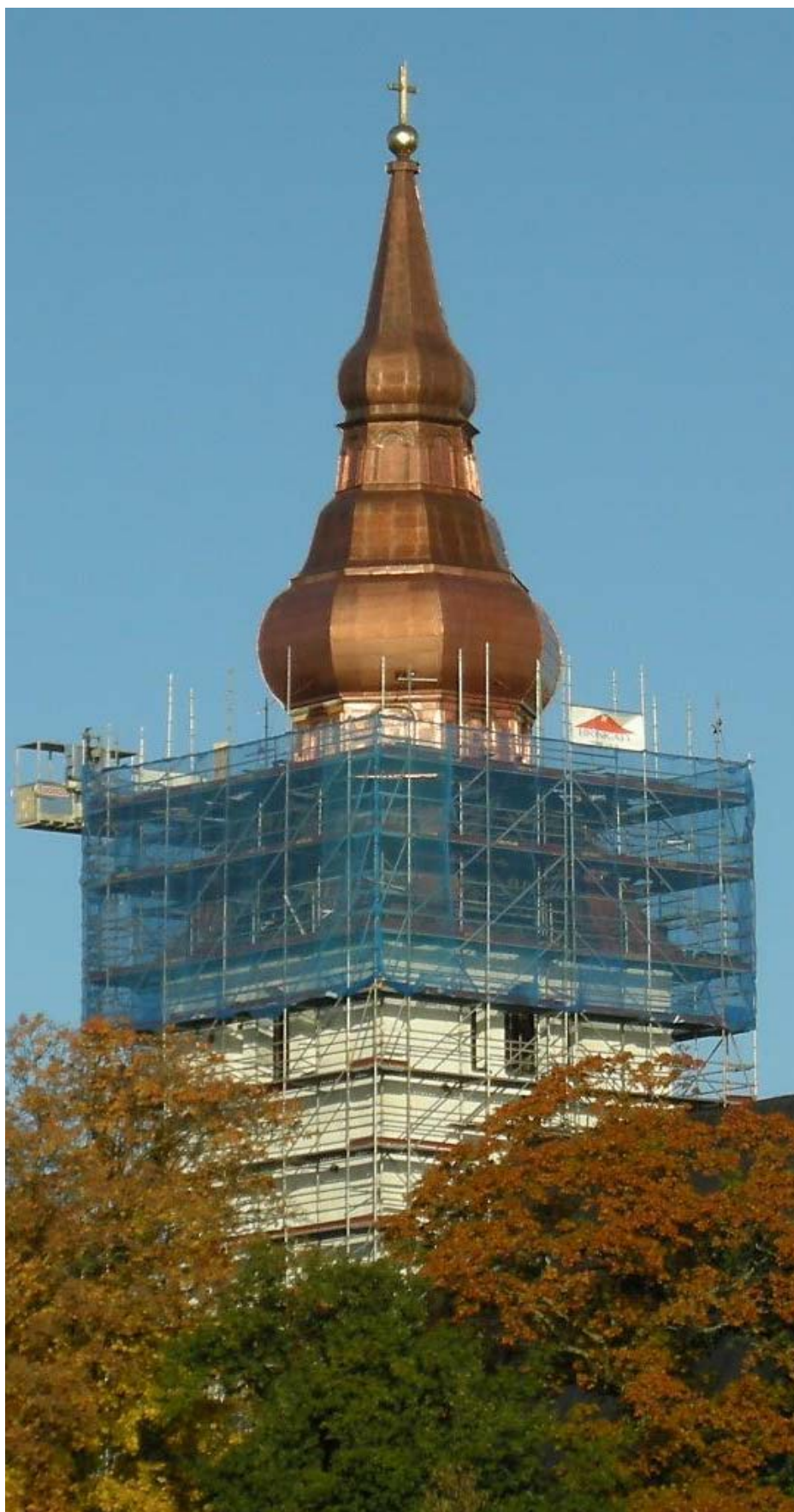
Figur 27. Kyrktornet under pågående renovering. Foto: Daniel Olsson, Läns- museet Gävleborg 2009-10-07.
