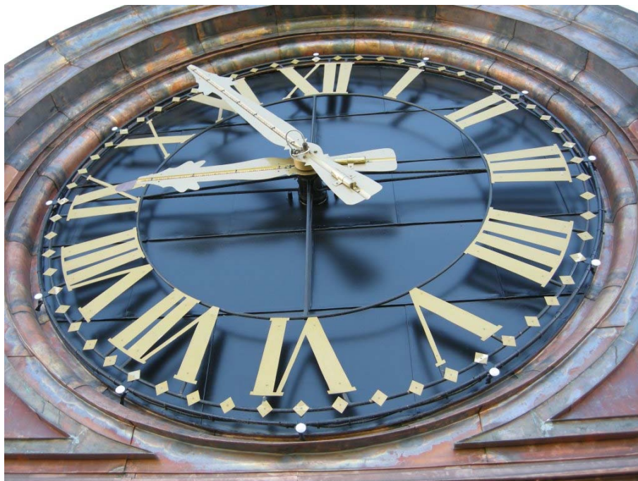
Figur 18. Ett av kyrkans fyra tornur efter omklädning med ny plåt samt montering av ljusarmaturer. Foto: Daniel Olsson, Läns museet Gävleborg 2010-06-09.
