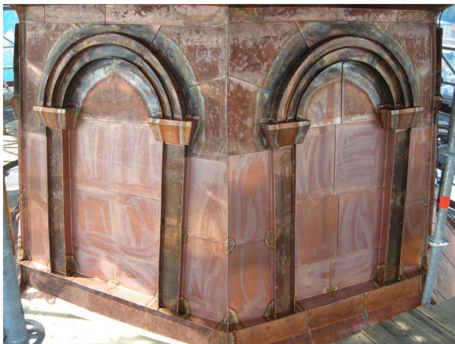
Figur 16. Detalj av tornhuvens övre rad med luckor efter inklädnad med ny kopparplåt. Foto: Daniel Olsson, Läns museet Gävleborg 2009-09-01.
