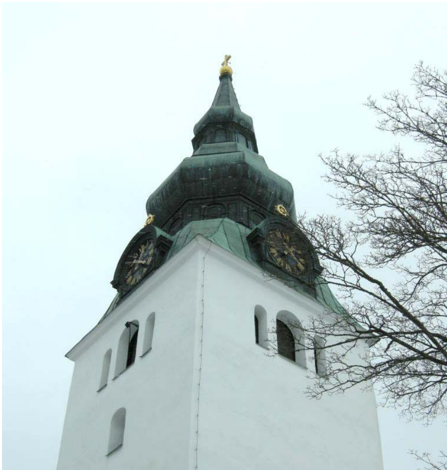
Figur 4. Kyrktornets övre del från sydväst innan renoveringen påbörjades. Foto: Daniel Olsson, Läns museet Gävleborg 2009-03-26.
