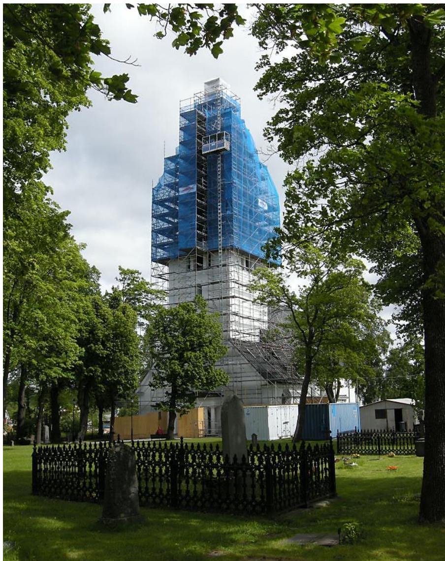
Figur 12. Kyrkan från sydväst med byggnadsställningar kring kyrktornet. Foto: Daniel Olsson, Läns museet Gävleborg 2009-06-16.
