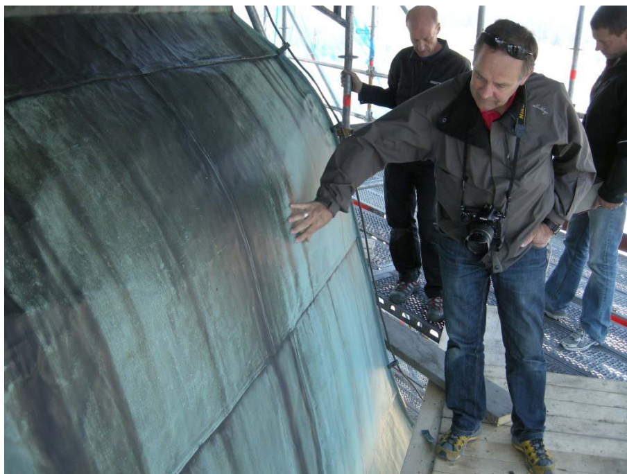
Figur 5. Plåtkonsult Hans-Erik Olsson studerar plåttaket på den nedre lök-kupolen efter att byggnadsställningen kommit på plats. I bakgrunden Anders Svahn från församlingen och Jonas Karlsson, Cityplåt i Umeå AB. Foto: Daniel Olsson, Läns museet Gävleborg 2009-05-26.
