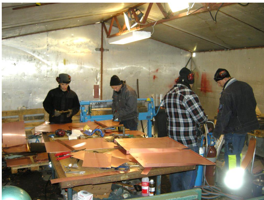
Figur 26. Plåtarbete i Cityplåt i Umeå AB:s tillfälliga fältverkstad intill kyrkan. Foto: Daniel Olsson, Länsmuseet Gävleborg 2009-10-07.
