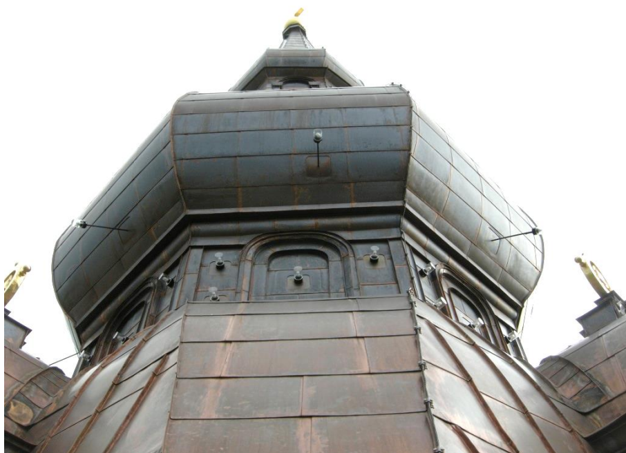
Figur 23. Detalj av tornhuven efter avslutad renovering. Notera de nya ljusarmaturerna Foto: Daniel Olsson, Läns museet Gävleborg 2010-06-30.
