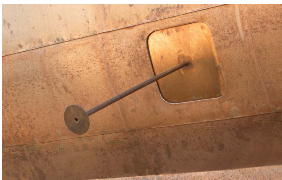
Figur 19. Detalj av en av de förkopprade armarna innan montering av ljusarmatur. Foto: Daniel Olsson, Läns museet Gävleborg 2009-10-07.
