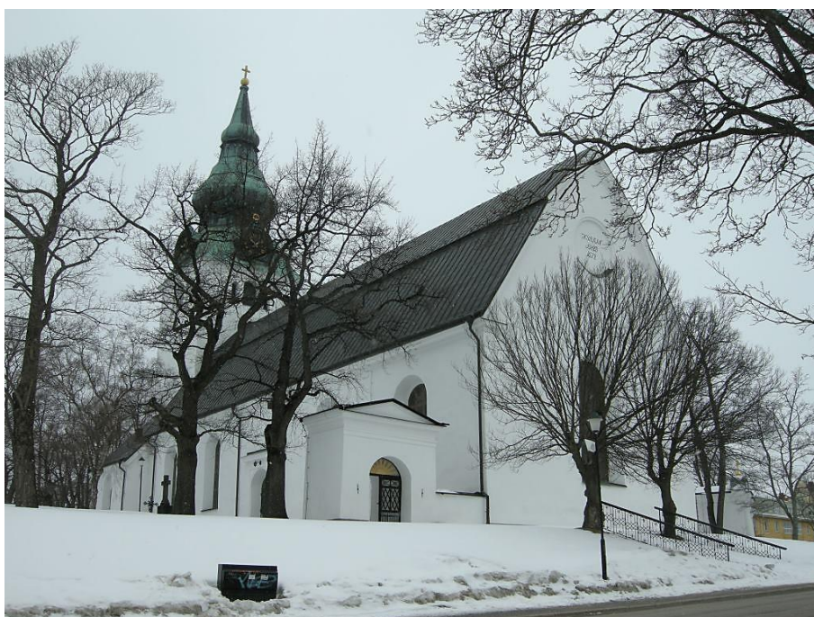
Figur 3. Hudiksvalls kyrka från sydöst innan renoveringen inleddes. Foto: Daniel Olsson, Läns museet Gävleborg 2009-03-26.
