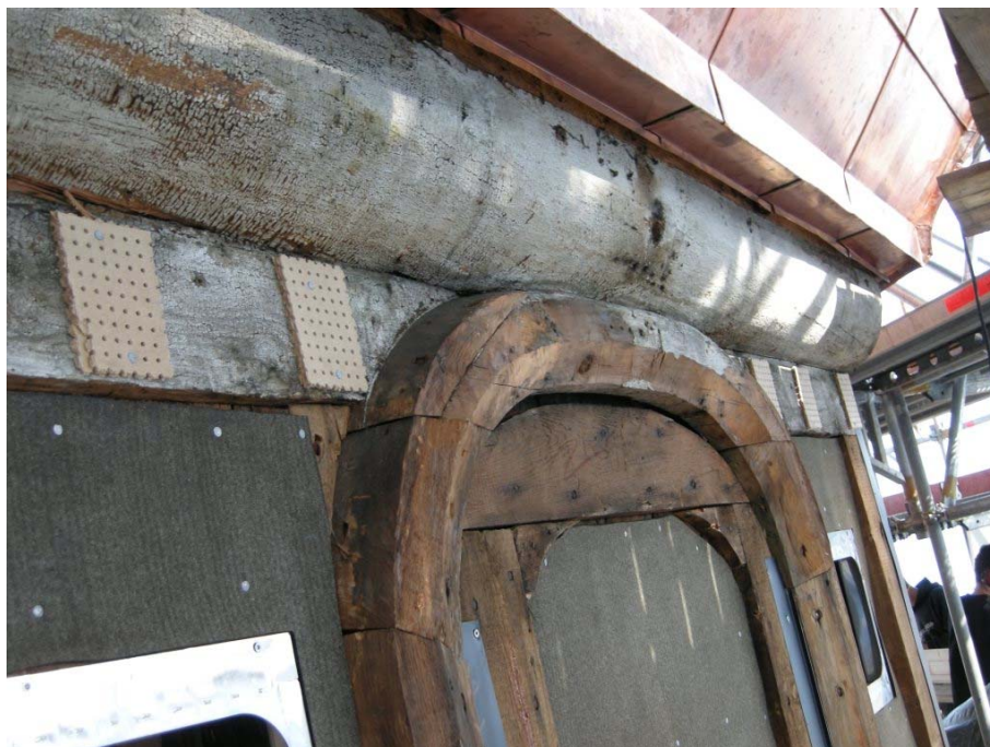
Figur 15. Detalj av fasadpartiet i höjd med tornets nedersta rad luckor innan inklädning med ny kopparplåt. Foto: Daniel Olsson, Läns museet Gävleborg 2009-09-01.
