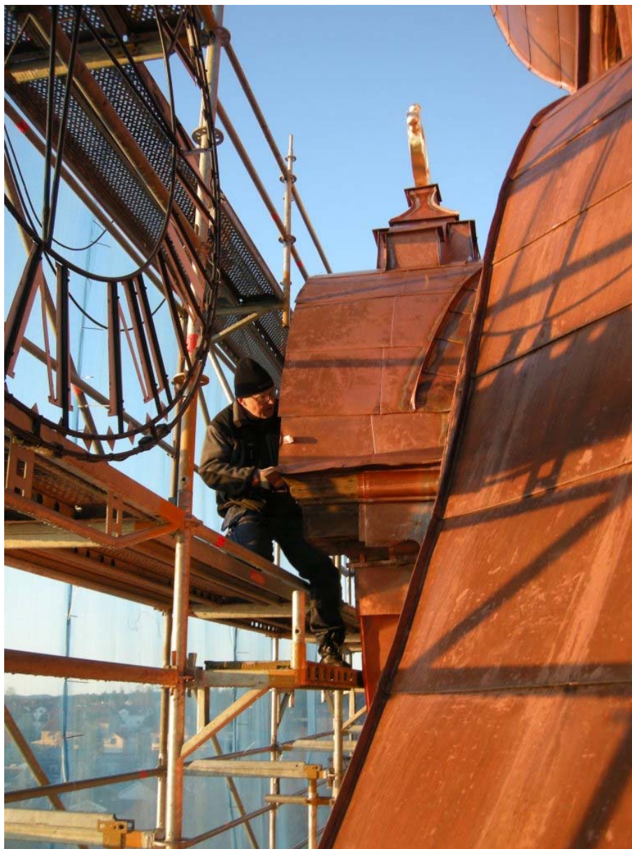
Figur 25. Pågående plåtarbete vid en av tornets fyra urtavlor. Foto: Daniel Olsson, Länsmuseet Gävleborg 2009-12-01.
