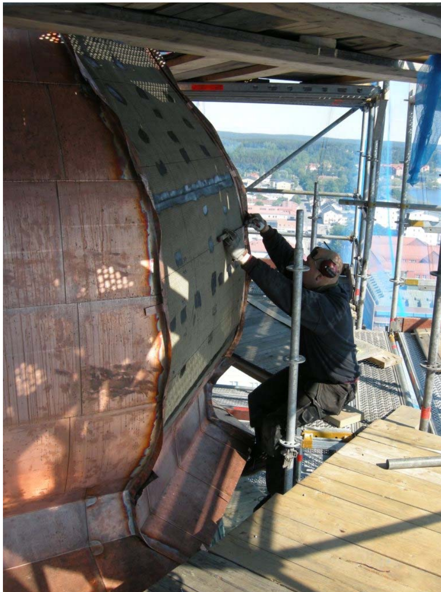
Figur 14. Plåtarbetet på lökkupolerna krävde mycket måttagning och anpassning. Foto: Daniel Olsson, Länsmuseet Gävleborg 2009-06-09.
