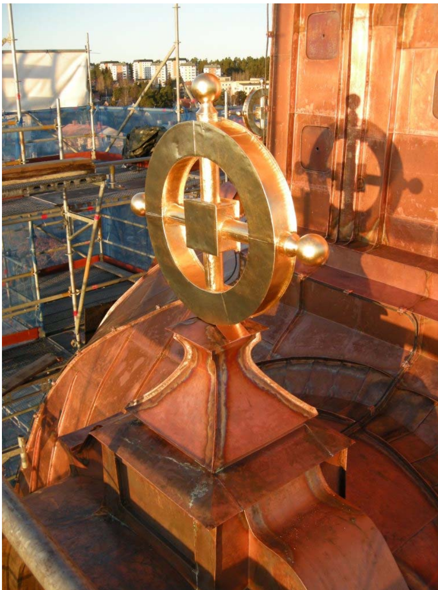
Figur 21. Detalj av en av urtavlornas utsmyckning i kopparplåt med ett nyförgyllt hjulkors överst. Foto: Daniel Olsson, Läns museet Gävleborg 2009-12-01.
