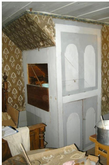
Figur 13. De inbyggda skåpen under trappan till övervåningen från sydväst efter lagning av de bemålade ytskikten. Foto: Daniel Olsson, Läns museet Gävleborg 2011-11-29.
