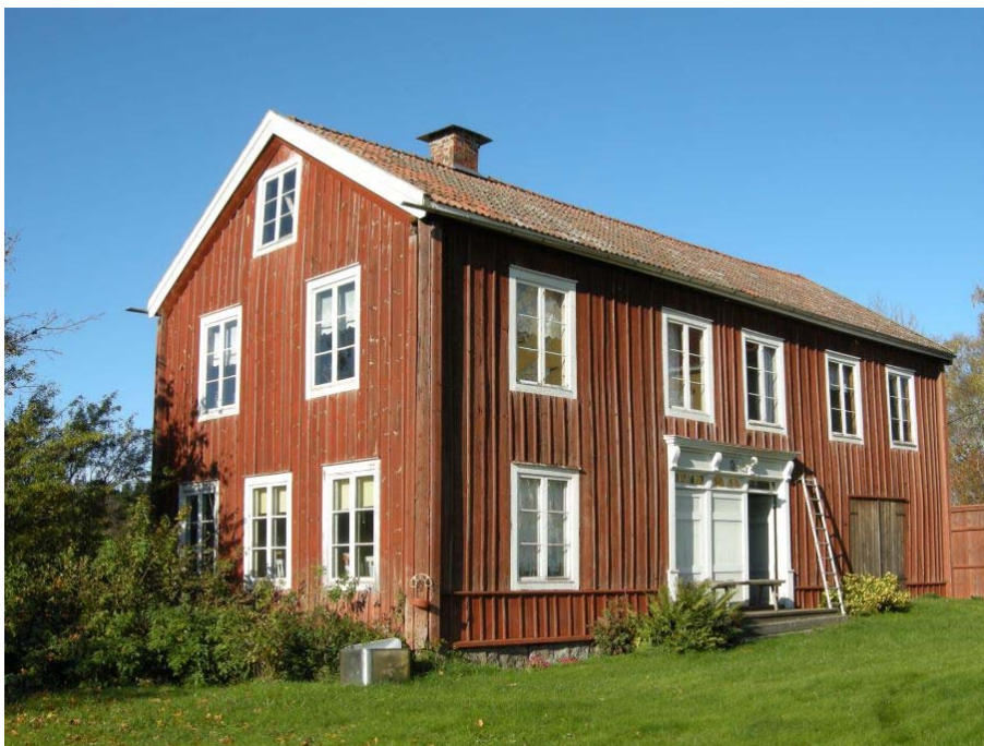
Figur 4. Gammelbyggnaden från sydöst. Foto: Daniel Olsson, Läns museet Gävleborg 2011-10-07.
