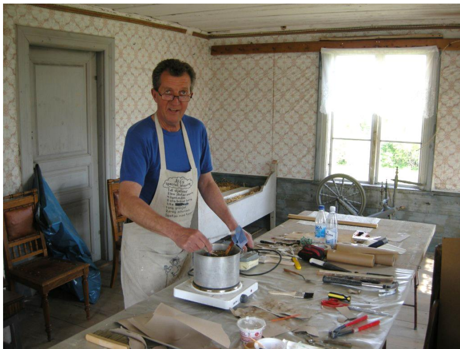
Figur 18. Konservator Alf Blom tillverkar lim som han använder vid tapetrestaureringen. Foto från sydväst i den övre salen i gammelbyggningen. Foto: Daniel Olsson, Läns museet Gävleborg 2011-05-31.
