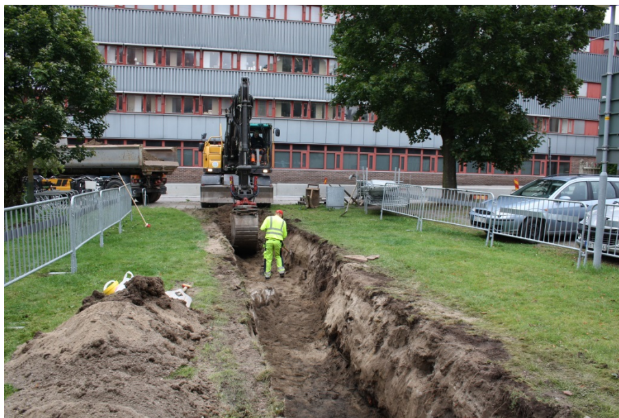
Bild 2. Schaktgrävning för fjärrkyla på Läns museets tomt (schakt 1). Foto: Maria Björck.
