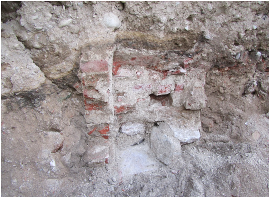
Bild 11. Tegelfundament vid biblioteksbyggnaden. Foto: Bo Ulfhielm.
