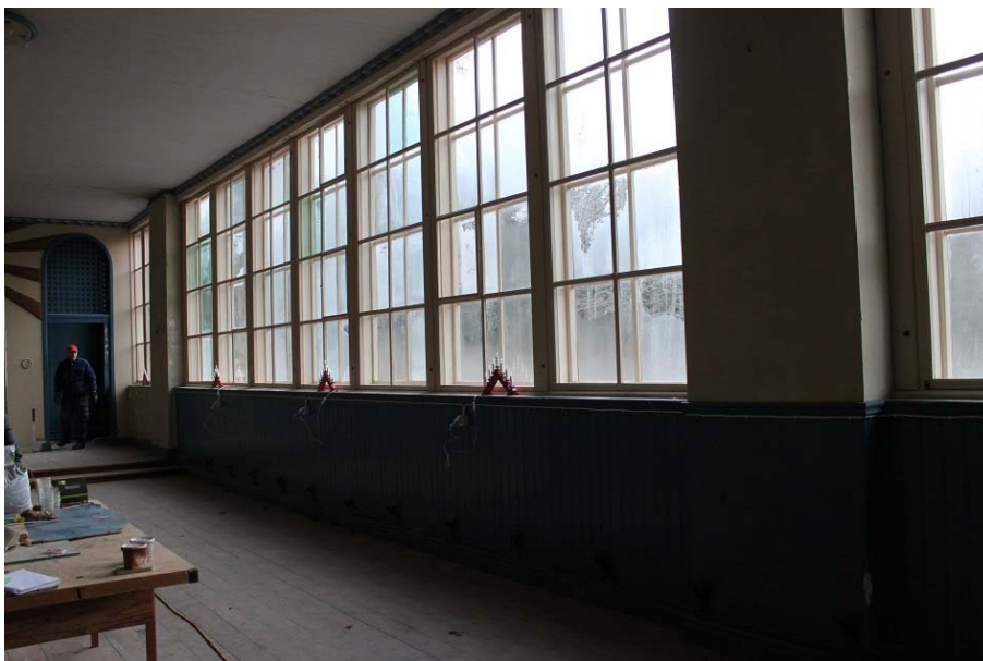
Figur 15. Innerbågarna är renoverade och målade i samma kulör som innan påbörjade arbeten, en varm grå kulör. Foto: Ulrika Olsson, Läns museet Gävleborg 2017-12-05.
