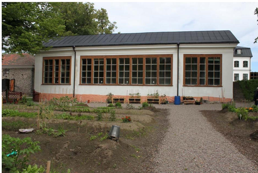
Figur 3. Orangeriet sett från söder innan påbörjade arbeten. Foto: Ulrika Olsson, Läns museet Gävleborg 2017-06-29.
