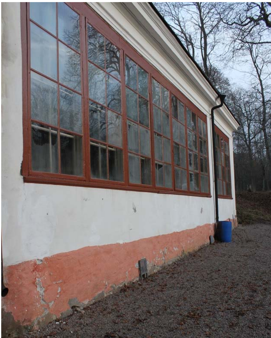
Figur 12. Det mittersta samt det östra fönsterbandet efter avslutade arbeten. På dessa partier saknades ännu plåtlisten vid slutbesiktningen. Foto: Ulrika Olsson, Läns museet Gävleborg 2017-12-05.
