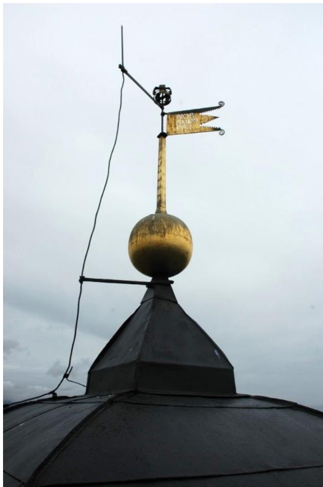
Figur 15. Detalj av lanternintakets översta del samt det förgyllda klotet med spira och vinflöjel. Foto: Daniel Olsson, Länsmuseum Gävleborg 2016-08-29.
