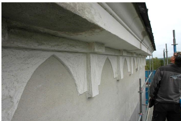
Figur 10. Detalj av tornfasadens utsmyckning efter putsning, men innan målning. Foto: Daniel Olsson, Läns museet Gävleborg 2016-08-29.
