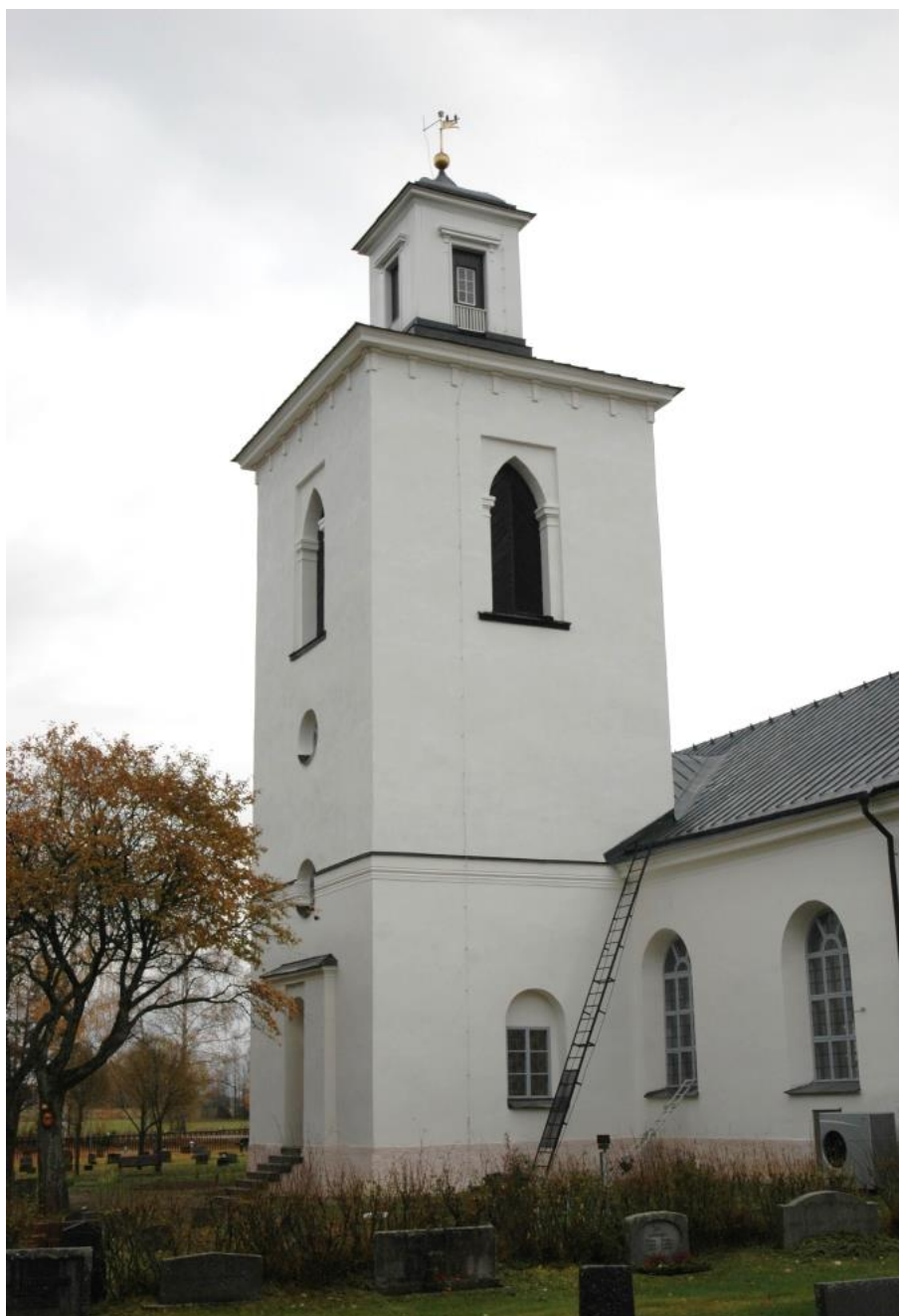
Figur 13. Kyrktornet från nordväst efter renoveringen. Foto: Daniel Olsson, Länsmuseet Gävleborg 2016-10-25.
