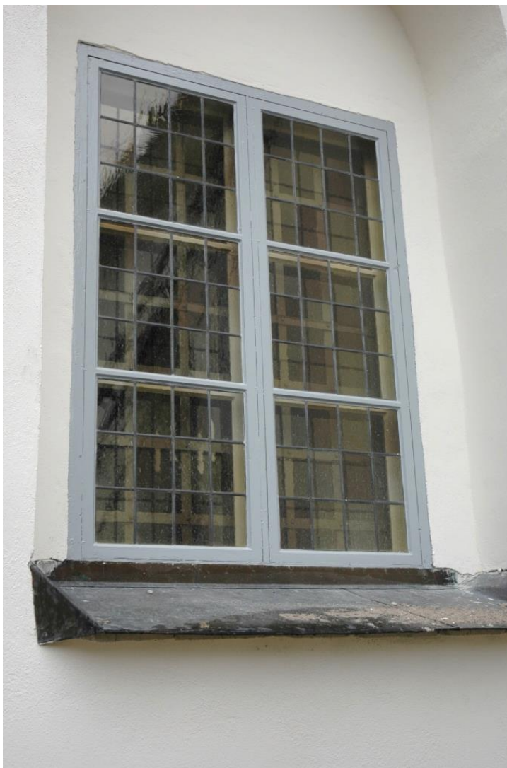
Figur 14. Detalj av ett av sakristians fönster efter ommålning. Foto: Daniel Olsson, Läns museet Gävleborg 2016-10-25.
