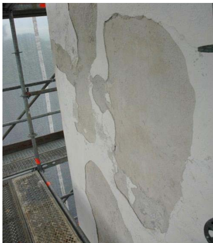
Figur 8. Detalj av en av kyrktornets fasader under renoveringen. Foto: Daniel Olsson, Läns museet Gävleborg 2016-08-16.
