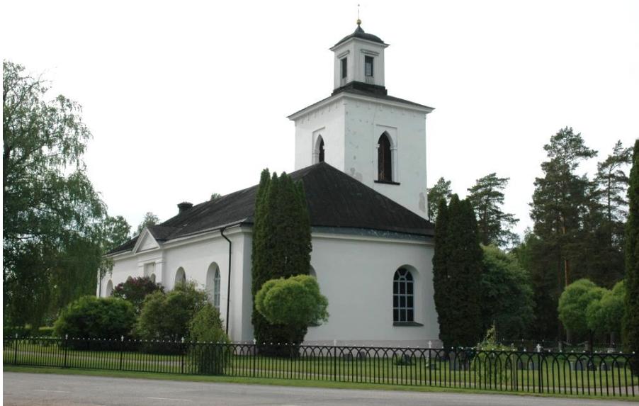
Figur 2. Kyrkobyggnaden från sydöst innan renoveringsarbetet påbörjades. Foto: Daniel Olsson, Läns museet Gävleborg 2016-06-15.
