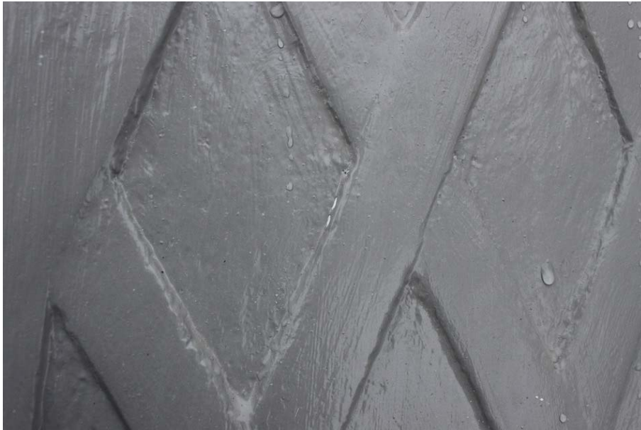
Figur 24. I mitten av fotot syns ett av flera "hål" i linoljefärgen, där underliggande ljus kulör lyser igenom. Foto: Ulrika Olsson, Läns museet Gävleborg, 2018-01-24.
