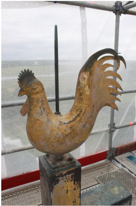
Figur 6 och 7. Kyrktuppen före påbörjade arbeten. Till höger syns den befintliga skadan på tuppen. Den tidigare lagningen lämnades utan åtgärd. Foto: Ulrika Olsson, Länsmuseum Gävleborg, 2017-06-27.
