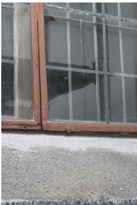
Figur 4 och 5. Såväl smidesbågarna som träbågarna var i behov av underhåll. Färgen var urlakad och flagade. Foto: Ulrika Olsson, Läns museet Gävleborg, 2017-04-26.
