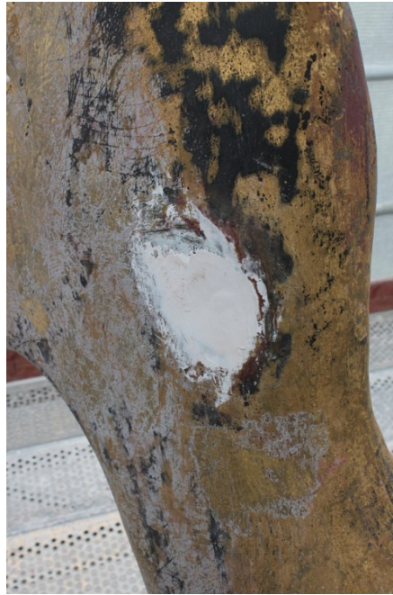
Figur 6 och 7. Kyrktuppen före påbörjade arbeten. Till höger syns den befintliga skadan på tuppen. Den tidigare lagningen lämnades utan åtgärd. Foto: Ulrika Olsson, Länsmuseum Gävleborg, 2017-06-27.
