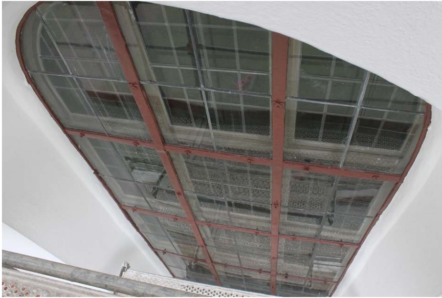
Figur 13. Smidesbåge belägen i långhuset. Alla arbeten har utförts på plats. Foto: Ulrika Olsson, Läns museet Gävleborg, 2017-09-19.
