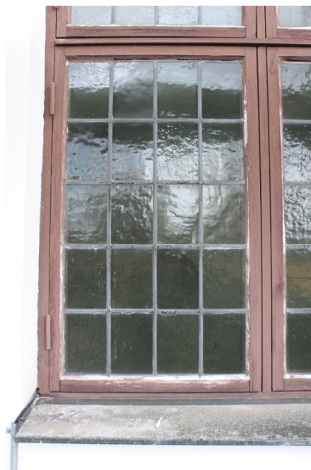
Figur 4 och 5. Såväl smidesbågarna som träbågarna var i behov av underhåll. Färgen var urlakad och flagade. Foto: Ulrika Olsson, Läns museet Gävleborg, 2017-04-26.
