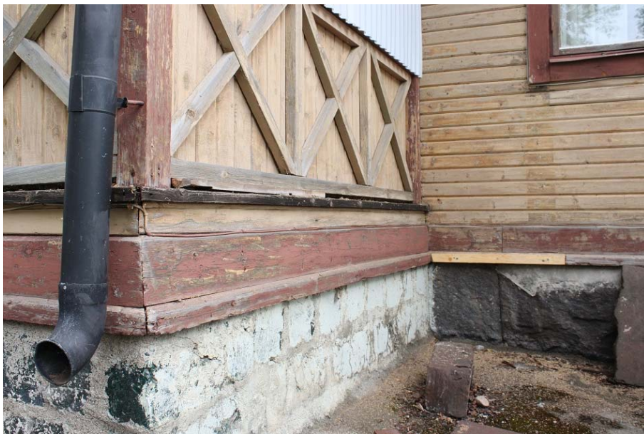
Figur 9. Inför målningen hade projektgruppen en del funderingar kring färgsättningen av verandans alla olika delar, frågor som fick svar genom konservator Per Mattsson. På bilden syns också en del av fotlisten som har lagats i. Foto: Ulrika Olsson, Läns museet Gävleborg, 2017-05-31.
