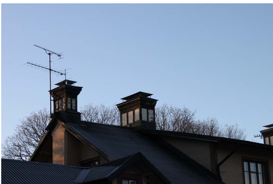
Figur 5. Arbetena med skorstenarna är färdiga. Dock återstår här målningen av plåtdelarna. Foto: Ulrika Olsson, Läns museet Gävleborg, 2016-12-06.
