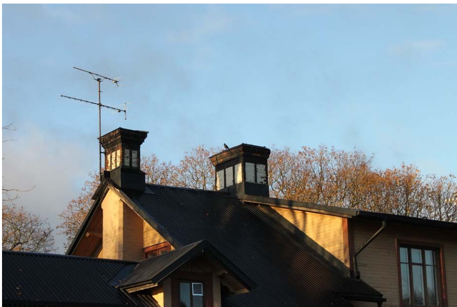
Figur 4. Jädraås stationshus före påbörjade arbeten. De två skorstenarna längst mot söder. På den högra utfördes under projektets gång en del murningsarbeten. Foto: Ulrika Olsson, Läns museet Gävleborg, 2016-10-27.
