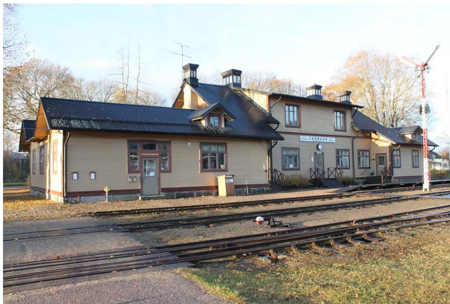
Figur 3. Jädraås stationshus före påbörjade arbeten. Mot öster hade sällskapet nyligen renoverat fasadpanelen under listan mellan bottenplan och första våningen. Skorstenarna saknade kajnät och huvar. Foto: Ulrika Olsson, Läns museet Gävleborg, 2016-10-27.
