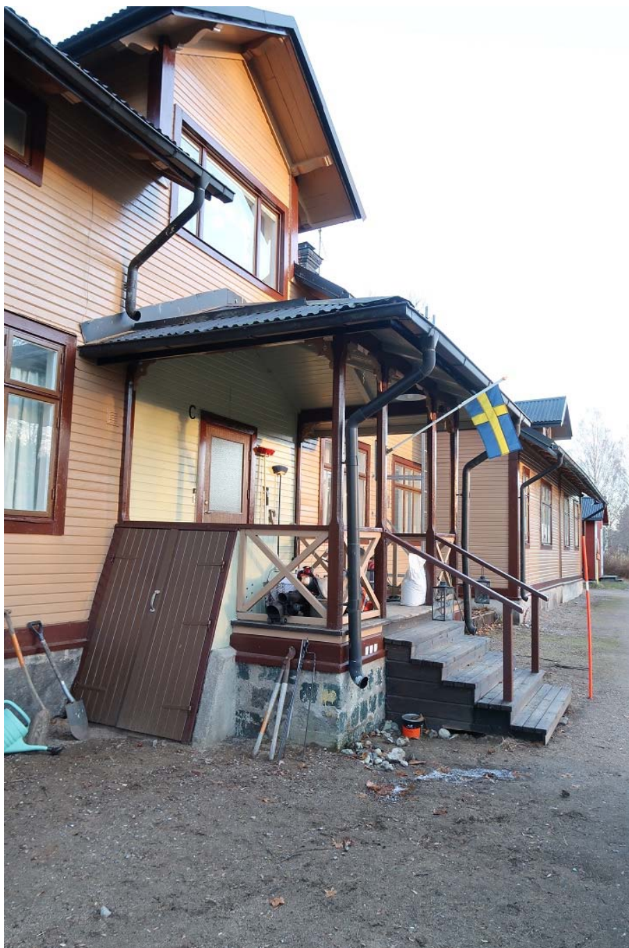
Figur 11. Den västra sidan efter avslutade arbeten. Källarporten är nytillverkad med den gamla som förlaga. Notera också att misspyrdande sentida delar på verandan har tagits bort i och med detta projekt. Verandan är åter ett smycke på byggnaden. Foto: Ulrika Olsson, Länsmuseet Gävleborg, 2017-11-27.
