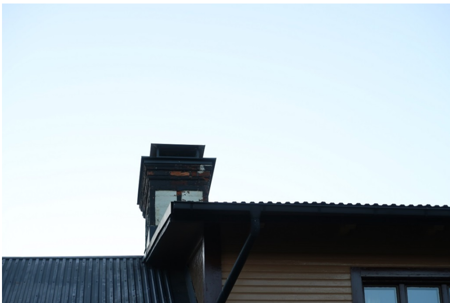
Figur 14. Vid slutbesiktningen var alla skorstensbeslag målade i svart kulör. När väderleken tillåter ska sällskapet själva måla skorstenarna. Foto: Ulrika Olsson, Läns museet Gävleborg, 2017-11-27.
