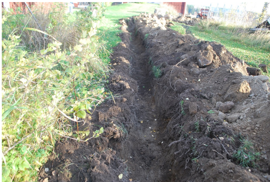
Figur 3. Den del av schaktet vid RAÄ 4:1-3 som löper i NNÖ-SSV vid RAÄ 4:1-3. Foto taget från SSV. Foto: Inga Blennå.
