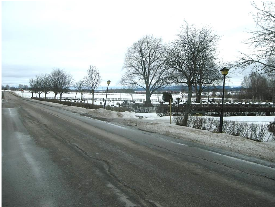
Figur 10. Efter att väg 743 hade höjts och breddats i ett antal omgångar saknade kyrkogården en egentlig avgränsning mot landsvägen. Foto från nordväst. Foto: Daniel Olsson, Läns museet Gävleborg 2016-03-14.
