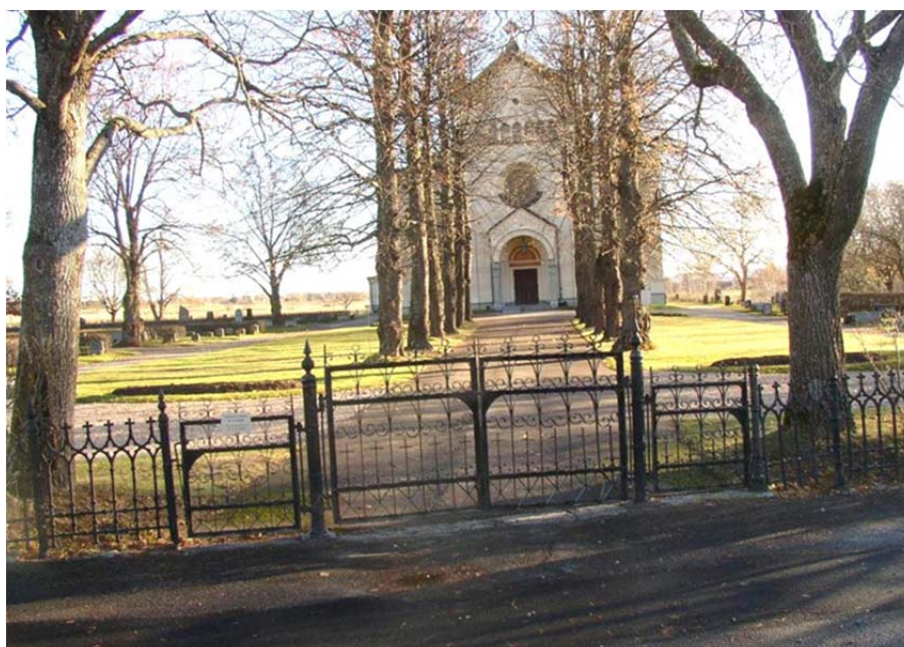
Figur 7. Grindpartiet vid kyrkogårdens huvudentré från väster före renoveringen. Foto: Daniel Olsson, Läns museet Gävleborg 2007-11-01.
