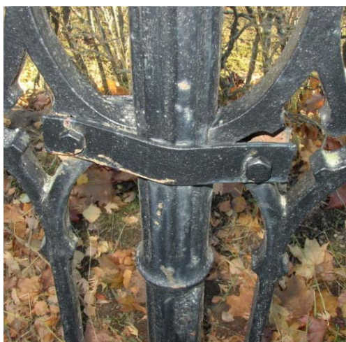
Figur 14. Detalj av tidigare lagning. Foto: Daniel Olsson, Läns museet Gävleborg 2007-11-01.
