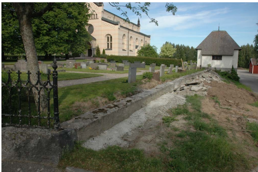
Figur 18. Påbörjat omsättningsarbete av stensockeln på kyrkogårdens södra sida. Foto från sydväst. Foto: Daniel Olsson, Läns museet Gävleborg 2016-06-15.
