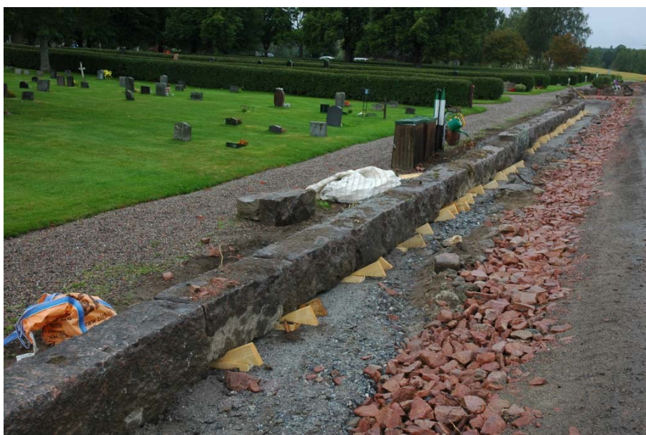
Figur 19. Den omsatta stensockeln mot norr förberedd med träkilar inför undergjutningen. Foto från nordöst. Foto: Daniel Olsson, Läns museet Gävleborg 2016-08-29.
