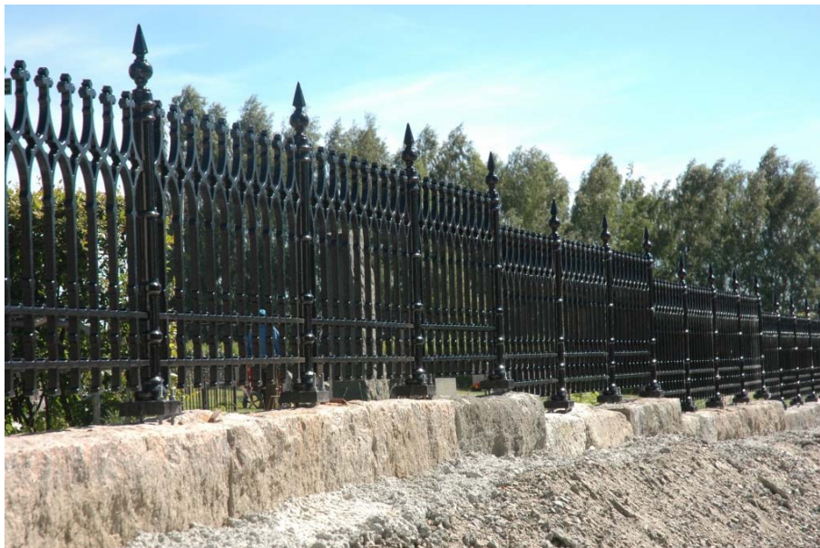
Figur 21. Detalj av det återuppsatta gjutjärnsstaketet. Foto: Daniel Olsson, Läns museet Gävleborg 2016-07-06.
