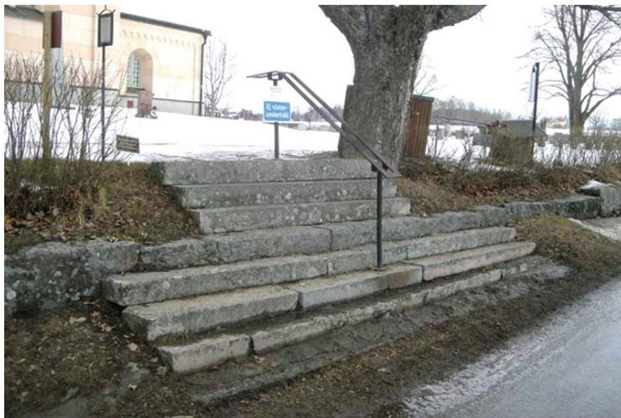
Figur 6. Trappan vid den östra delen av kyrkogården innan renoveringen inleddes. Foto från sydöst. Foto: Daniel Olsson, Läns museet Gävleborg 2016-03-14.
