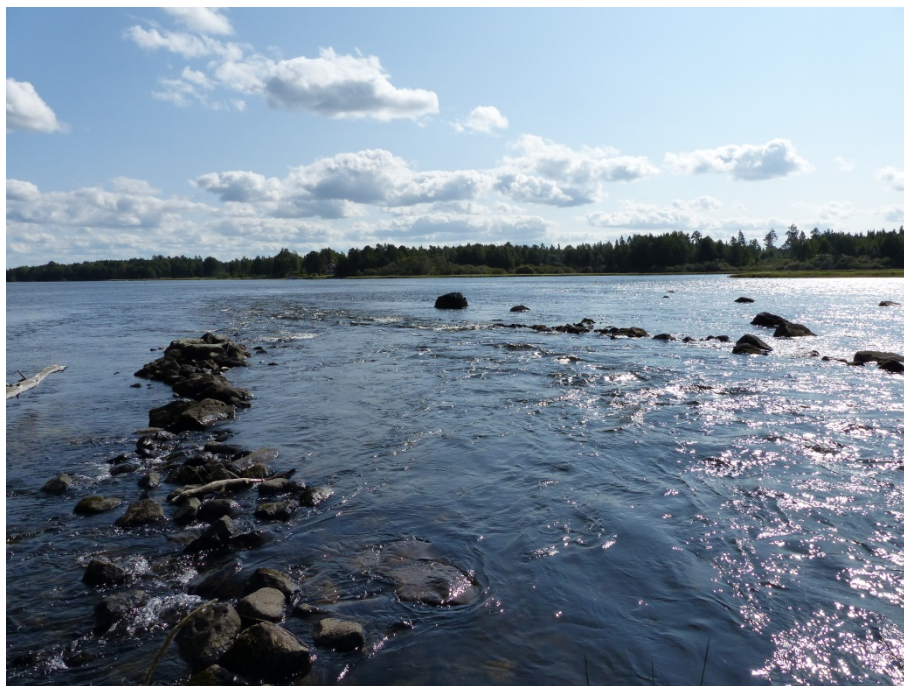
Bild 4. Flottningsränna i form av två ledarmar vid Lillslen (Österfärnebo 802). Foto Maria Björck.
