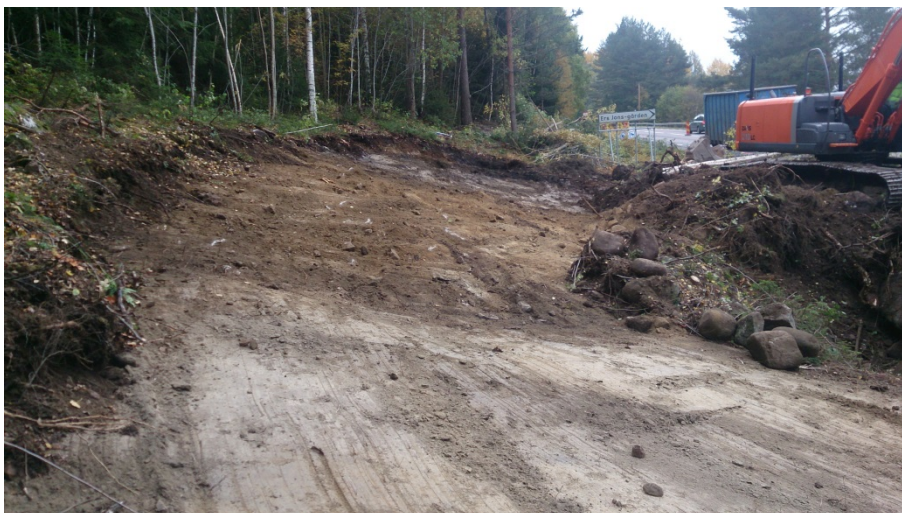
Figur 4. Schaktet sett från väster. Foto: Inga Blennå.
