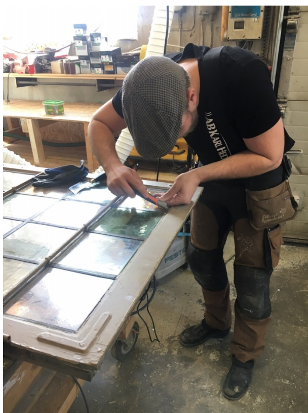
Figur 75. Oskar Källberg under arbetet med lagning av blyspröjs och lösa stormjärn, 2017-04-28. Foto: Ulrika Olsson, Läns museet Gävleborg.
