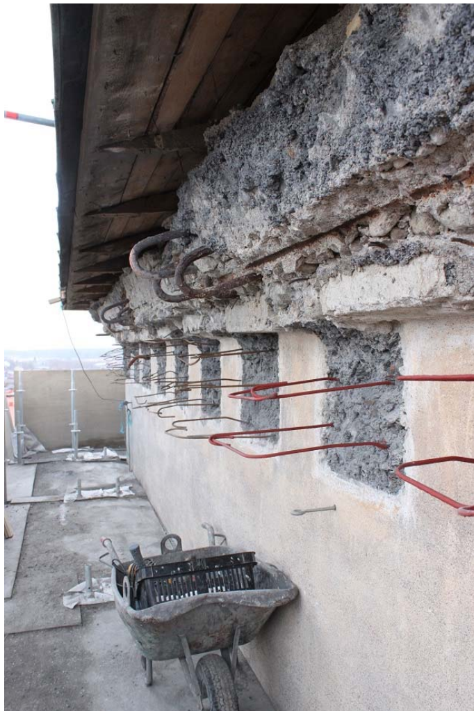
Figur 25. Tandsnittsfriksen och den ovanliggande profilerade listen är bortbilade. Rostskyddsbehandling pågår av armeringsjärnen, 2017-03-03. Foto: Ulrika Olsson, Länsmuseet Gävleborg.
