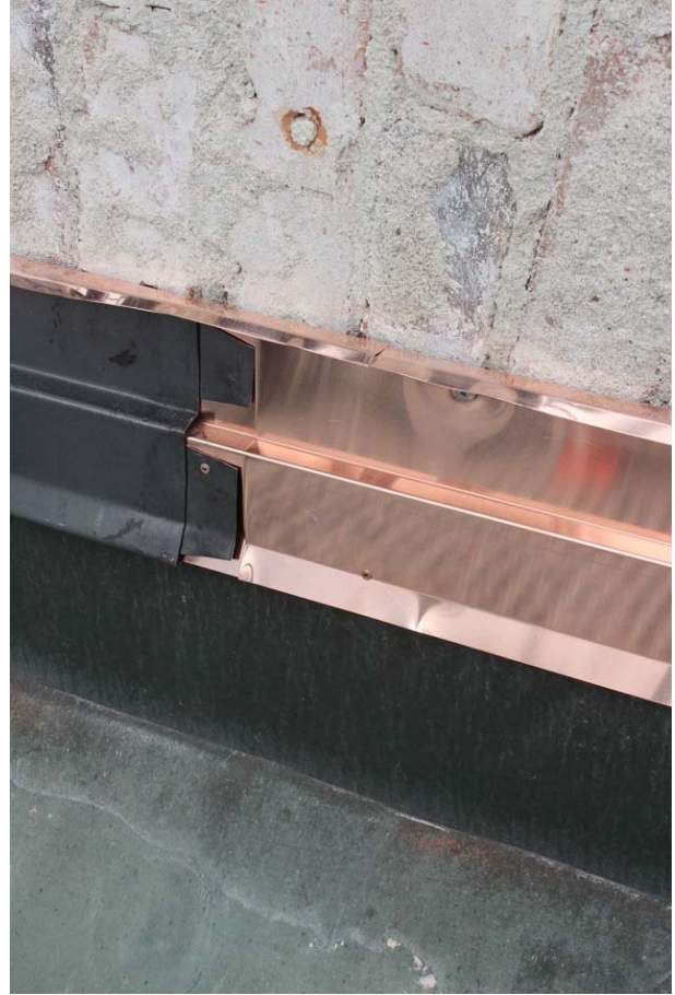
Figur 40. Utförande på befintliga ståndskivor innan påbörjade plåtarbeten, 2017-05-11. Foto: Ulrika Olsson, Läns museet Gävleborg.
