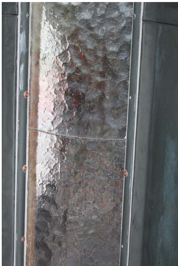
Figur 77. Sprickor och mindre håligheter i lanterninens fönsterglas har limmats ihop med TEC 7 CLEAR. Här syns hur befintliga mässingslister har fästs med nya skruvar. 2017-07-04. Foto: Ulrika Olsson, Läns museet Gävleborg.
