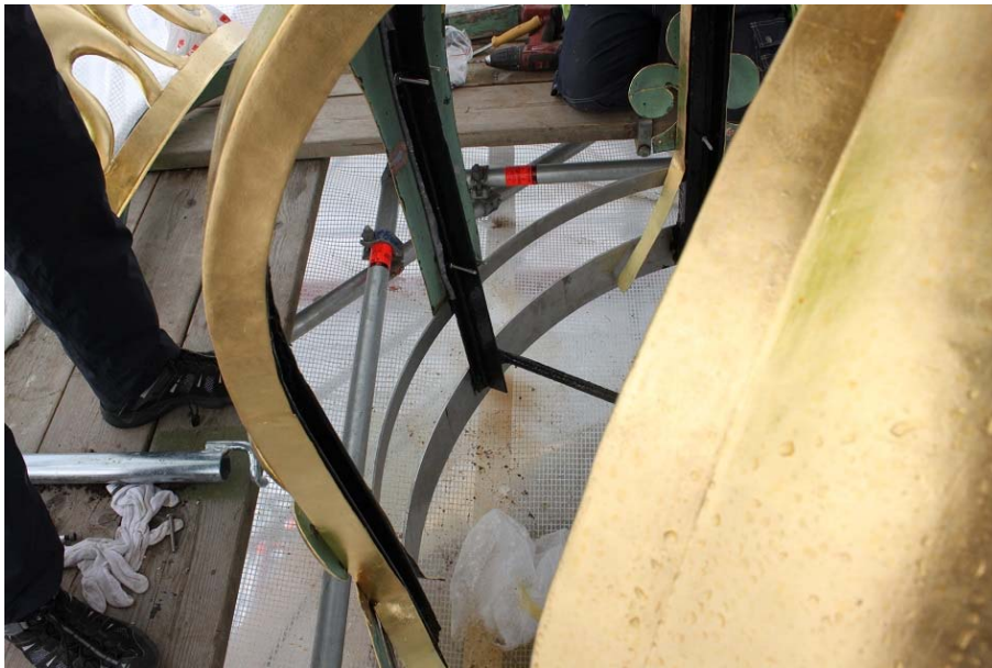
Figur 67. Kronans förgyllda delar är återmonterade. Här syns de nya delarna i smidesstommen, 2017-07-04. Foto: Ulrika Olsson, Länsmuseet Gävleborg.
