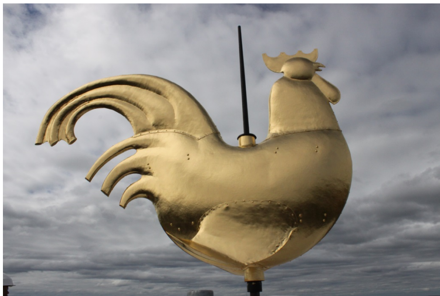
Figur 55. Förgyllningsarbetet på kyrktuppen är färdigt, 2017-07-04. Foto: Ulrika Olsson, Läns museet Gävleborg.
