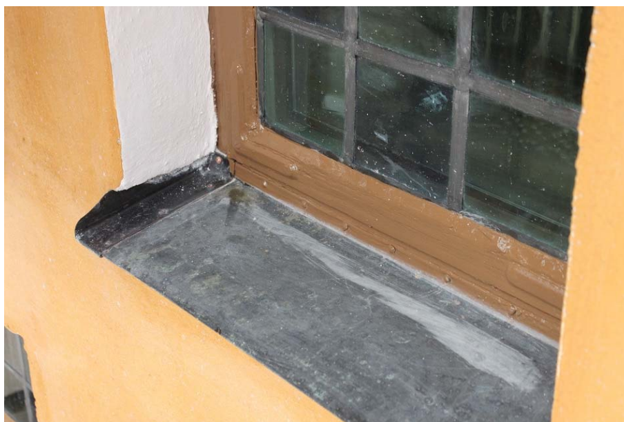
Figur 48. Exempel på med lösa så kallade påhängsgavlar med putskant vid ett av tornets fönster, 2017-09-21. Foto: Ulrika Olsson, Läns museet Gävleborg.
