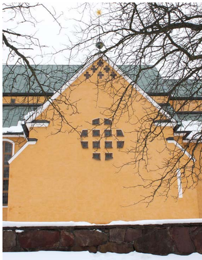
Figur 49. Ventilationsöppning på västgaveln, med nya skydd enligt beskrivning, 2017-09-21. Foto: Ulrika Olsson, Länsmuseum Gävleborg.
