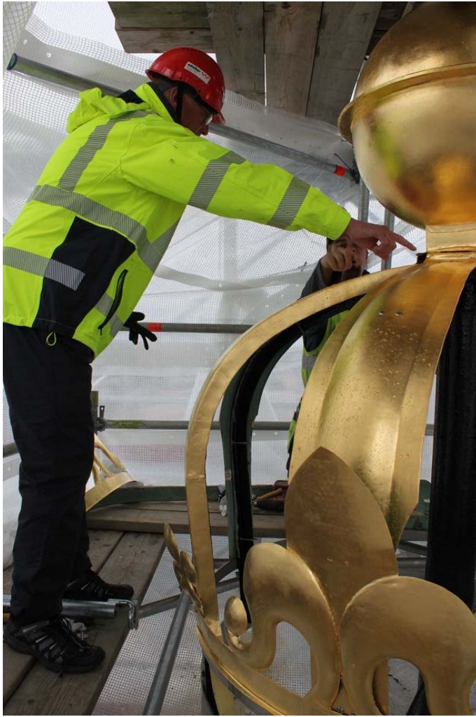
Figur 68. Kronan efter avslutade arbeten, 2017-07-04. Foto: Ulrika Olsson, Länsmuseet Gävleborg.
