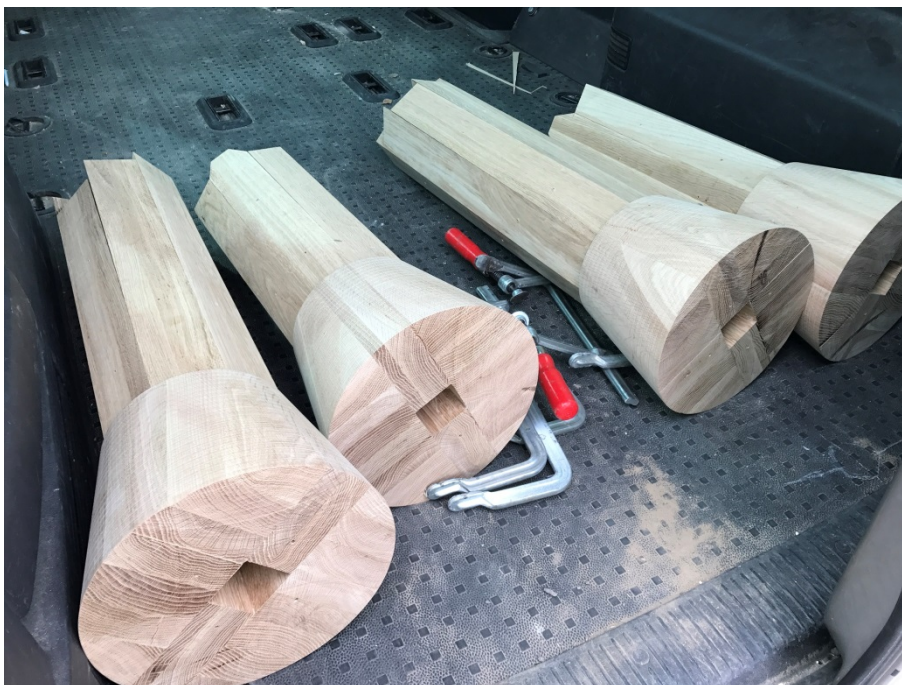
Figur 61. De nya delarna till korset har samma konstruktion som det tidigare korset, 2017-04-20. Foto: Winther Bygg AB.
