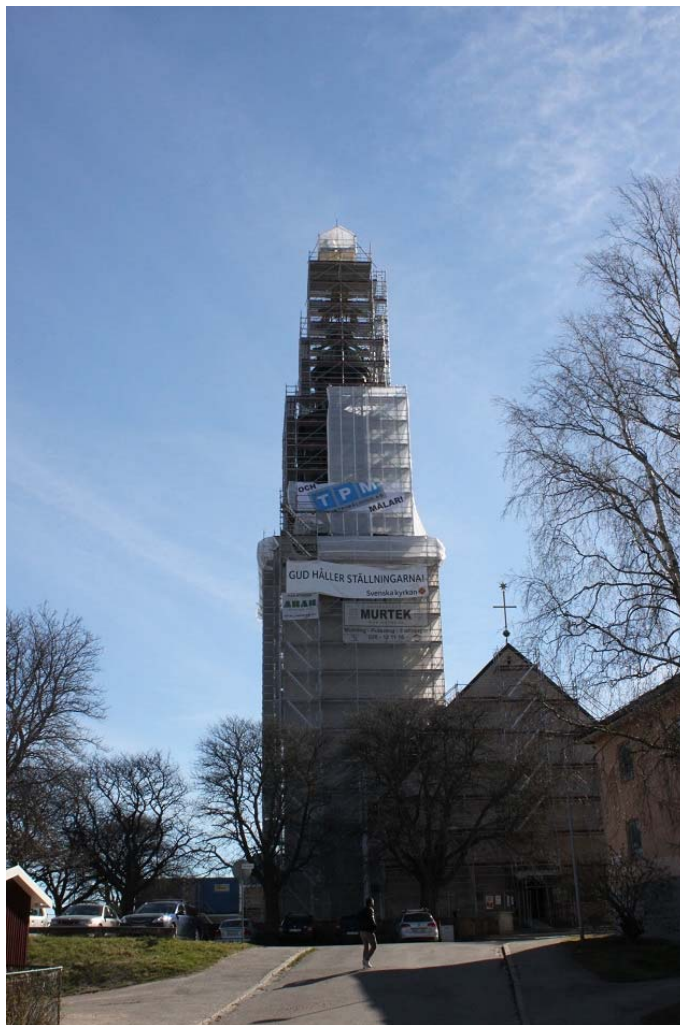
Figur 51. Ställningen restes ända upp till kyrktuppen på 56 meters höjd. Kring tuppen byggdes ett tält som skydd för förgyllarna vid deras arbete, 2017-05-05. Foto: Ulrika Olsson, Läns museet Gävleborg.
