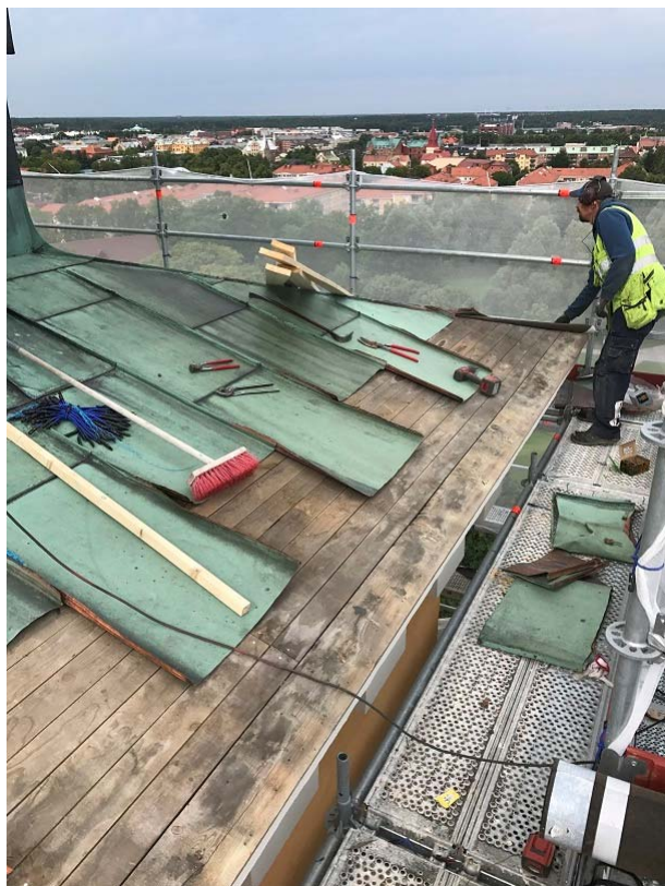
Figur 35. Rivning av plåt på tornhuven, 2017-08-11. Foto: Winther Bygg AB.
