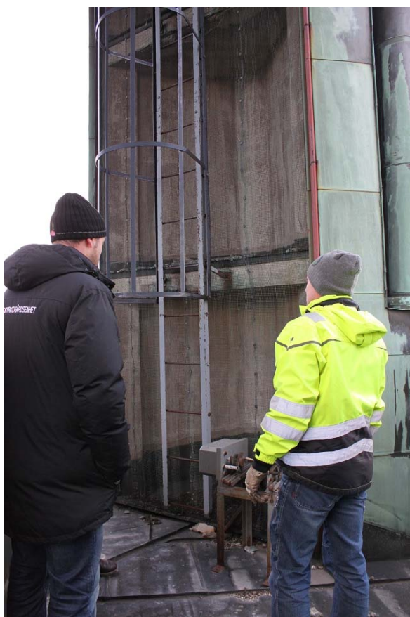
Figur 16. I en av de öppna gjutna pilastrarna satt stegen som nådde upp till avsatsen. Pilasterns öppna yta var nätad, för att stänga ute fåglar. 2015-12-02. Foto: Ulrika Olsson, Läns museet Gävleborg.
