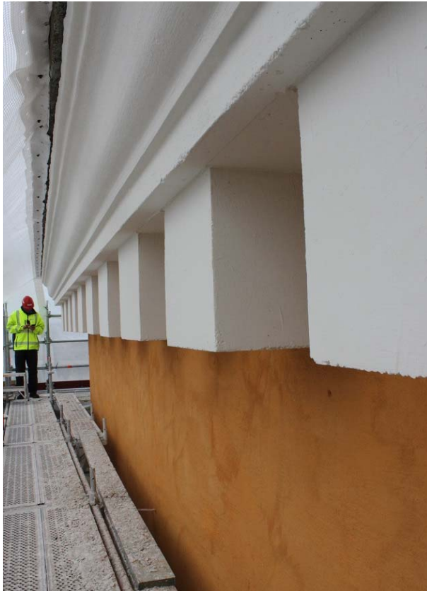
Figur 30. Såväl tänder som ovanliggande profilerad list är målad med vit silikatfärg, Keim Granital, 2017-07-04. Fasaden är nystruken med kalkfärg. Foto: Ulrika Olsson, Länsmuseet Gävleborg.
