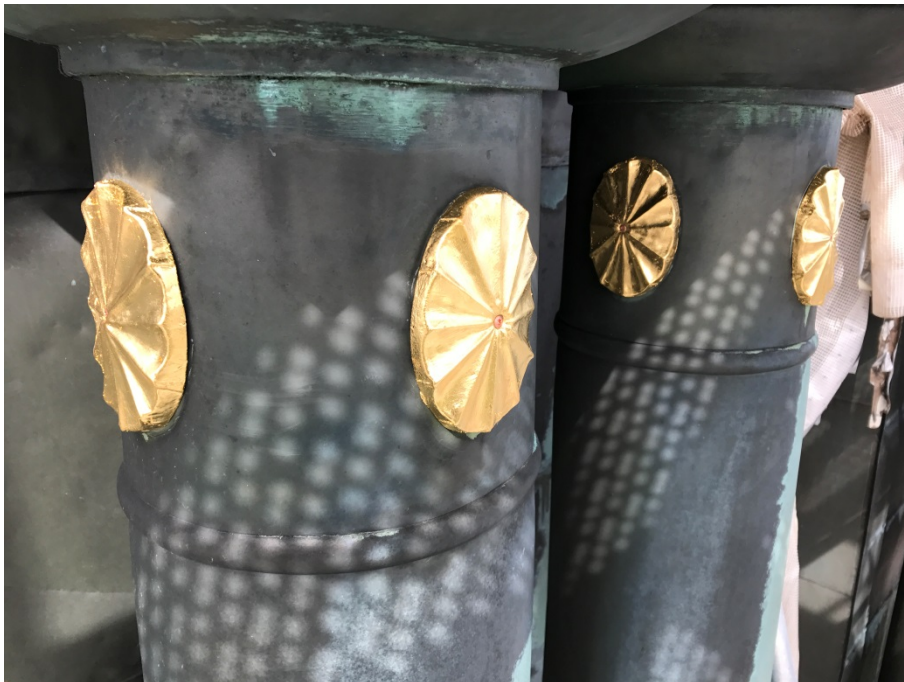
Figur 72. Medaljongerna på pelarna är återmonterade efter förgyllning på verkstad, 2017-07-04. Foto: Winther Bygg AB.
