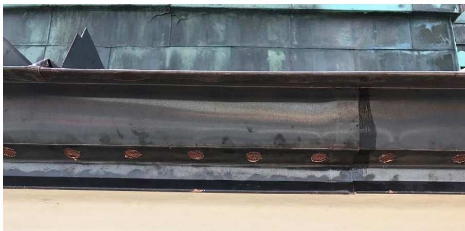
Figur 38. Det nya språngblecket sett snett nerifrån. Här syns de perforerade hålen som möjliggör luftning av den underliggande konstruktionen, 2017-08-15. Foto: Ulrika Olsson, Läns museet Gävleborg.
