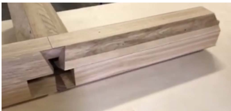
Figur 58. Sammanfogningen av de nya trädelarna till korset. Skärmdump från film som Lennartsson Snickeri har på sin Facebooksida.
