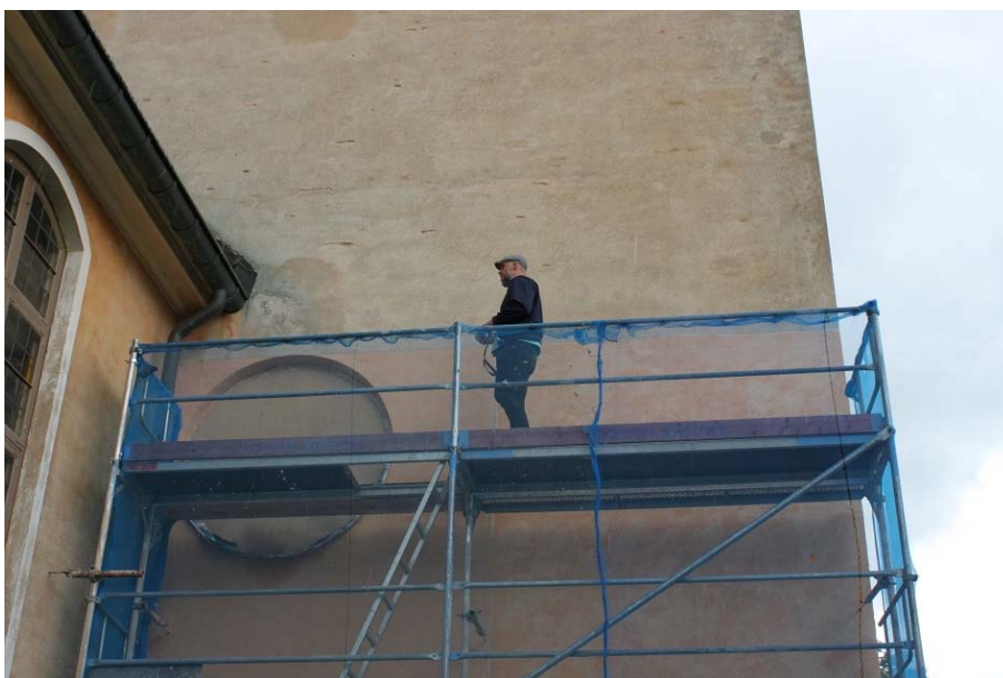
Figur 5. Inspektion av provytor på tornets östra sida, 2015-06-25. Till vänster bakom den nätade ställningen syns en provyta avfärgad med kalkfärg, till höger en provyta avfärgad med järnvitriol. På bilden syns putskonsulten David Pettersson, Byggkultur. Foto: Ulrika Olsson, Läns museet Gävleborg.
