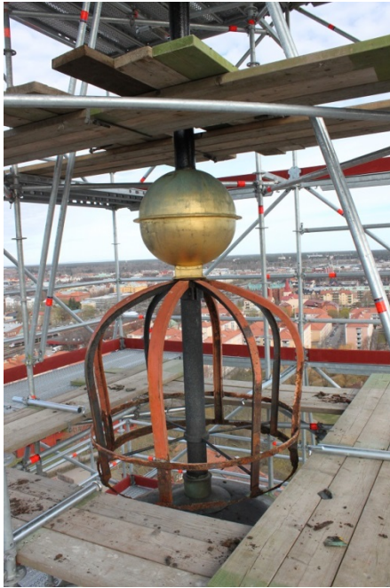
Figur 65 och 66. Kronans förgyllda delar demonterades. Smidesstommen var hårt ansatt av rostangrepp. 2017-05-05. Foto: Ulrika Olsson, Länsmuseet Gävleborg.
