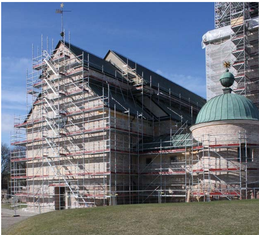
Figur 22. Nerknackning av puts pågår, 2017-05-05. Stora ytor av putsen har bilats och knackats ner. Foto från nordöst. Foto: Ulrika Olsson, Länsmuseet Gävleborg.
