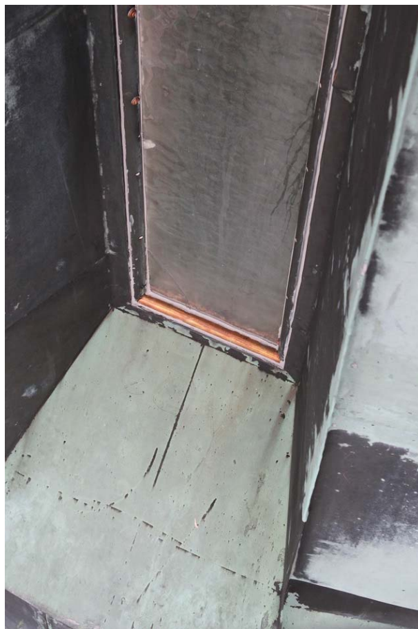
Figur 77. Sprickor och mindre håligheter i lanterninens fönsterglas har limmats ihop med TEC 7 CLEAR. Här syns hur befintliga mässingslister har fästs med nya skruvar. 2017-07-04. Foto: Ulrika Olsson, Läns museet Gävleborg.
