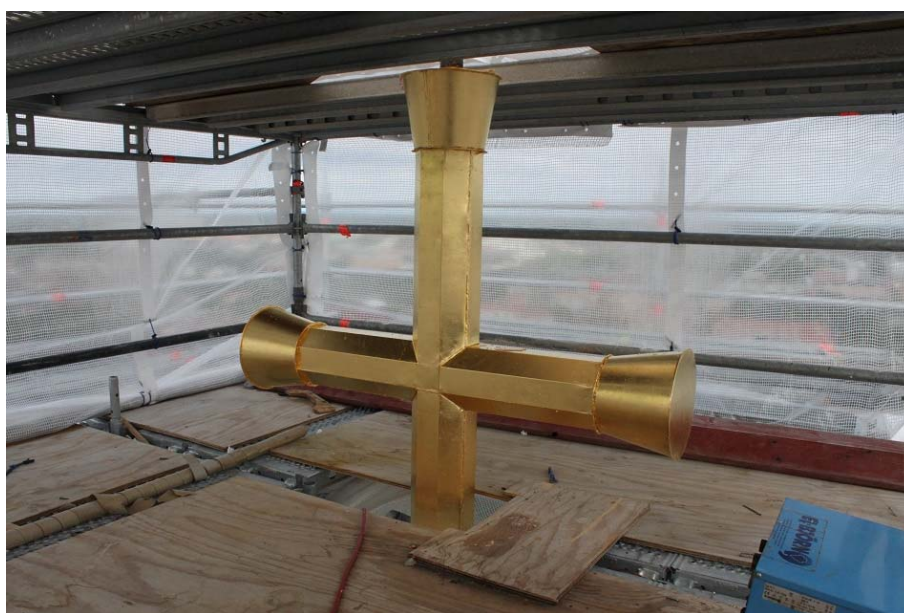
Figur 63. Korset efter avslutade arbeten, 2017-07-04. Foto: Ulrika Olsson, Länsmuseum Gävleborg.
