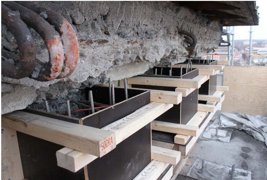
Figur 26. Gjutformar för tänderna är iordningsställda, 2017-03-03. Foto: Ulrika Olsson, Läns museet Gävleborg.
