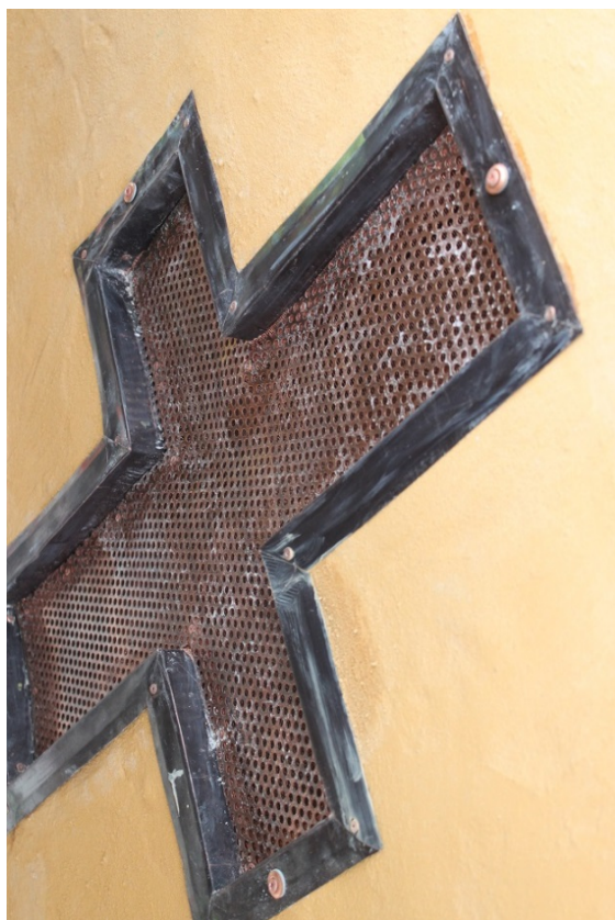
Figur 49. Ventilationsöppning på västgaveln, med nya skydd enligt beskrivning, 2017-09-21. Foto: Ulrika Olsson, Länsmuseum Gävleborg.
