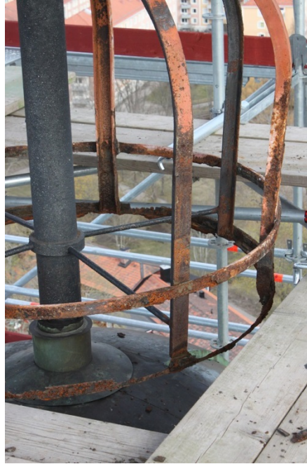
Figur 65 och 66. Kronans förgyllda delar demonterades. Smidesstommen var hårt ansatt av rostangrepp. 2017-05-05. Foto: Ulrika Olsson, Länsmuseet Gävleborg.
