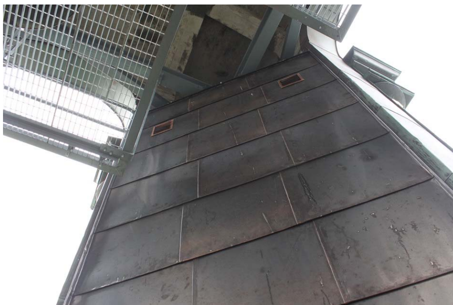
Figur 82. Under projektet har de tidigare öppna pilastrarna renoverats och klänts in med kopparplåt, 2017-09-21. Foto: Ulrika Olsson, Länsmuseet Gävleborg.
