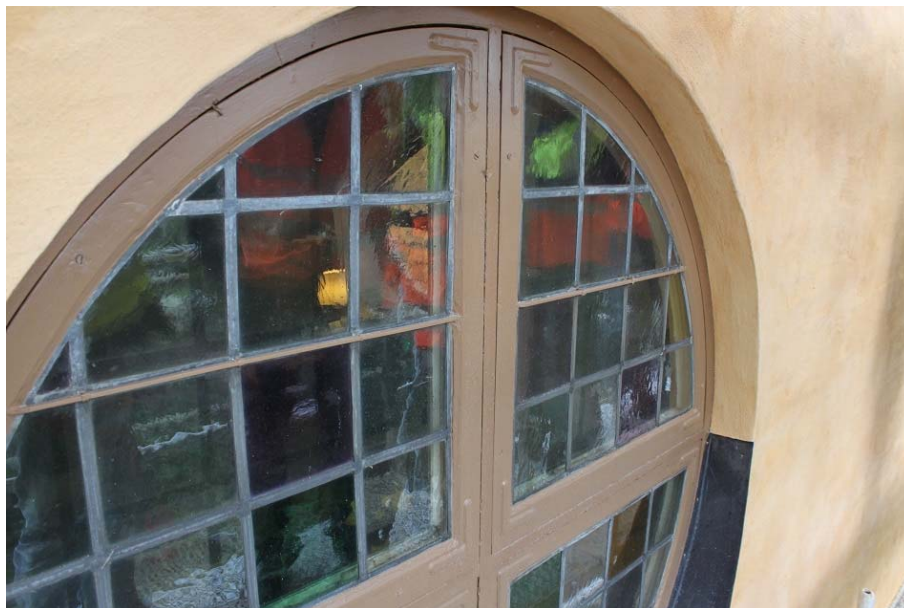
Figur 80. Ett av tornets runda fönster efter avslutade arbeten, 2017-09-21. Foto: Ulrika Olsson, Läns museet Gävleborg.
