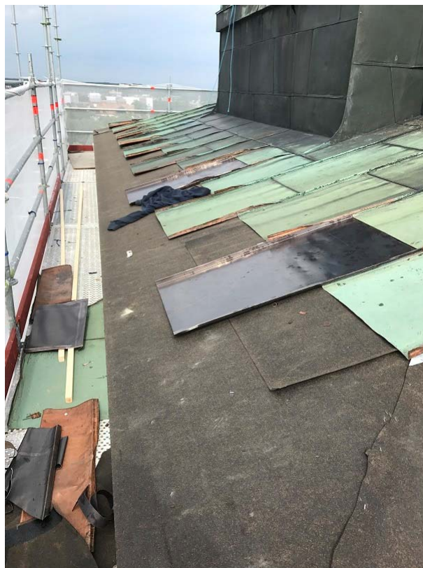
Figur 35. Rivning av plåt på tornhuven, 2017-08-11. Foto: Winther Bygg AB.
