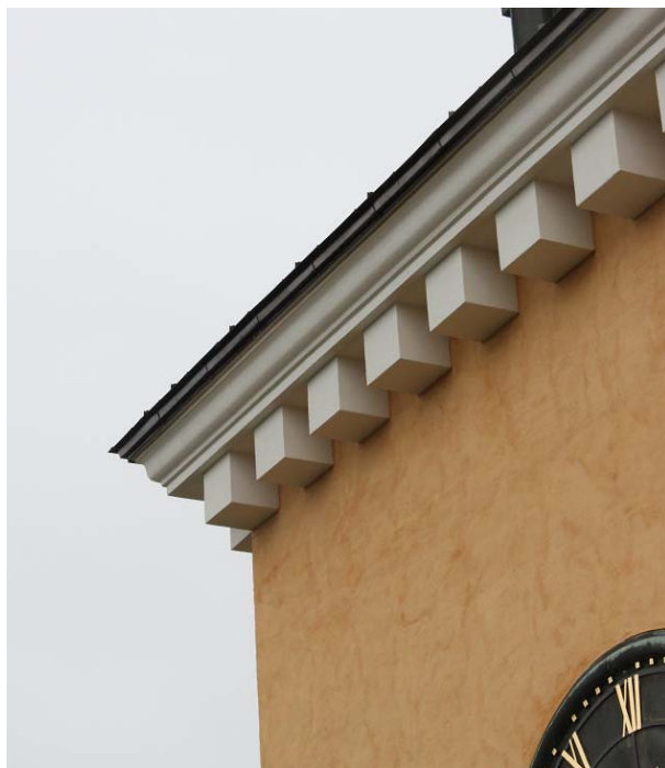
Figur 39. Tornpartiet sett efter avslutade arbeten. Gjutna tänder och slät list, ovanliggande murad profilerad list samt ny utformning av språngbleck, 2017-09-21. Foto: Ulrika Olsson, Läns museet Gävleborg.
