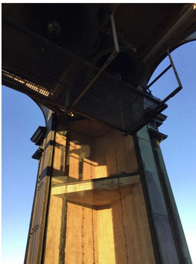
Figur 16. I en av de öppna gjutna pilastrarna satt stegen som nådde upp till avsatsen. Pilasterns öppna yta var nätad, för att stänga ute fåglar. 2015-12-02. Foto: Ulrika Olsson, Läns museet Gävleborg.
