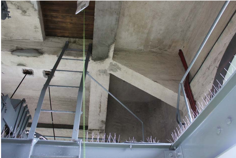
Figur 86. Från grettingsplanet leder en fast stege upp till järnbalkarna och från dessa leder ytterligare en fast stege vidare upp till lanterninrummet, 2017-09-21. Foto: Ulrika Olsson, Läns museet Gävleborg.
