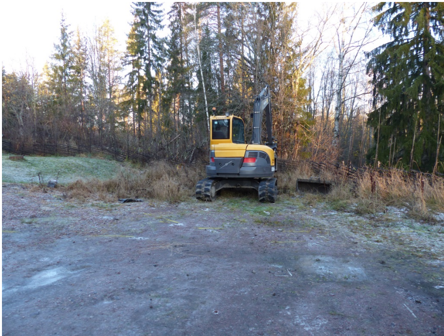
Figur 5. Grävmaskinen står på utredningsområdet. Ytan är urschaktad och delvis uppfylld. Notera sluttningen till vänster i bilden. Foto: Maria Björck, taget från sydöst.
