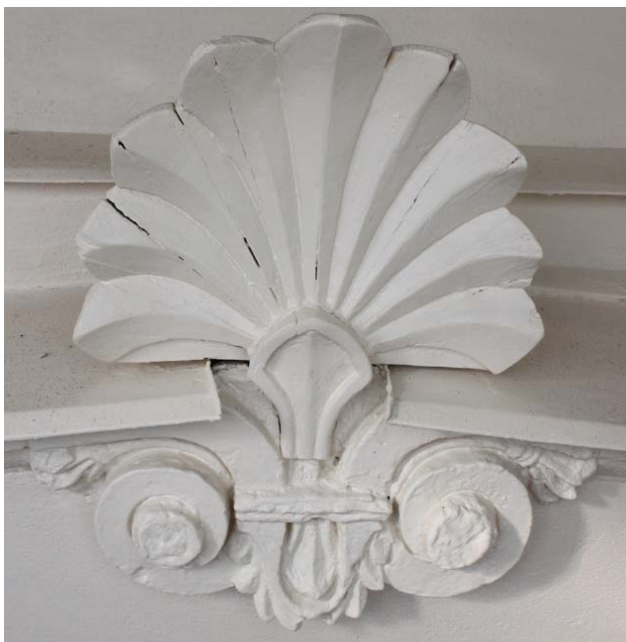
Figur 23. Akroterion efter avslutade arbeten. Figur 17. Delar av den bytta fotrännan. Foto: Ulrika Olsson, Läns museet Gävleborg, 2018-04-16.
