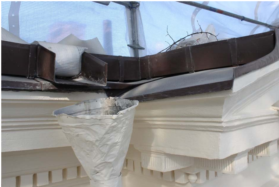
Figur 20. Delar av den bytta fotrännan. Vattkupan är ännu inte bytt. Foto: Ulrika Olsson, Länsmuseet Gävleborg, 2018-04-16.
