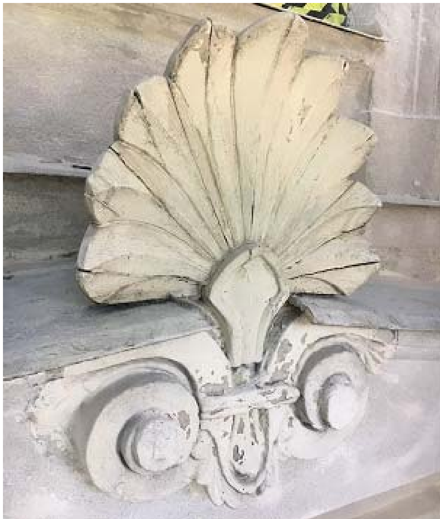
Figur 9. Akroterion innan påbörjade arbeten. Foto: Ulrika Olsson, Länsmuseet Gävleborg, 2017-18-28.
