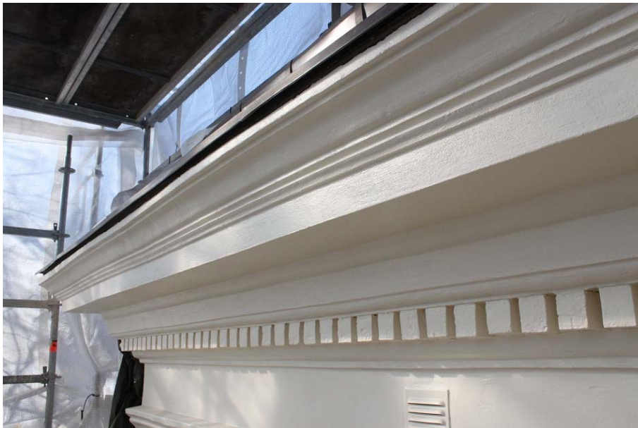
Figur 17. Färdigmålad takfot. Foto: Ulrika Olsson, Läns museet Gävleborg, 2018-04-16.
