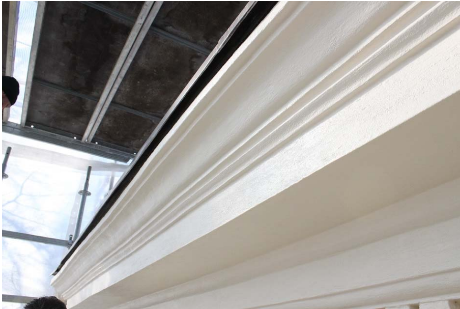
Figur 18. Färdigmålad takfot. Foto: Ulrika Olsson, Länsmuseet Gävleborg, 2018-04-16.
