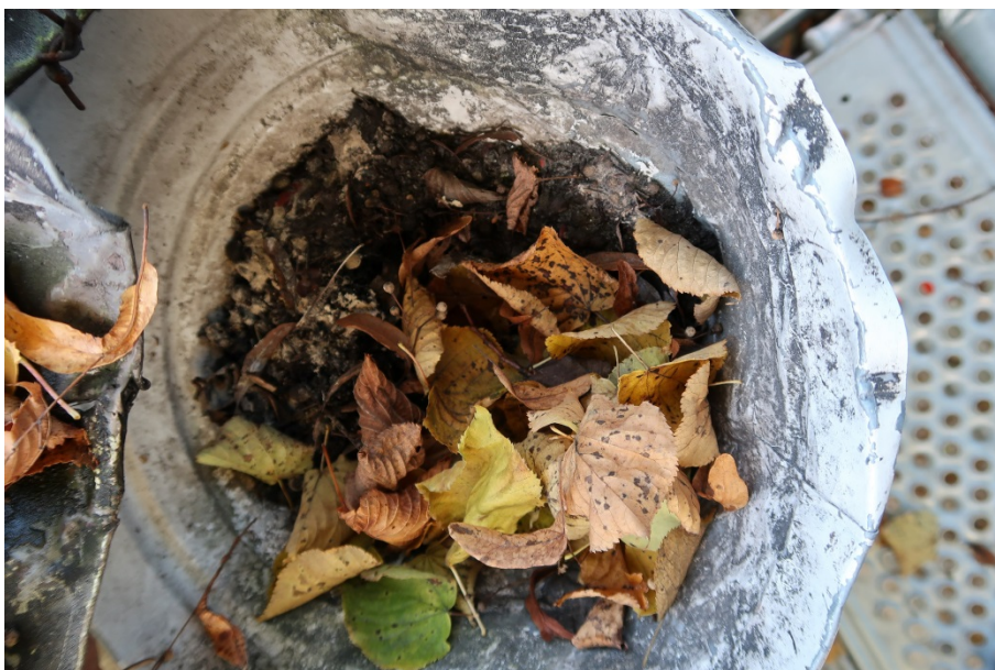
Figur 6. Lövfylld vattkupa, där löven till och med har förmultnat till jord. Foto: Ulrika Olsson, Läns museet Gävleborg, 2017-10-16.
