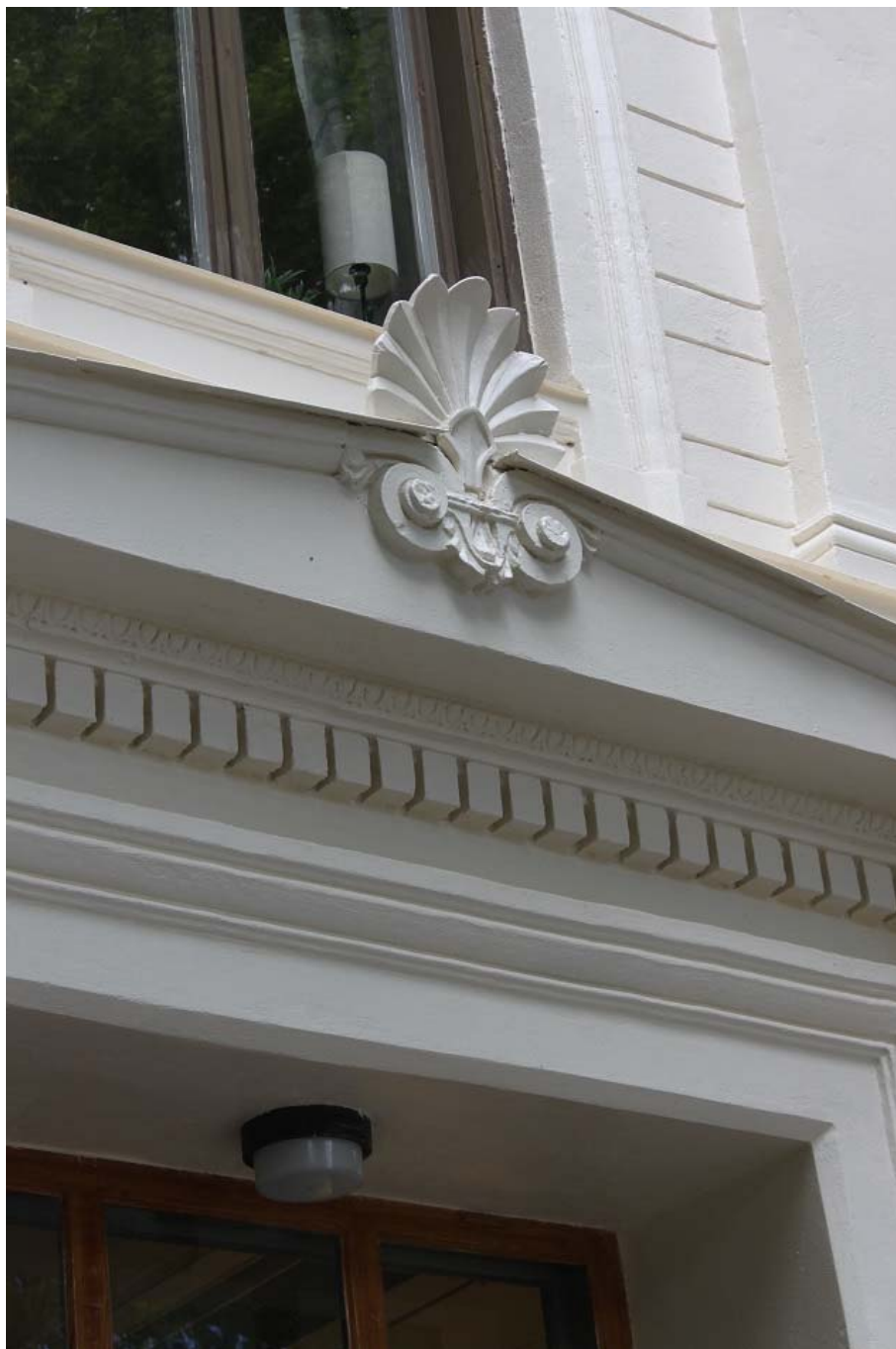
Figur 24. Akroterion efter avslutade arbeten. Foto: Ulrika Olsson, Länsmuseet Gävleborg, 2018-04-16.
