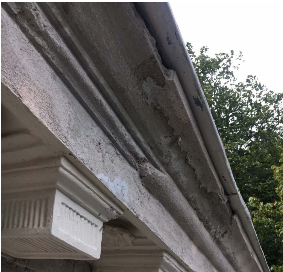
Figur 12. Bakom sentida dragna, kraftigt förenklade, profiler, dolde sig den ursprungliga profileringen. Foto: Ulrika Olsson, Läns museet Gävleborg, 2017-09-04.
