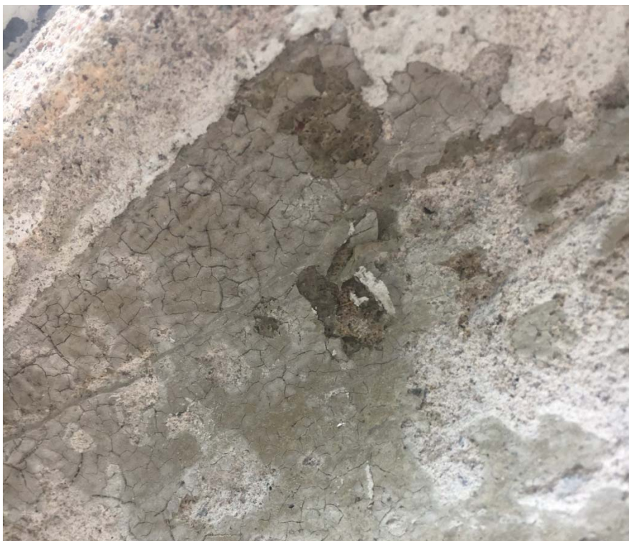
Figur 11. Den krackelerade ytan utgörs av det understa putsskiktet, målat med ljusgrå linoljefärg. Foto: Ulrika Olsson, Läns museet Gävleborg, 2017-09-04.
