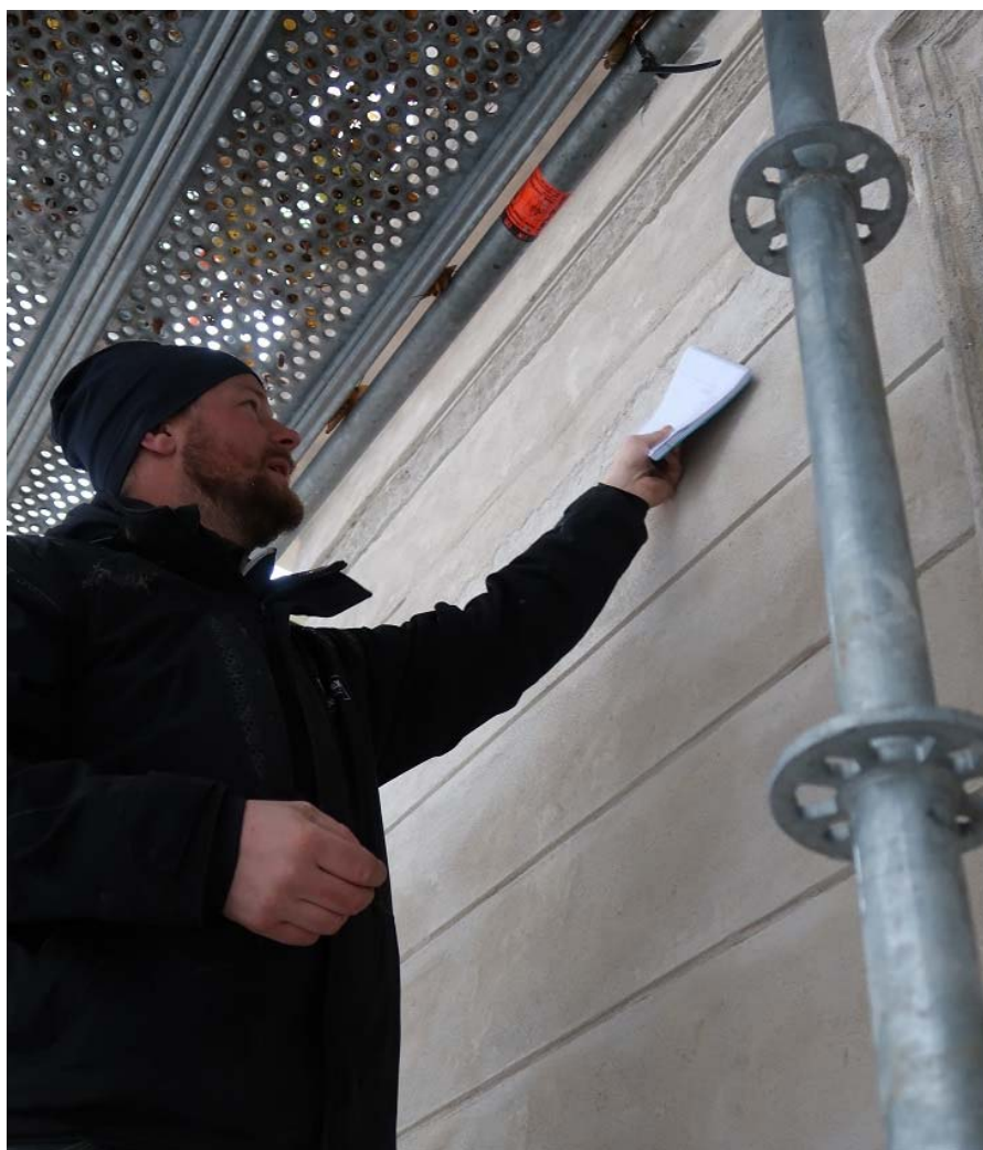
Figur 13. Arbetet med putsningen är igång. Platsbesök ihop med Adam Steinwall från Murtek. Foto: Ulrika Olsson, Länsmuseet Gävleborg, 2017-10-25.
