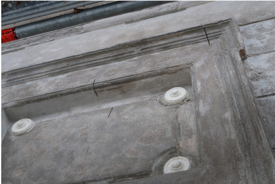
Figur 14. Snitten i profilerna görs för att ta fram nya profilerade brädor att dra bruket med. Foto: Ulrika Olsson, Länsmuseum Gävleborg, 2017-10-25.
