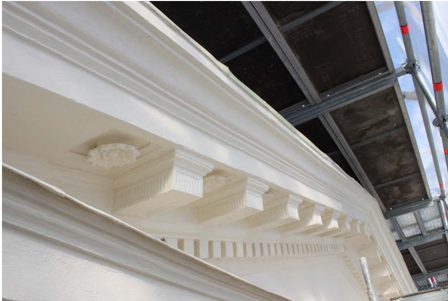
Figur 16. Tympanonfältets puts är färdigmålad med linoljefärg. Foto: Ulrika Olsson, Läns museet Gävleborg, 2018-04-16.
