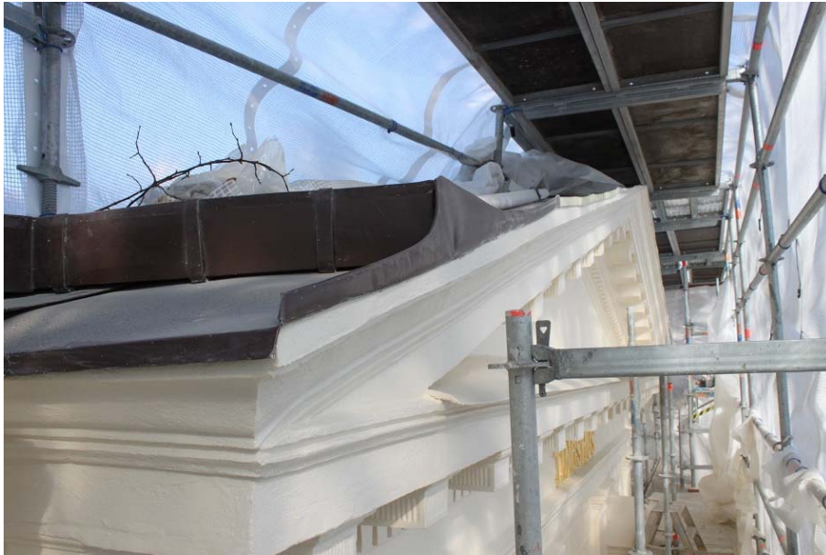
Figur 19. Delar av den bytta fotrännan. Foto: Ulrika Olsson, Länsmuseet Gävleborg, 2018-04-16.
