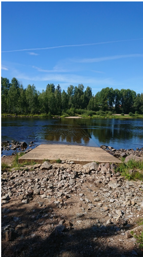
Figur 12. Objekt 24, bro bestående av en betongplatta som till stor del ligger under nuvarande vattenyta. Överfarten kallas "militärvägen". Bilden är tagen från öster.
