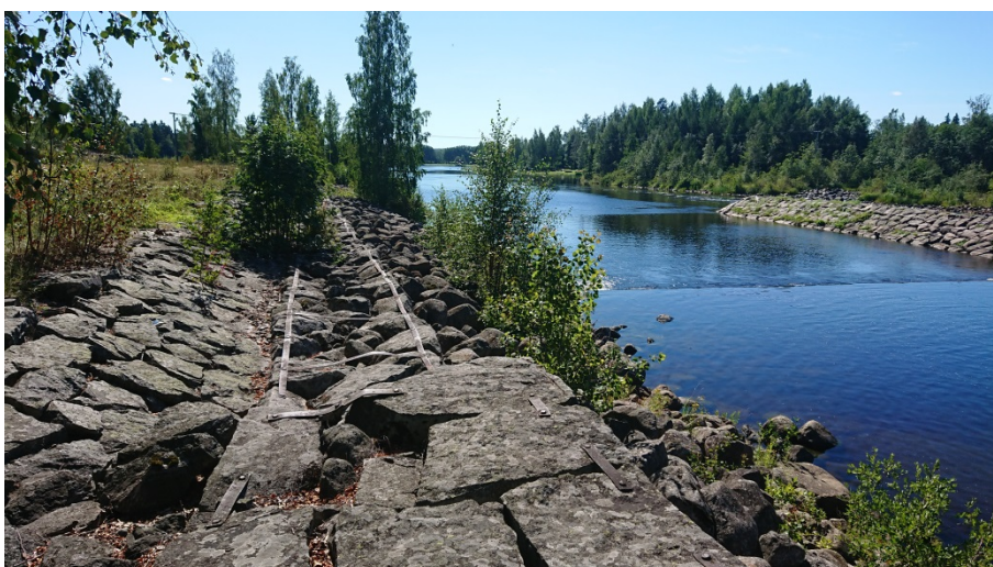
Figur 4. Objekt 5, flottningsränna bestående av ledarm och strandskoning. Bilden visar södra delen från Renbron, östra sidan av Ljusnan, och är tagen från norr.
