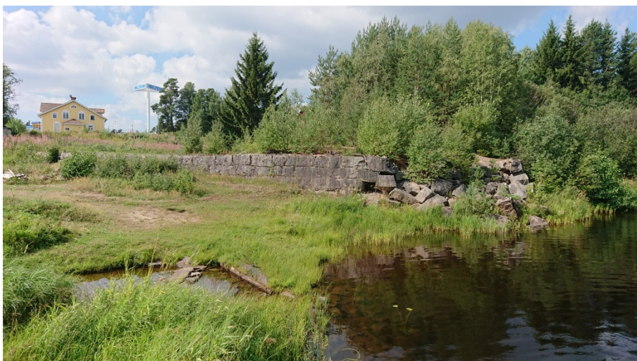
Figur 10. Objekt 25, L-formad dammvall. Bilden är tagen från öster.
