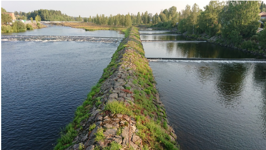
Figur 5. Objekt 5, flottningsränna med ledarm centralt i bilden, norr om Renbron. Bilden är tagen från söder.
