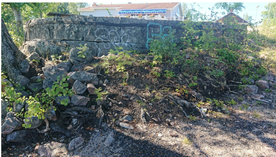
Figur 4. Objekt 2 och 3, slaggförekomst i direkt anslutning till en järnförstärkt bågformig mur. Bilden är tagen från nordöst.
