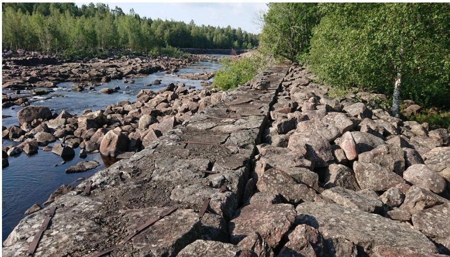
Figur 9. Objekt 21, strandskoning vars norra del ansluter till en betongmur. Bilden är tagen från norr.
