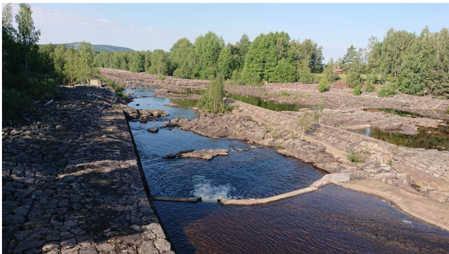
Figur 7. Objekt 10, flottningsränna bestående av ledarm och strandskoning. Bilden är tagen vid Dönje kraftverk, från nordöst.
