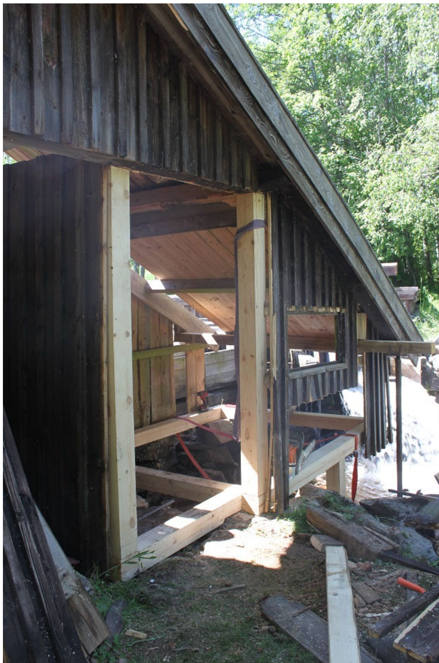
Figur 9. Arbete pågår med nya syllar och stolpar. Foto: Ulrika Olsson, Läns museet Gävleborg, 2018-05-31.
