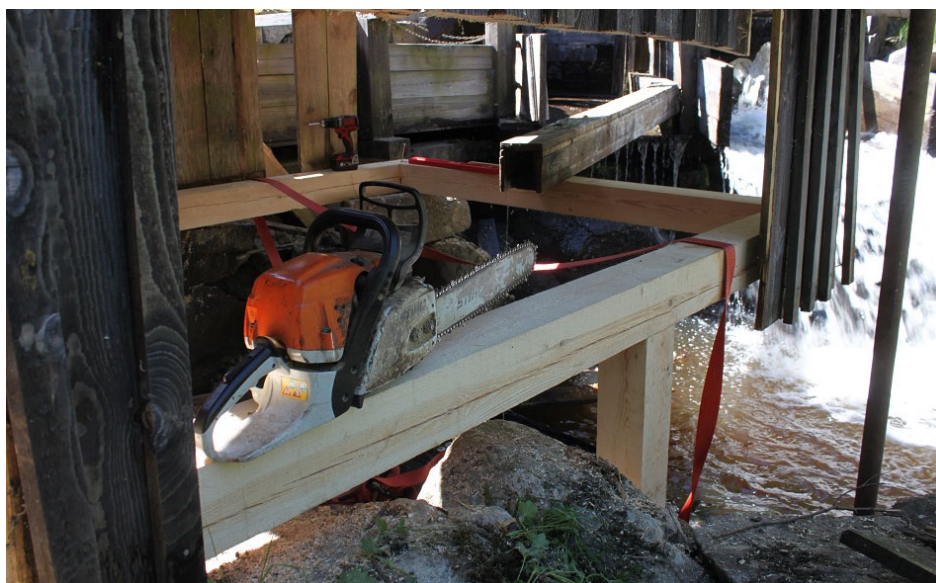
Figur 8. Arbetet pågår med nya syllar och stolpar. Foto: Ulrika Olsson, Läns museet Gävleborg, 2018-05-31.
