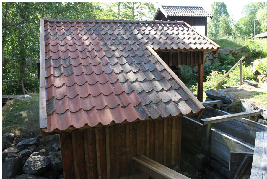
Figur 19. Arbetet med taket är avslutat. Vindskivor och vattbrädor är strukna med Roslagsmahogny. Foto: Ulrika Olsson, Läns museet Gävleborg, 2018-06-29.
