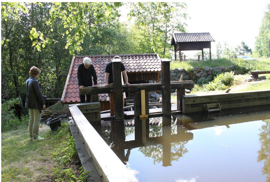
Figur 21. Dammen med dammluckor. I ljust virke syns den smala dammluckan/slussen som lyfts upp då vattens ska släppas på i duschen. Foto: Ulrika Olsson, Läns museet Gävleborg, 2018-06-29.
