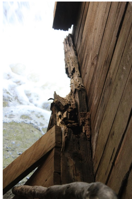
Figur 5 och 6. Duschrummet sett från omklädningsrummet. Trappan och ledstången syns närmast i bild. Bilderna visar hur omfattande skadorna var på både stomme och panel innan renoveringen. Foto: Ulrika Olsson, Läns museet Gävleborg, 2018-05-25.
