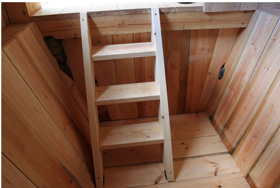
Figur 13. Trappan ner till duschen, samt duschrummets väggar och golv. Notera ursågning i panel för bakomliggande stenar. Foto: Ulrika Olsson, Läns museet Gävleborg, 2018-06-29.
