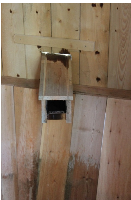
Figur 22 och 23. Närbild på den nya dammluckan/slussen som man drar upp för att släppa på vatten in i duschen. Brädan är förstärkt med en gummiduk nertill för att sluta så tätt som möjligt mot duschrörets inlopp. Till höger syns det inkommande duschröret i duschrummet. Foto: Ulrika Olsson, Läns museet Gävleborg, 2018-06-29.
