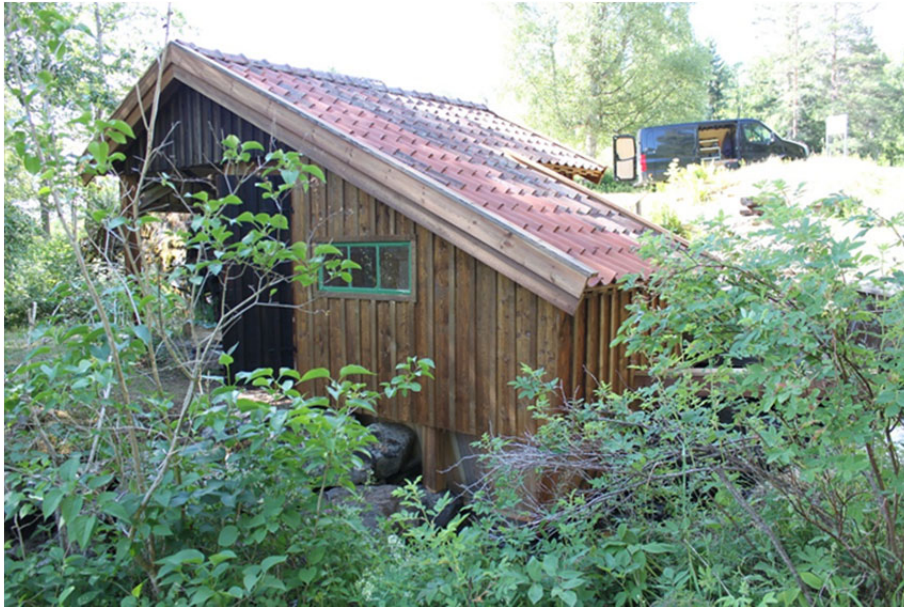
Figur 15. Duschdelen sedd från nordöst. Dammen ligger till höger utanför bild. Foto: Ulrika Olsson, Läns museet Gävleborg, 2018-06-29.
