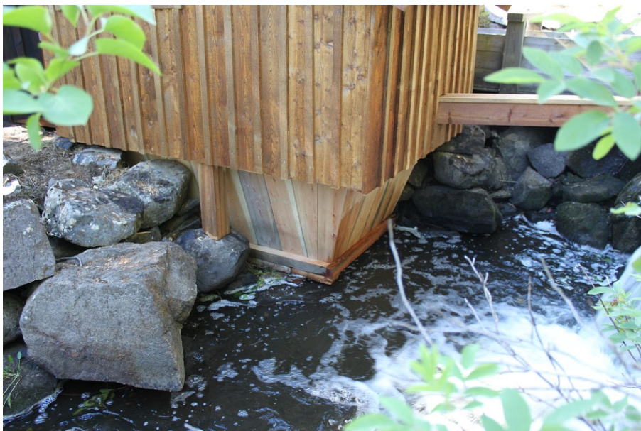
Figur 10. Här syns panelen i duschen längst ner, det inkommande duschröret till höger och duschrummets väggar klädda med locklistpanel. Dammen ligger till höger utanför bild. Foto: Ulrika Olsson, Läns museet Gävleborg, 2018-06-29.
