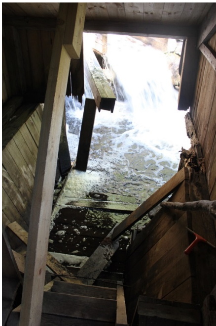
Figur 5 och 6. Duschrummet sett från omklädningsrummet. Trappan och ledstången syns närmast i bild. Bilderna visar hur omfattande skadorna var på både stomme och panel innan renoveringen. Foto: Ulrika Olsson, Läns museet Gävleborg, 2018-05-25.
