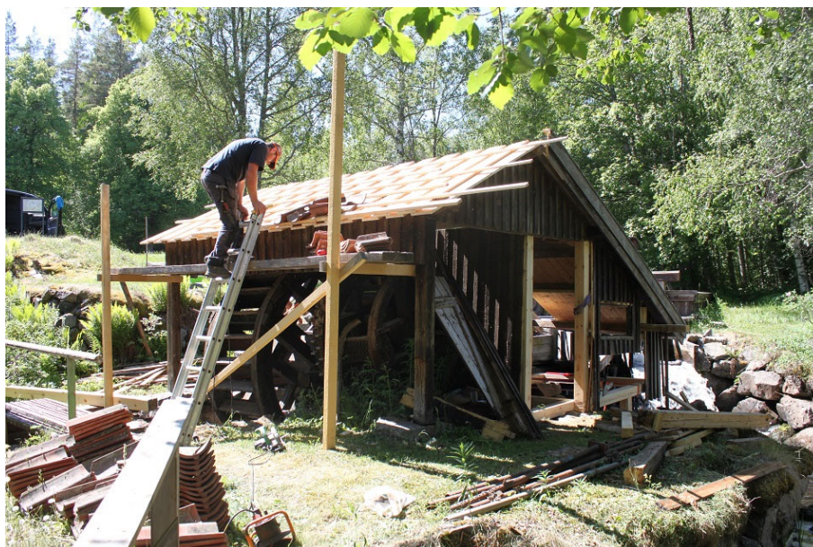
Figur 17. Det enkupiga teglet är nerplockat och arbete pågår med att montera bärläkt direkt på faltaket. Foto: Ulrika Olsson, Läns museet Gävleborg, 2018-05-31.
