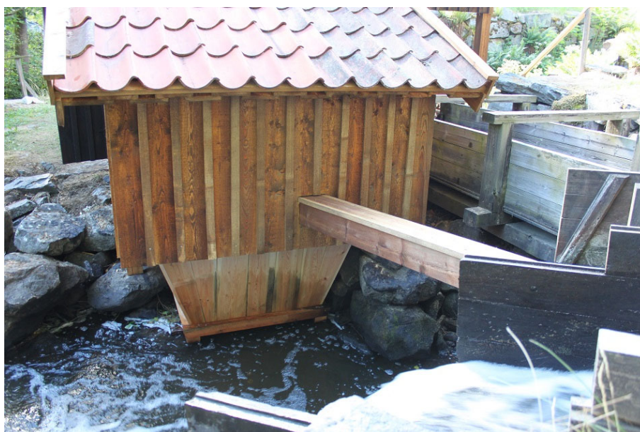
Figur 20. Duschrummet sett från dammbron. Det nya duschröret leder in från en separat dammlucka/sluss. Foto: Ulrika Olsson, Läns museet Gävleborg, 2018-06-29.
