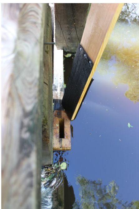
Figur 22 och 23. Närbild på den nya dammluckan/slussen som man drar upp för att släppa på vatten in i duschen. Brädan är förstärkt med en gummiduk nertill för att sluta så tätt som möjligt mot duschrörets inlopp. Till höger syns det inkommande duschröret i duschrummet. Foto: Ulrika Olsson, Läns museet Gävleborg, 2018-06-29.
