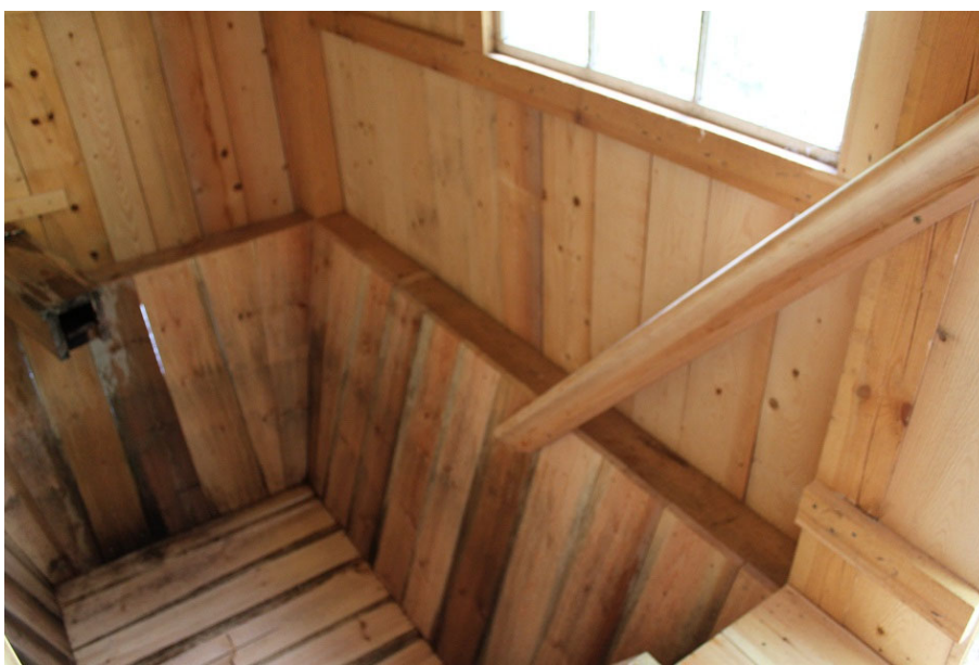
Figur 14. Efter slutbesiktningen monterades en handledare vid trappan ner till duschrummet. Foto: Ulrika Olsson, Läns museet Gävleborg, 2018-08-21.
