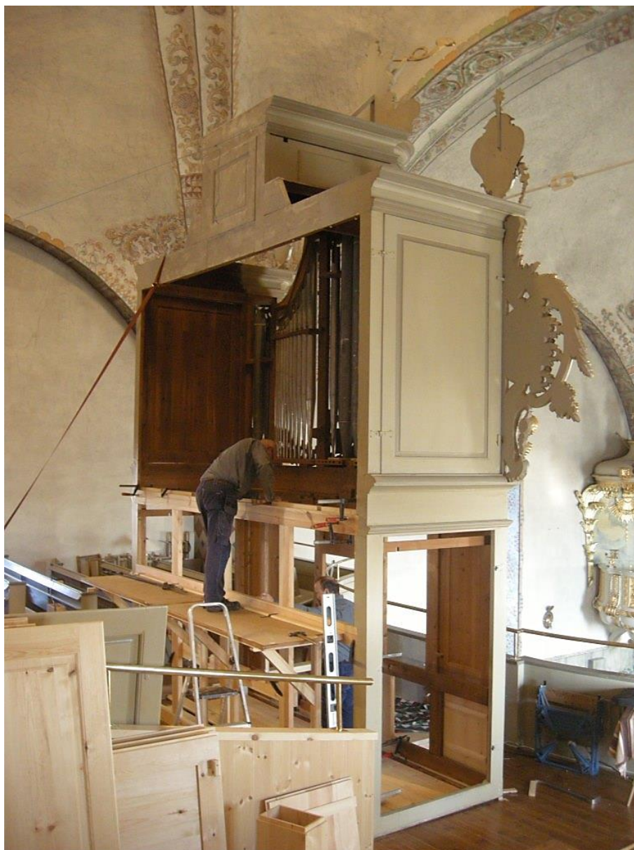
Figur 18. Gren och Stråhleorgeln under uppförande på sin nya plats. Foto från sydväst. Foto: Daniel Olsson, Länsmuseet Gävleborg 2014-10-29.
