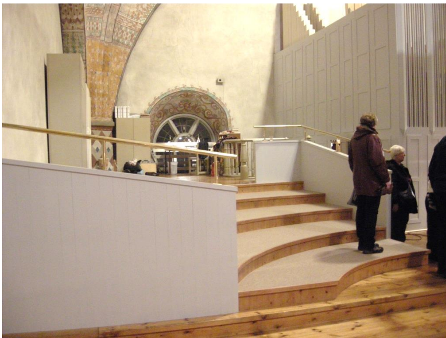
Figur 14. Körplatserna efter färdigställande med trä- och mässingsräcken. Foto från sydöst. Foto: Daniel Olsson, Länsmuseum Gävleborg 2015-02-06.
