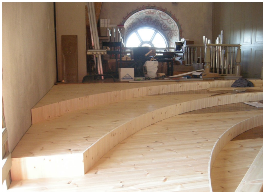
Figur 13. Körplatserna från söder under ombyggnaden. Foto: Daniel Olsson, Läns museet Gävleborg 2014-10-01.
