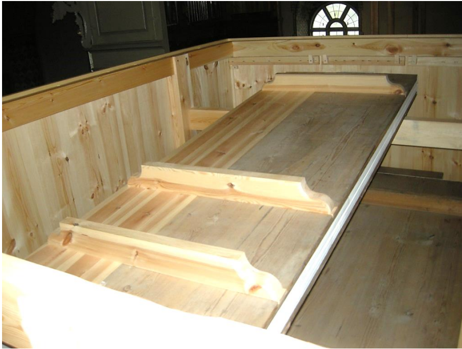
Figur 16. Detalj av en av de tre bälgarna i bälghuset. De två övriga är placerade i bredd under bälgen på bilden. Foto från sydöst. Foto: Daniel Olsson, Länsmuseum Gävleborg 2014-09-24.
