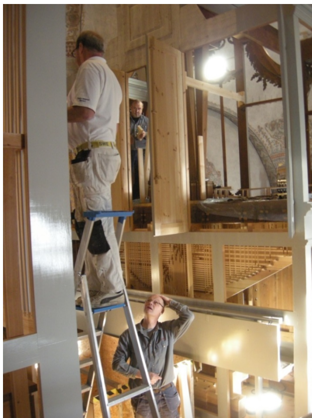
Figur 28. Samordningen av arbetet mellan olika entreprenörer var viktig för att allt skulle fungera i detta projekt där olika arbetsmoment ofta pågick parallellt. Målare Kay Fredriksson samtalar med orgelbyggare Åke Jonsson. Foto från sydväst. Foto: Daniel Olsson, Länsmuseet Gävleborg 2014-11-26.
