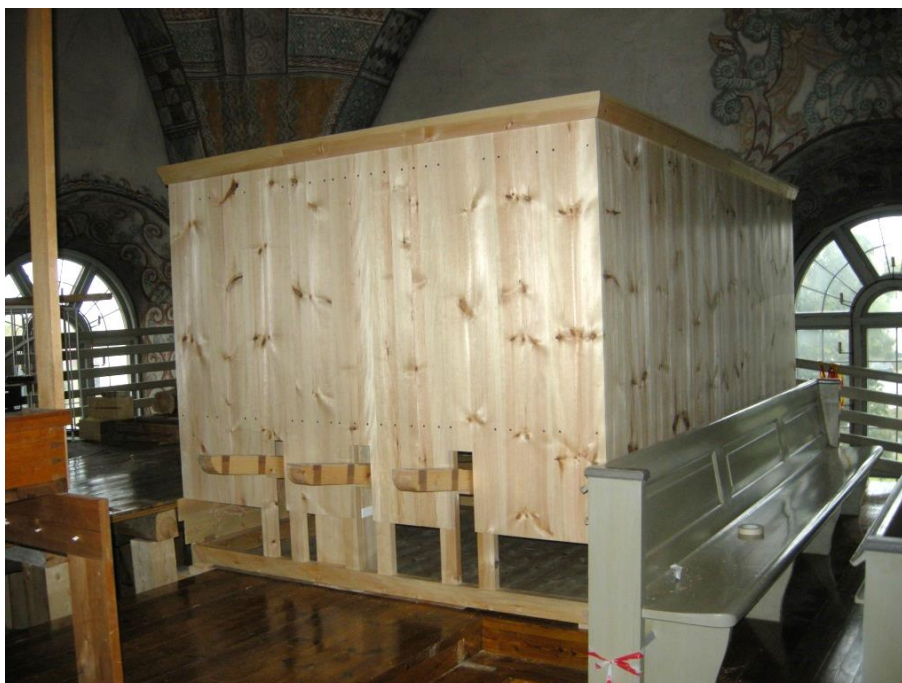
Figur 15. Bälghuset på läktarens nordvästra del innan målning. Notera de tre tramporna som används om bälgarna ska förses med luft manuellt. Foto från sydöst. Foto: Daniel Olsson, Länsmuseum Gävleborg 2014-09-24.
