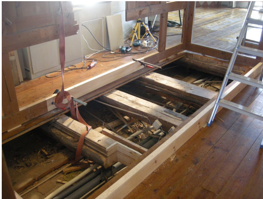
Figur 10. Förstärkningsåtgärder i bjälklaget utförs på platsen där Gren och Stråhles orgelverk ska byggas upp. Foto från nordväst. Foto: Daniel Olsson, Läns museet Gävleborg 2014-05-14.
