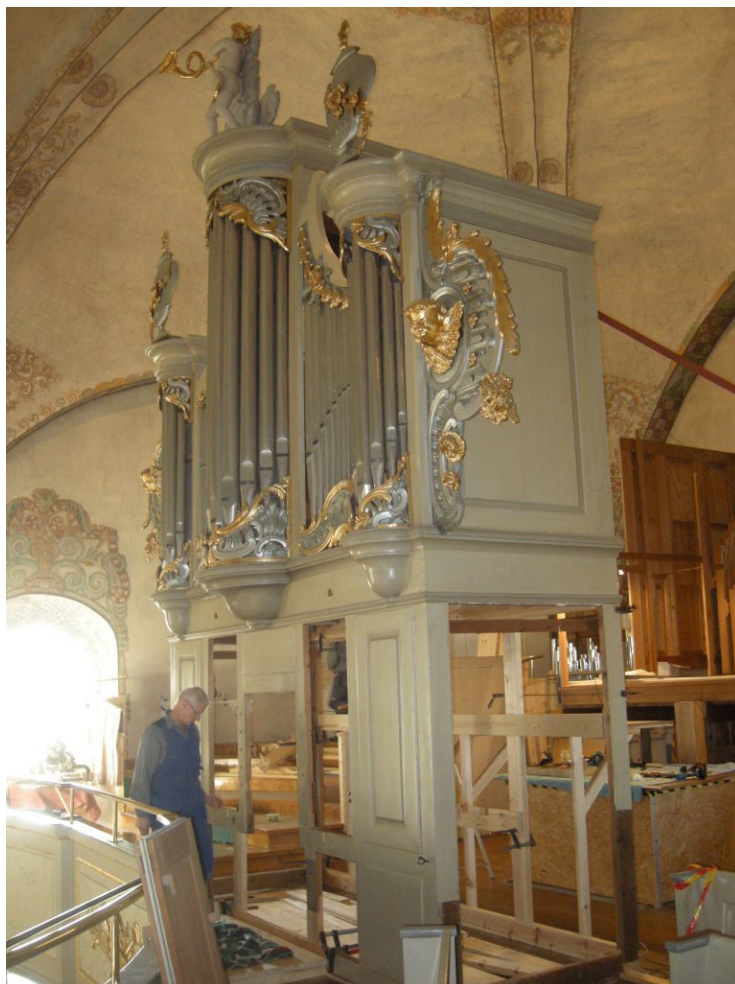
Figur 19. Gren och Stråhleorgeln från nordöst under pågående uppbyggnadsarbete. Foto: Daniel Olsson, Läns museet Gävleborg 2014-10-29.
