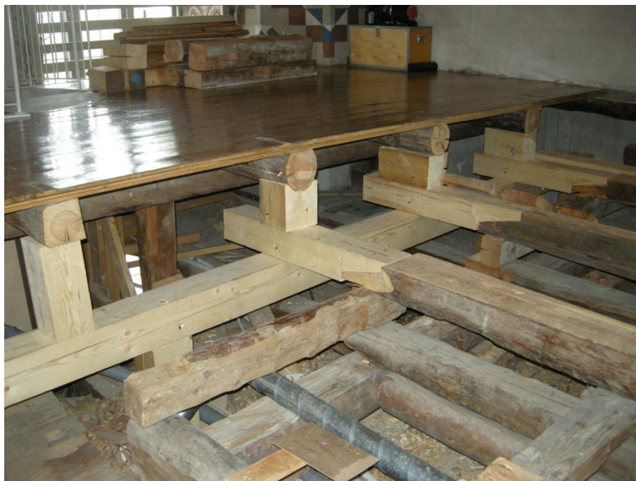
Figur 11. Detalj av ombyggnaden av bjälklagskonstruktionen på platsen för det blivande bälghuset. Foto från sydöst. Foto: Daniel Olsson, Läns museet Gävleborg 2014-08-20.
