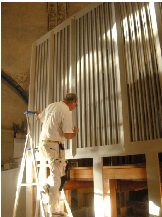
Figur 24. Kay Fredriksson målar Setterquistorgelns nya fasad. Foto från nordöst. Foto: Daniel Olsson, Läns museet Gävle 2014-11-26.
