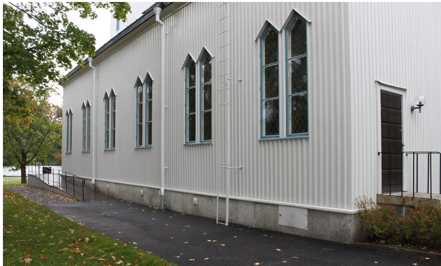
Figur 16. Kyrkans södra långsida. Här syns stegen som är målad i samma kulör som fasaden. I samband med renoveringen togs flera stegpinnar bort längst ner, detta för att förhindra att obehöriga ska ta sig upp på kyrkans tak. 2018-09-10.
