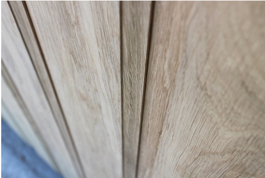
Figur 28. Profil på dörrpanel i ek. 2018-05-18.
