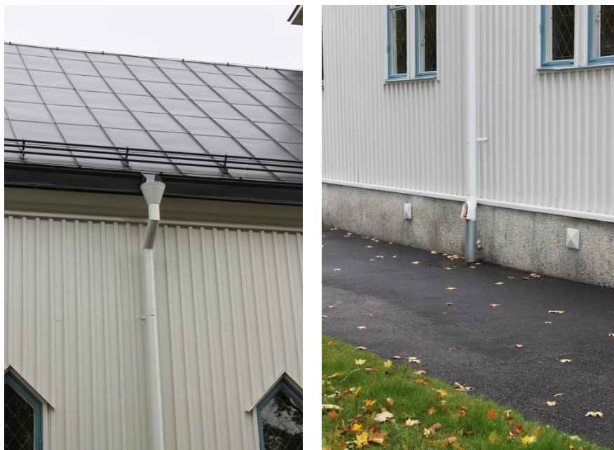
Figur 12 och 13. Nya stuprör med skarpa vinklar, samt anslutningen till dagvatten på den södra sidan. Här syns också de nymålade träpluggarna för kattluckorna i sockeln. 2018-09-10.
