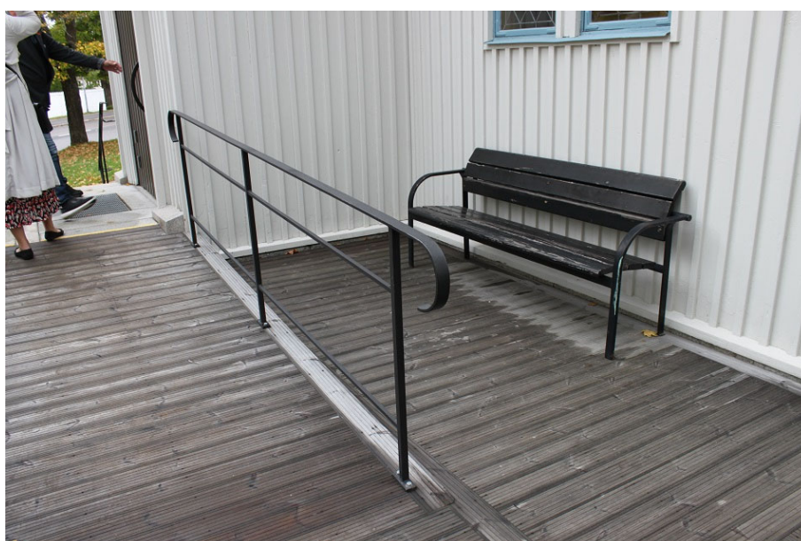
Figur 23. Strömsbro kyrka vid slutbesiktningen 2018-09-10. Mot långhusets västra fasad har skapats en plan yta i rampen, där en bänk inbjuder till vila.
