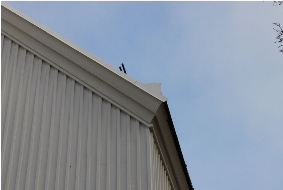
Figur 9. Utförande på gavellist/vindskiva på tillbyggnadens norra gavel. 2016-10-16.
