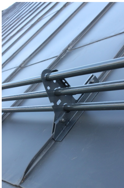
Figur 7 och 8. Ny skorstenshuv samt närbild på snörasskydd och dess infästning. 2016-09-10 och 2016-09-19.
