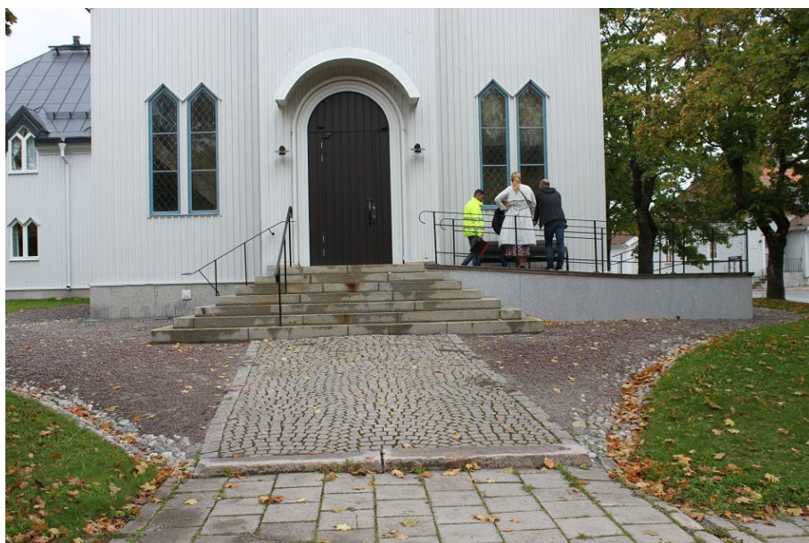
Figur 21. Strömsbro kyrka vid slutbesiktningen 2018-09-10. Det nya smidesräcket i trappan är på plats. Placeringen av detta är vald utifrån dörrbladets position i helt öppet läge.
