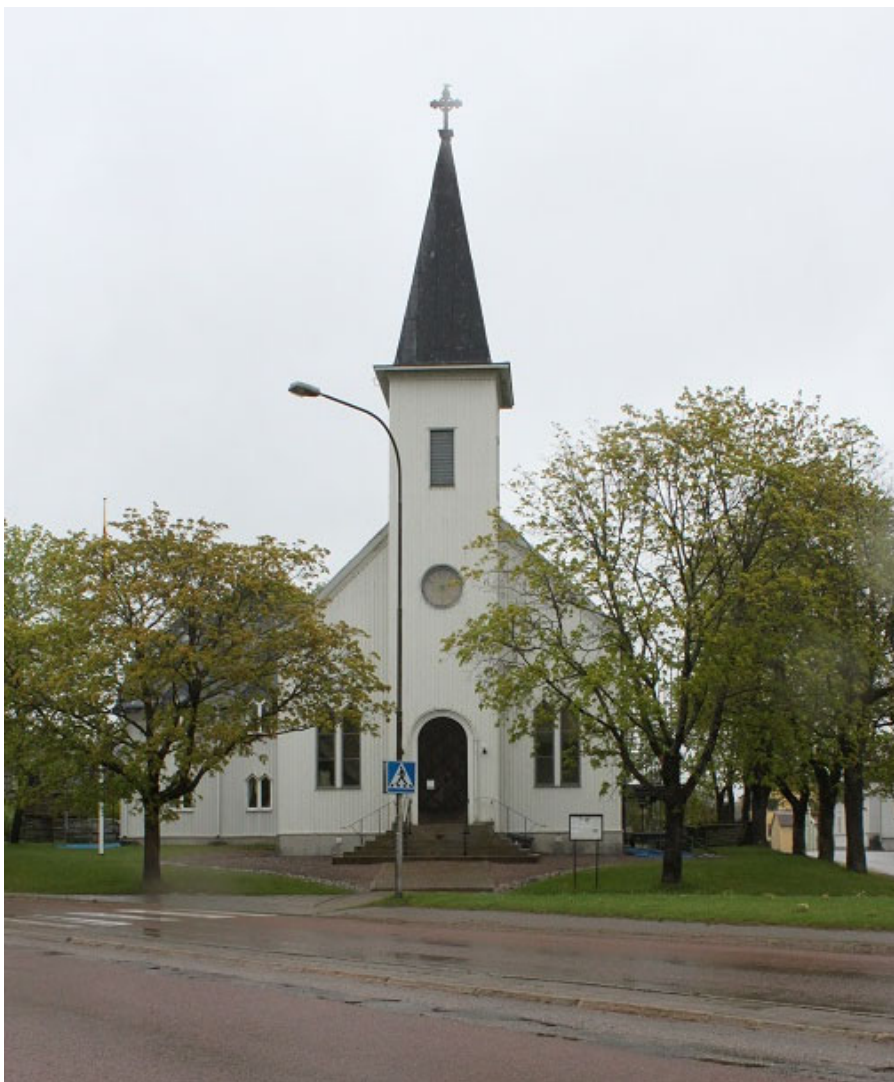
Figur 3. Strömsbro kyrka innan påbörjade arbeten, 2016-15-16.
