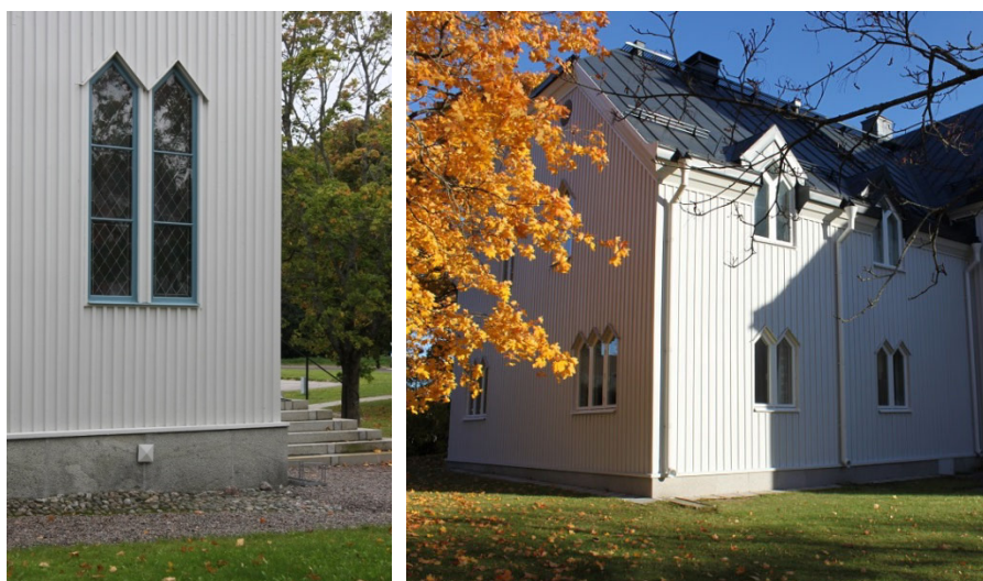
Figur 14 och 15. Nymålade fönster på tornets norra sida samt på tillbyggnaden. 2018-09-10 och 2018-10-10.
