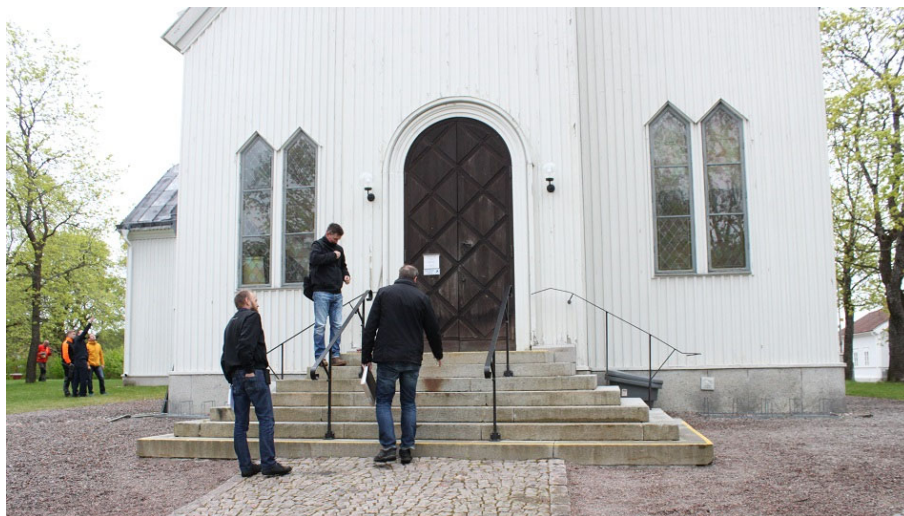
Figur 17. Strömsbro kyrka innan påbörjade arbeten. 2016-05-13.
