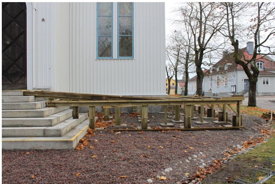
Figur 20. Arbetet med rampen är påbörjat. 2016-10-26.
