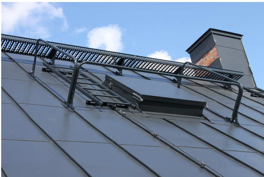
Figur 6. Den nya takluckan på det södra takfallet, samt säkerhetsräcke och takbrygga mot skorstenen. 2016-09-19.
