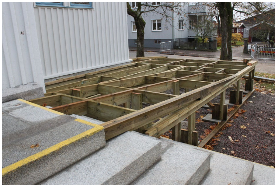
Figur 19. Arbetet med rampen är påbörjat. 2016-10-26.
