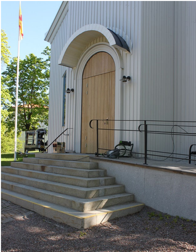
Figur 27. Det nya entrépartiet, liksom entrétak och väggarmaturer, är monterade. Återstår målning, handtag och räcke i trapploppet rakt ut från porten. 2018-05-18.
