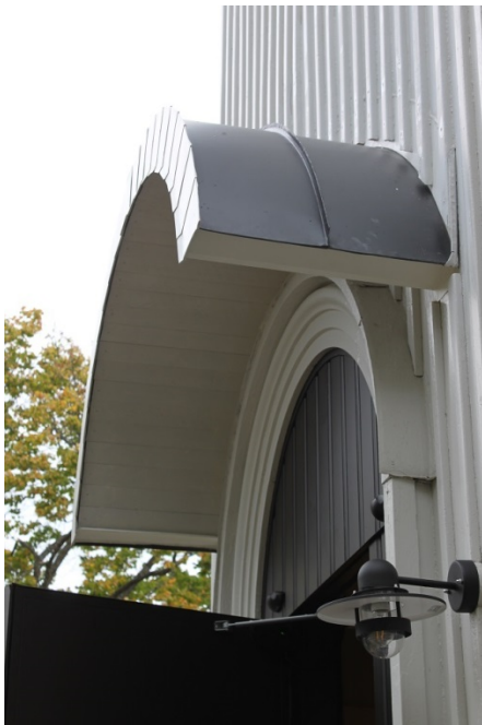
Figur 29 och 30. Entrétak, väggarmaturer samt det nya handtaget. 2018-09-10.
