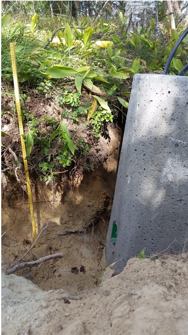
Vid utbytet av fundamenten till lyktstolparna grävdes cirka en meter djupa schakt. Foto: Frida Löjdström, taget från sydväst.
