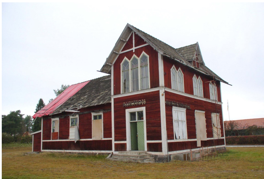
Figur 33. Ordenshuset i Västaby i Sandviken före renovering av yttertak och fönster. Foto: Anna Lindgren, Läns museet Gävleborg 2003-10-29.
