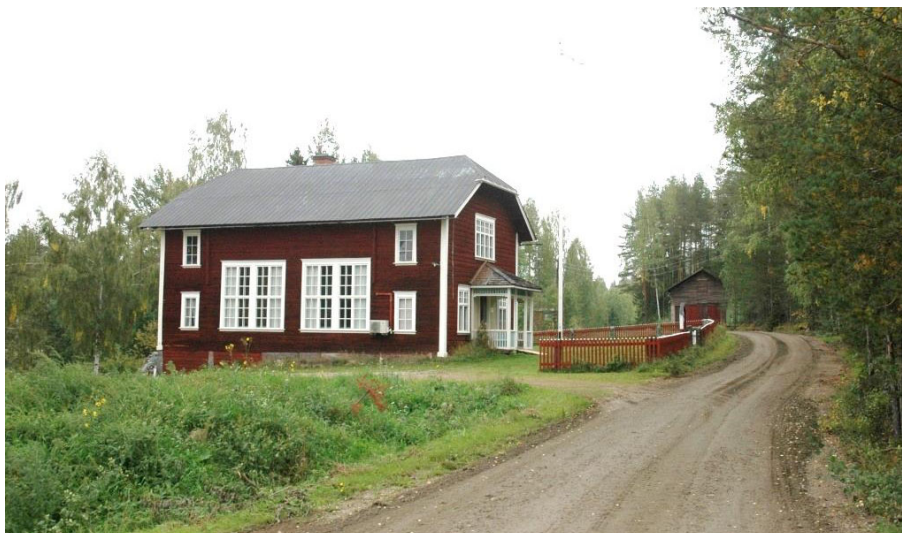
Figur 2. Godtemplarhuset från sydväst. Foto: Daniel Olsson, Länsmuseet Gävleborg 2018-09-06.
