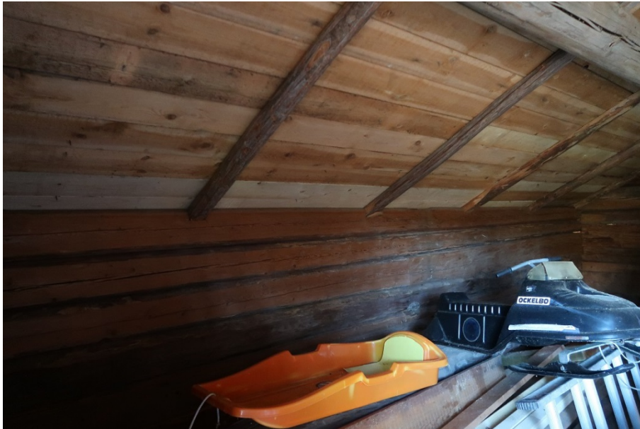
Figur 6. Det norra takfallet inifrån, med ilagad takpanel. 2018-10-24.
