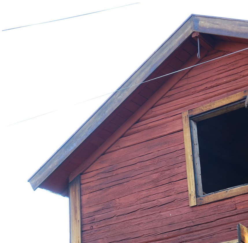
Figur 8. Nya vind- och vattskivor har strukits med roslagsmahogny. 2018-10-24.
