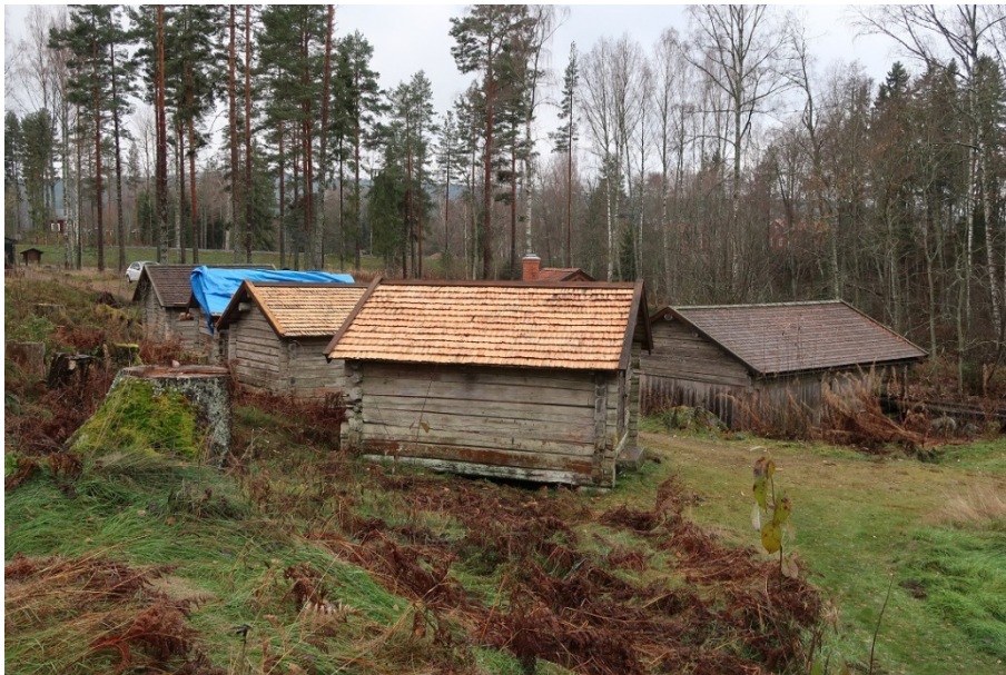
Figur 6. Två tak är helt omlagda, arbete sker på det tredje. 2018-10-31.
