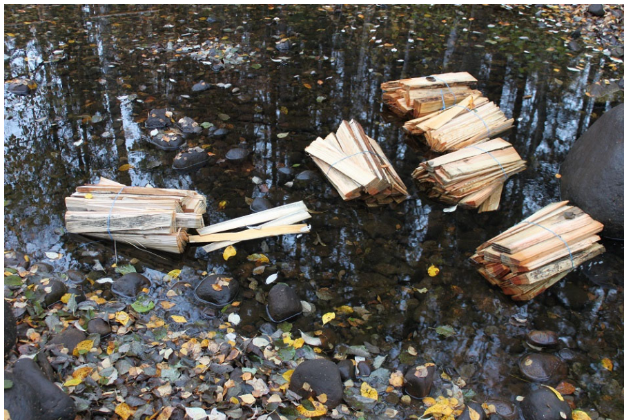
Figur 3. Spånen återfuktades i ån inför läggning. 2018-10-17.
