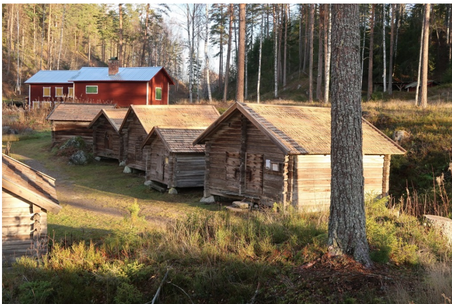
Figur 9. De fem bodarna efter avslutade arbeten. Bodarna syns från söder. 2018-11-16.
