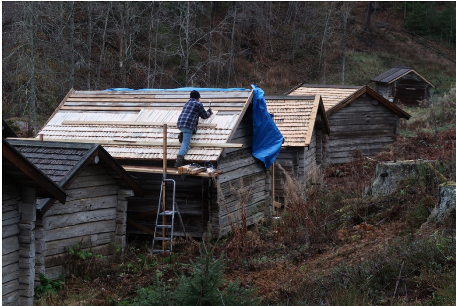
Figur 5. Omläggning pågår på den tredje boden. Lennart Stahre jobbar på taket. 2018-10-31.
