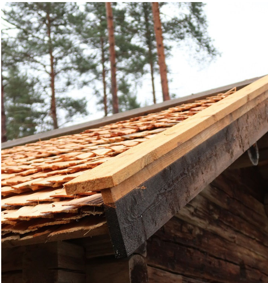
Figur 7. Här syns hur en befintlig vindskiva skarvats i för att passa den tjocklek som de nya späntade spånen bygger. 2018-10-31.
