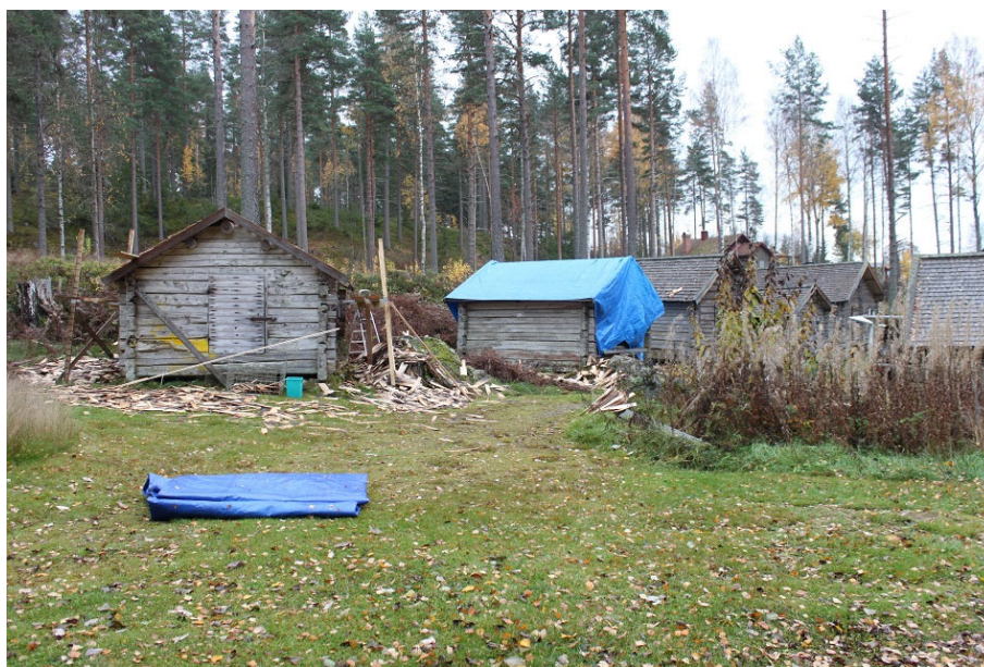
Figur 2. Arbetet med omläggning av spåntaken på de fem förrådsbyggnaderna är igång, 2018-10-17. Till höger skymtar spåntaket på den större förrådsbyggnaden där taket lades om 2017.
