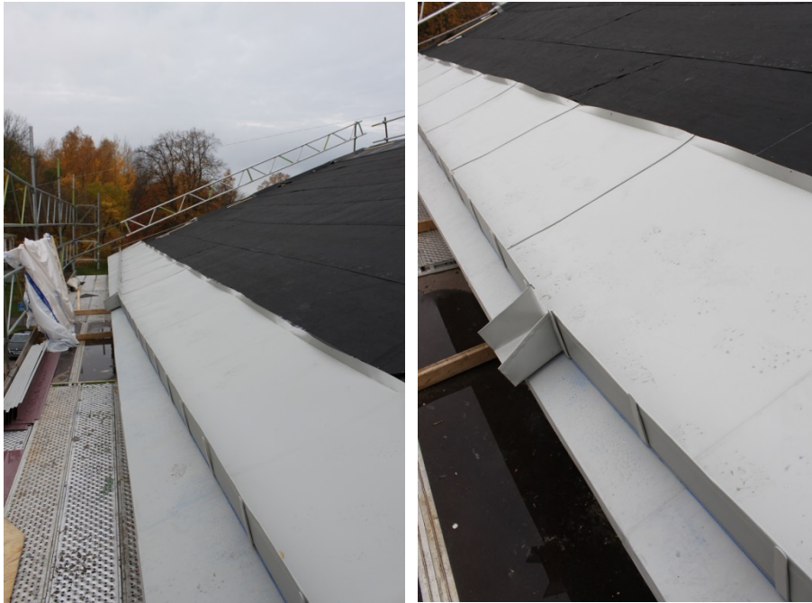
Figur 6. Fotplåten och fotrännan är på plats. Foto: 2018-10-17.
