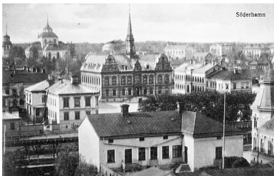
Figur 2. Vykort från början av 1900-talet, med Pantern 6 främst i bild. Det är de tre takfallen som syns i bild, som försetts med ny plåttäckning inom detta projekt. Foto: Reprofoto i Läns museet Gävleborgs bildsamling, efter vykort i Söderhamns museiförlags arkiv.
