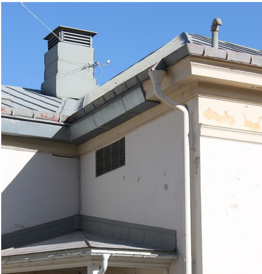
Figur 4. Här syns den i senare tid tillkomna plåtinklädnaden av takfoten mot söder. På takfallet syns en av de två ventilationspiporna som inom detta projekt flyttats högre upp på takfallen. I vänstra bildkanten skymtar en av två takluckor, vilka båda nu är borttagna.
