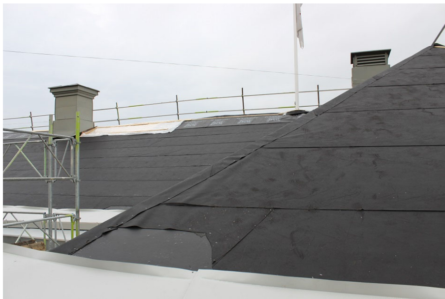
Figur 5. Under pågående arbeten. Den tidigare plåten är avriven och takfallen är täckta med plyfa och underlagsduk. Foto: 2018-10-17.
