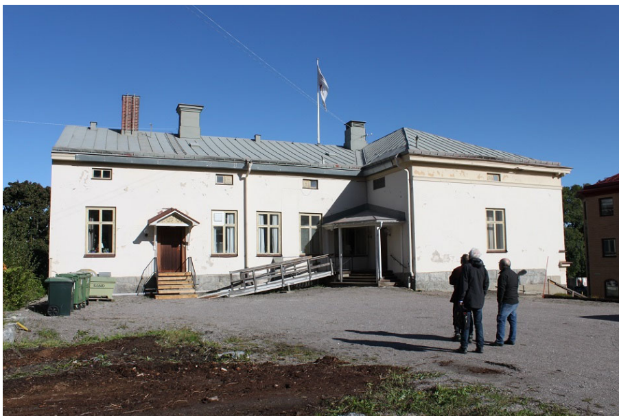
Figur 3. Pantern 6 sedd från gården mot söder, innan påbörjade arbeten. Det är de tre takfallen som syns i bild, som inom detta projekt försetts med ny plåttäckning. Foto: 2018-09-12.
