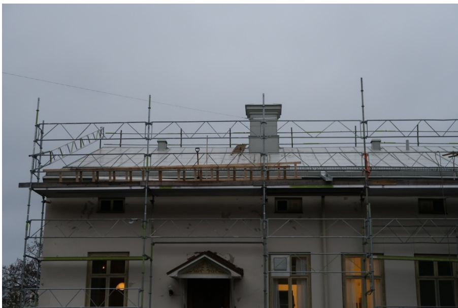
Figur 8. De två takluckorna som fanns på det stora takfallet har tagits bort. En liten ventilationspipa syns till höger i bild. Den har flyttats upp på takfallet inom detta projekt, efter att ha varit placerad närmare takfoten tidigare. Foto: 2018-11-30.
