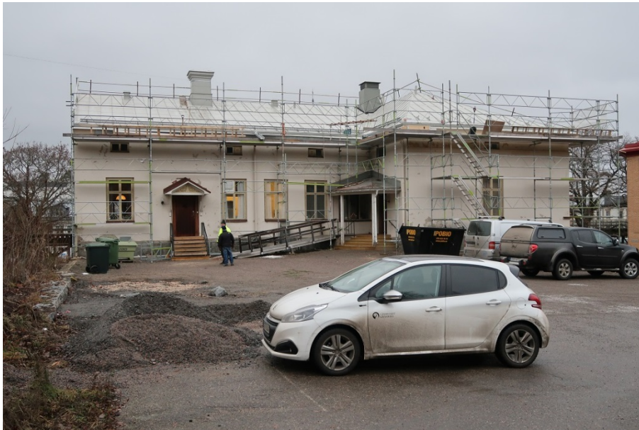
Figur 7. Den södra sidan vid slutbesiktningen. Vissa arbeten kvarstod här, som beslag kring den östra skorstenen, och målning av den samma. Vattkupor och stuprör skulle monteras efter att ställningarna tagits ner. Foto: 2018-11-30.
