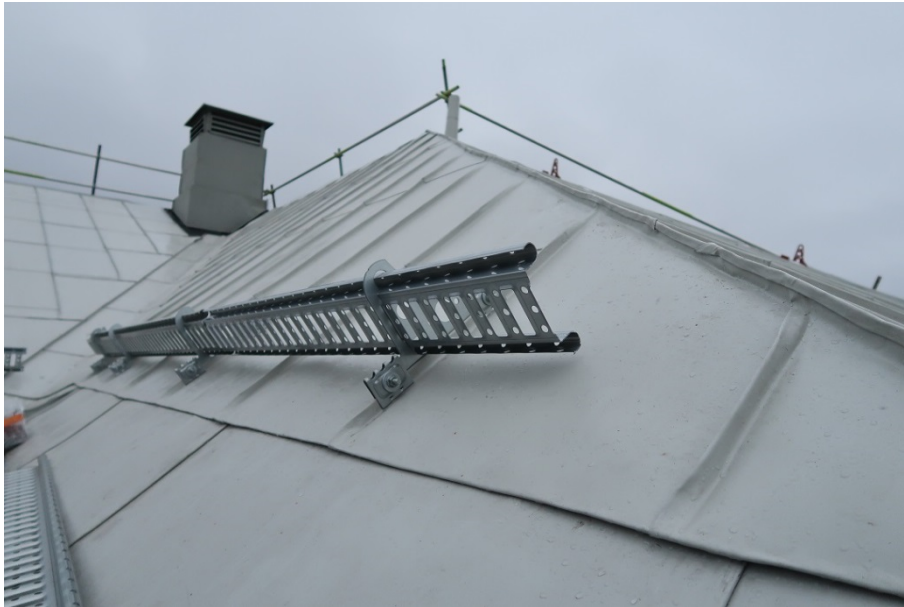
Figur 10. Närbild på ett av snörasskydden. Foto: 2018-11-30.
