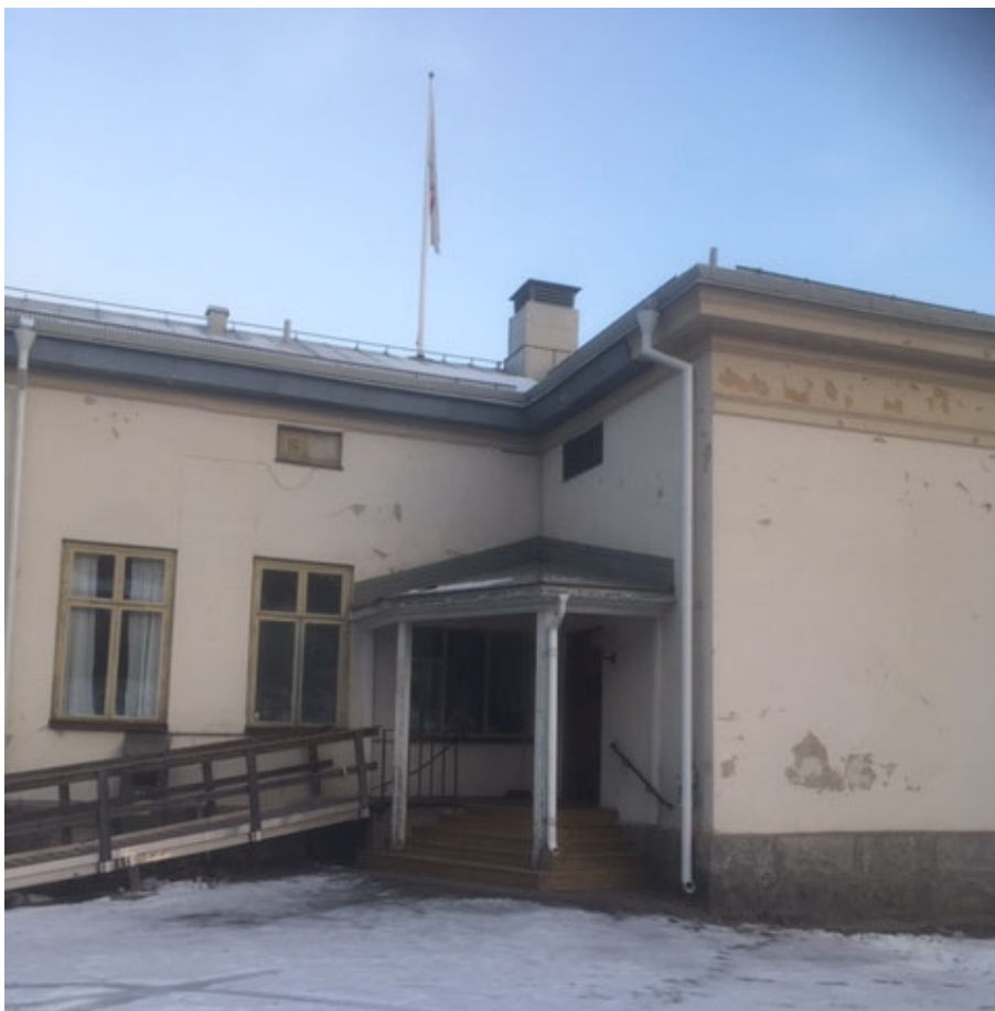
Figur 12. Ställningen är riven. Nya vattkupor och stuprör har monterats. Den östra skorstenen ska målas till sommaren 2019. Foto: Björn Lindqvist, Odd Fellow, 2019-01-03.
