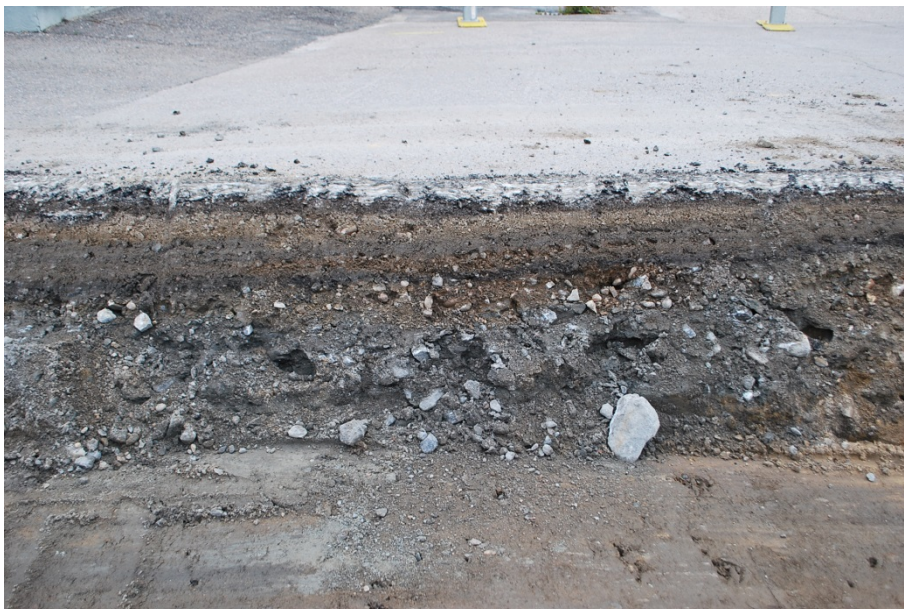
Figur 4. Del av schaktets nordöstra sida där sektion 2 dokumenterades. Sett från väster. Foto: Inga Blennå.
