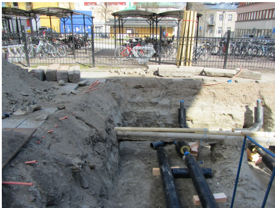
Bild 10. Grävning för rörnedläggning i Rådmangatan. Här var endast påförda fyllnadsmassor direkt på det naturliga sandlagret.
