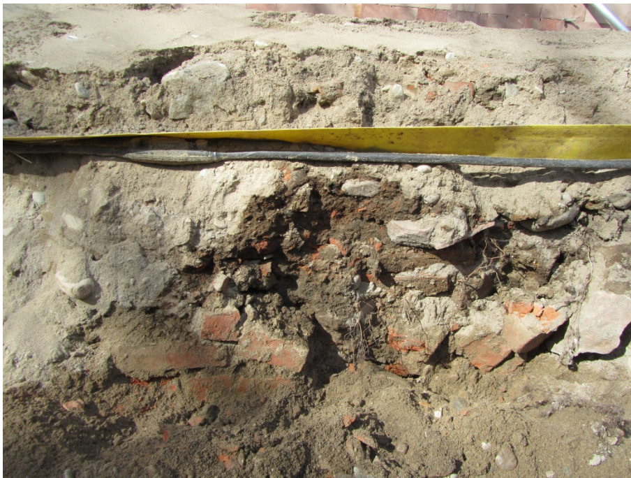
Bild 6. A1 tegelkonstruktionen under framrensning.
