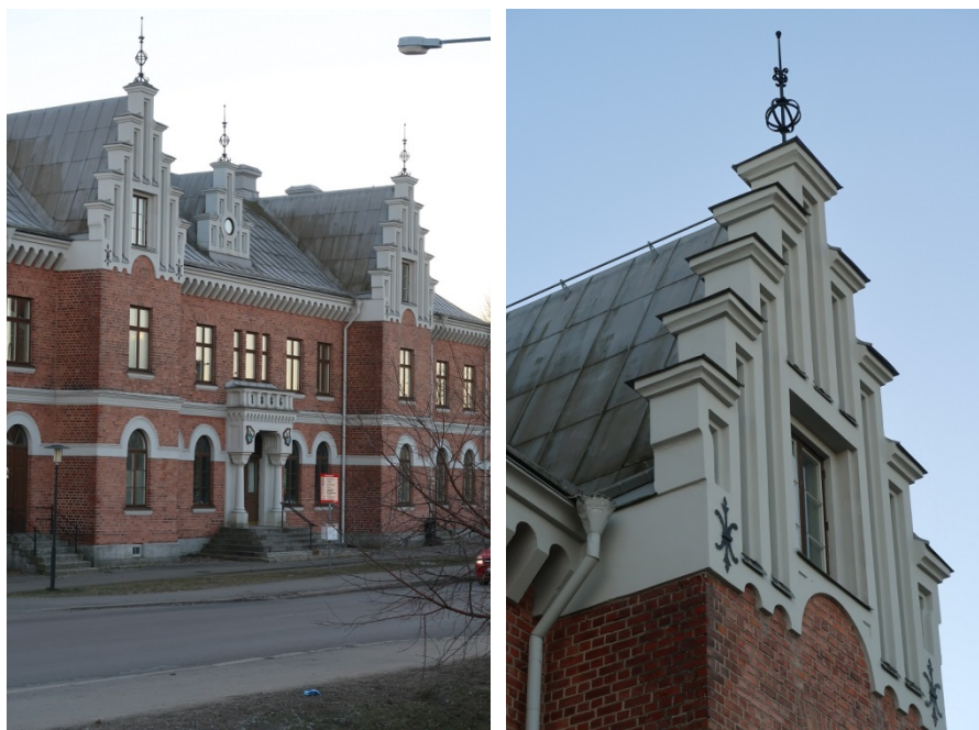
Figur 6 och 7. Prydnadsgavlarna mot norr efter avslutade arbeten. Foto: Ulrika Olsson, Länsmuseet Gävleborg, 2018-11-22.
