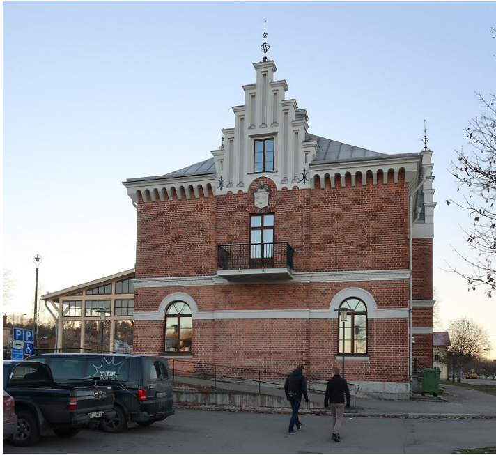
Figur 8. Den östra prydnadsgaveln efter avslutade arbeten. Foto: Ulrika Olsson, Länsmuseum Gävleborg, 2018-11-22.
