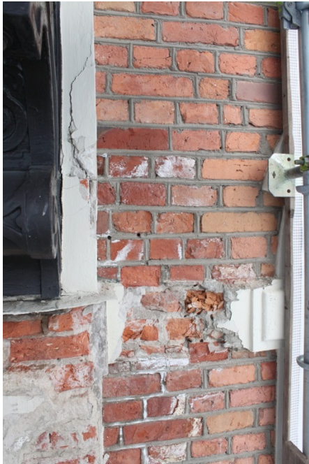
Figur 4. Exempel på murverks- och putsskador i anslutning till balkongen. Foto: Ulrika Olsson, Läns museet Gävleborg, 2018-03-01.
