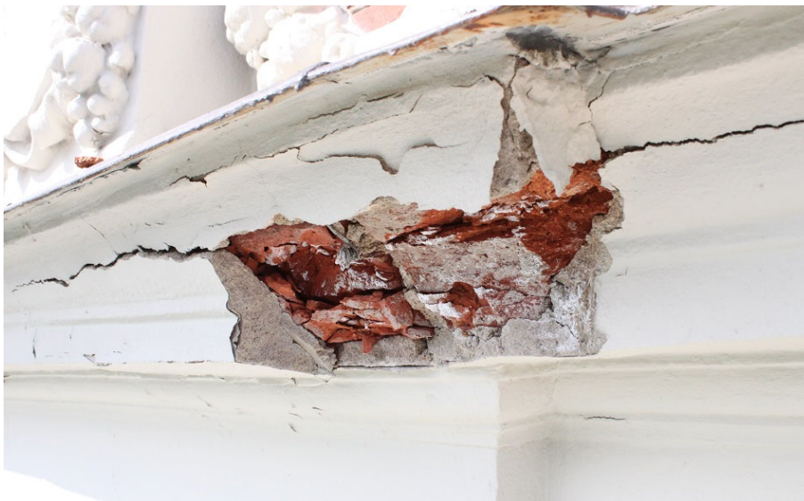
Figur 4. Exempel på murverks- och putsskador i anslutning till balkongen. Foto: Ulrika Olsson, Läns museet Gävleborg, 2018-03-01.
