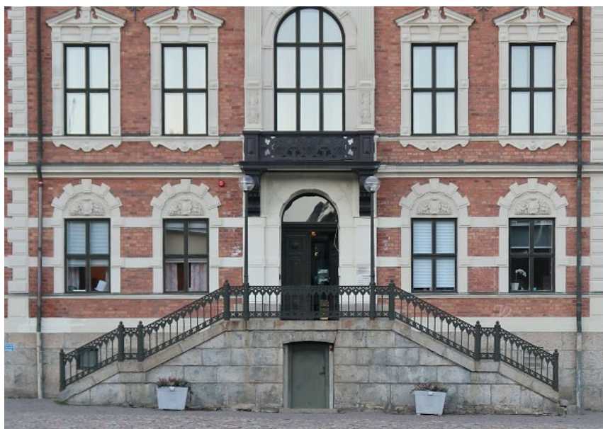
Figur 13. Huvudentrén med ovanliggande balkongparti vid avslutade arbeten. Foto: Ulrika Olsson, Läns museet Gävleborg, 2018-11-22.
