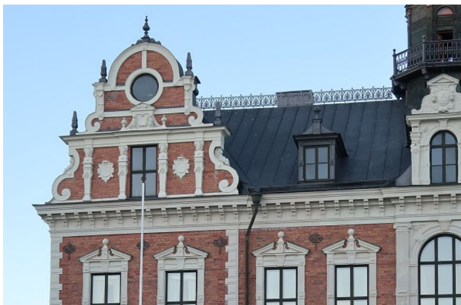
Figur 15. Slutbesiktning. Prydnadsgavel mot sydväst. Foto: Ulrika Olsson, Läns museet Gävleborg, 2018-11-22.
