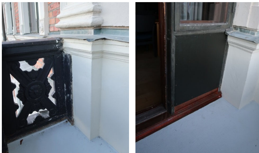
Figur 11 och 12. Slutbesiktning. En ny balkongplatta är gjuten, skadat mur- och putsverk upplagat. Nya skivor är monterade kring dörrpartiet. Plåttäckningar mot balkongplattan består av kopparplåt. Foto: Ulrika Olsson, Läns museet Gävleborg, 2018-11-22.
