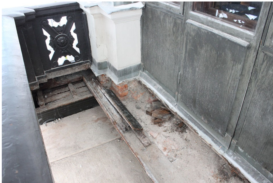
Figur 9. Balkongplattan är uppbilad och stål och balkar håller på att friläggas. Foto: Ulrika Olsson, Läns museet Gävleborg, 2018-03-01.
