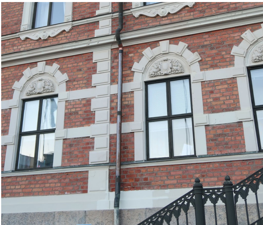
Figur 20. Slutbesiktning. Stupröret närmast väster om huvudentrén mot söder, har bytts ut till nytt kopparrör i höjd med mittlist och ner. Foto: Ulrika Olsson, Läns museet Gävleborg, 2018-11-22.
