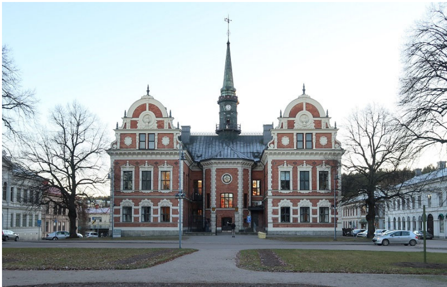
Figur 17. Slutbesiktning. Söderhamns rådhus från norr. Foto: Ulrika Olsson, Läns museet Gävleborg, 2018-11-22.
