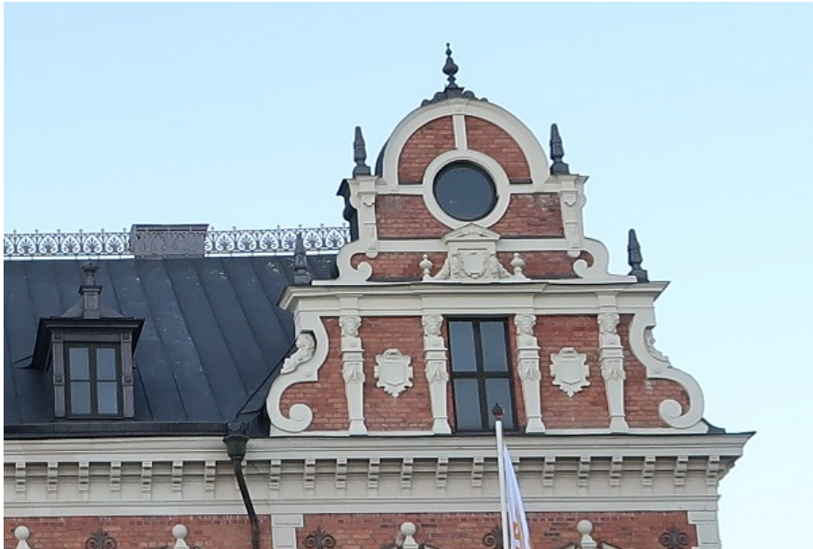
Figur 16. Slutbesiktning. Prydnadsgavel mot sydöst. Foto: Ulrika Olsson, Läns museet Gävleborg, 2018-11-22.
