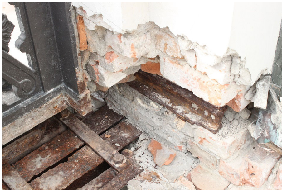
Figur 10. Ståldelarna är demonterade och skadat murverk är borthugget. Foto: Ulrika Olsson, Läns museet Gävleborg, 2018-04-20.
